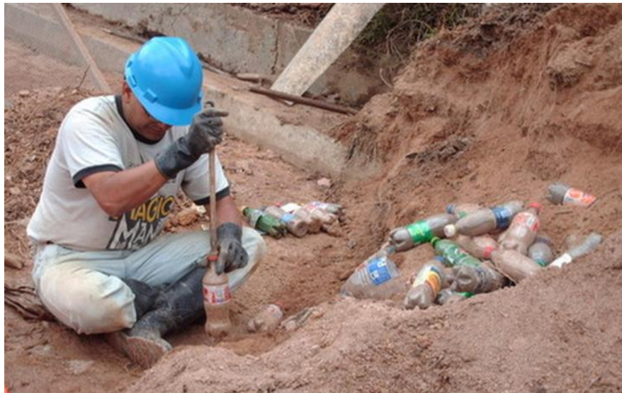
Figura 2. Llenado de las botellas plásticas
