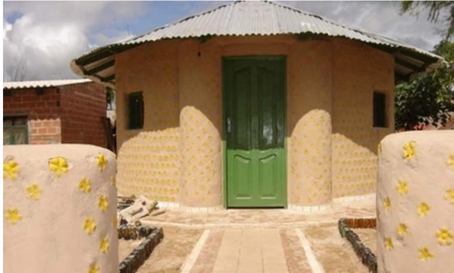
Figura 3. Vivienda construida con botellas plásticas
