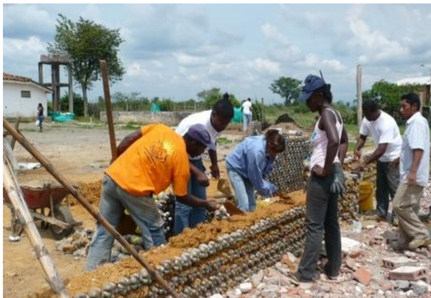
Figura 5. Proceso Construcción del Muro – Autoconstrucción.
