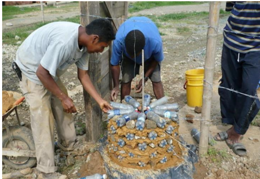
Figura 1. Construcción columnas con botellas plásticas
