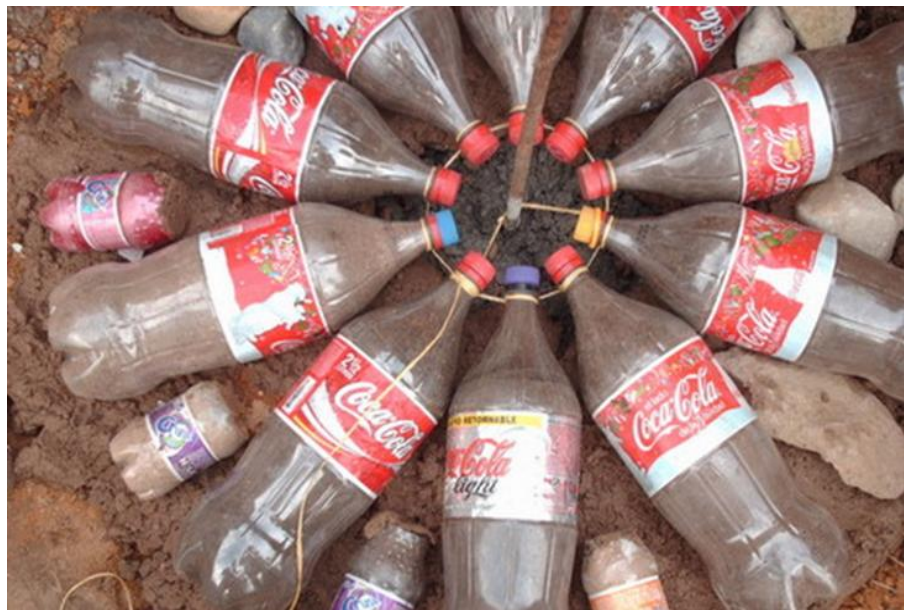
Figura 4. Amarre con nylon de botellas plásticas formando una columna.
