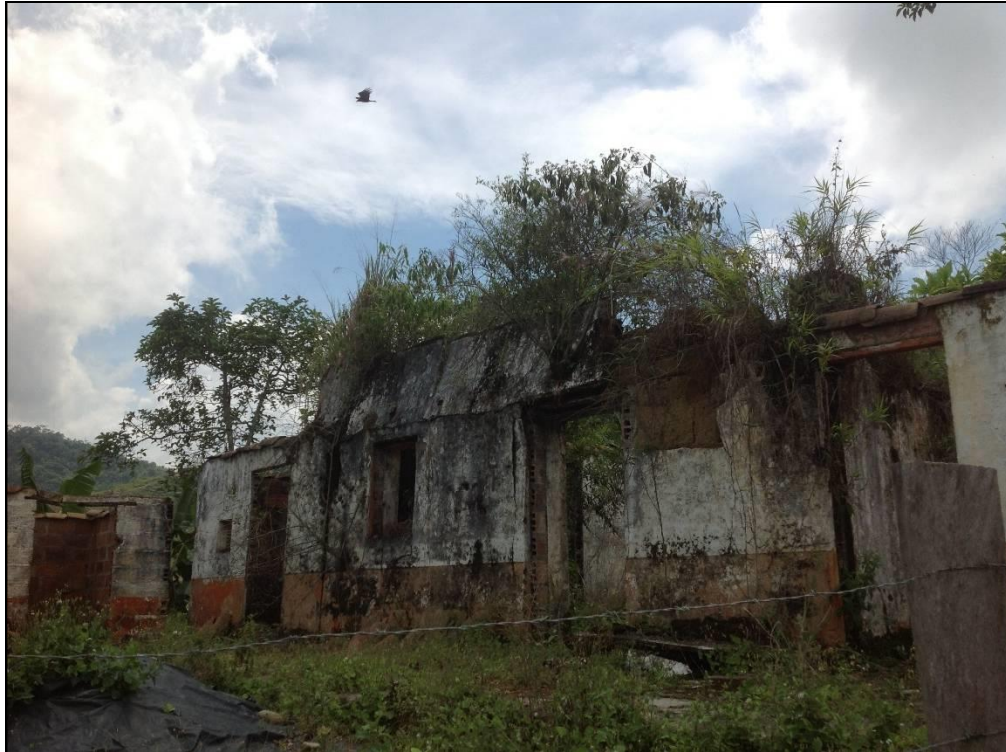
Imagen 1. Casa abandonada en el centro zonal El Chocó municipio de San Carlos. Fotografía tomada el 28 de febrero de 2013
