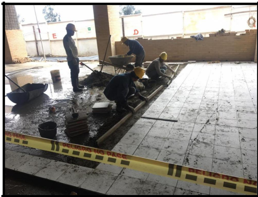
Ilustración 386. Instalación Piso - ALFA
