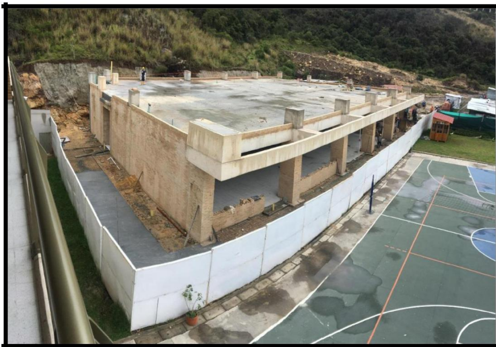
Ilustración 375. Obra Comedor - Colegio Cumbres Diciembre 2
