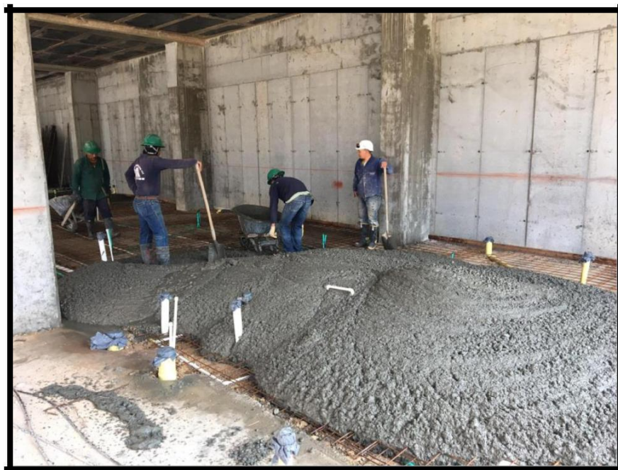
Ilustración 21. Fundida Placa Contrapiso
