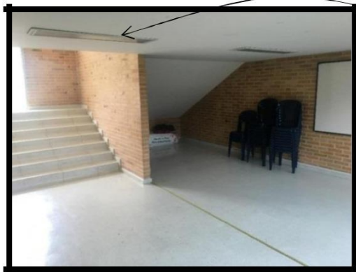
Ilustración 27. Salón Audiovisuales - Edificio Bachillerato
