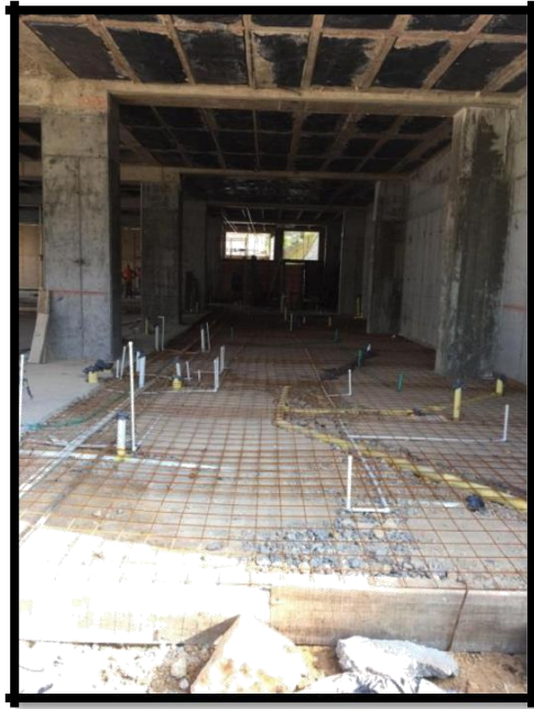
Ilustración 20. Red Hidrosanitaria, Red de Incendio y Red de Gas en obra.
