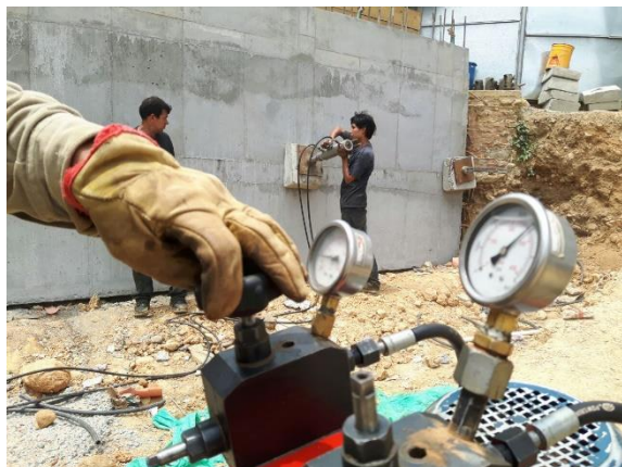
Figura 13. Tensionamiento de anclaje Fuente: propia
