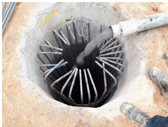
Figura 8. Fundida caisson Fuente: propia
