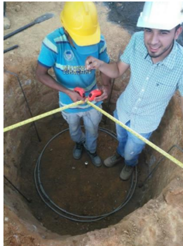
Figura 5. Centrando caisson Fuente: propia
