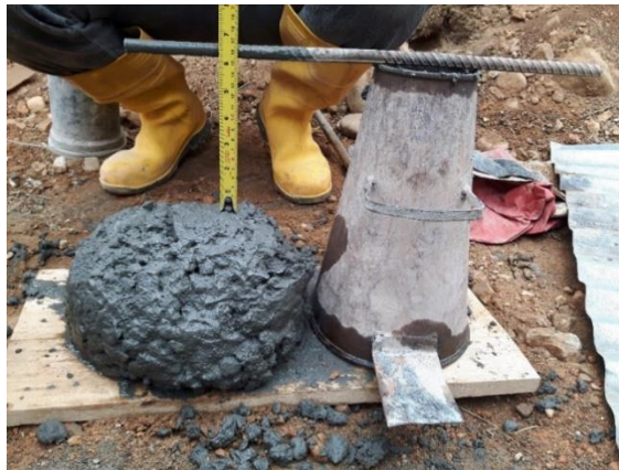
Figura 7. Prueba de slump Fuente: propia
