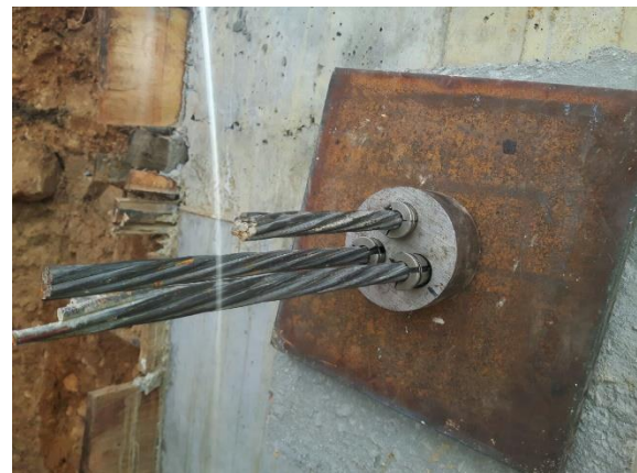
figura 14. Anclaje activo fuente: propia
