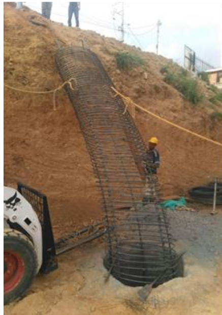
Figura 4. Canasta de acero caisson Fuente: propia
