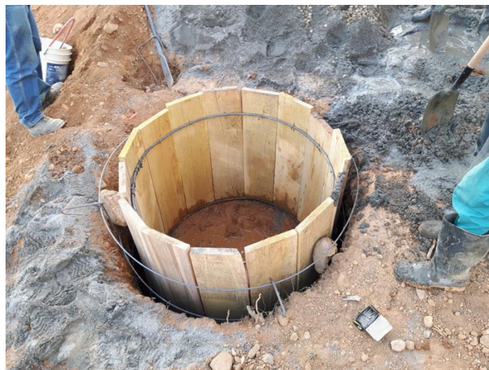
Figura 3. Caisson 1 metro excavado Fuente: propia
