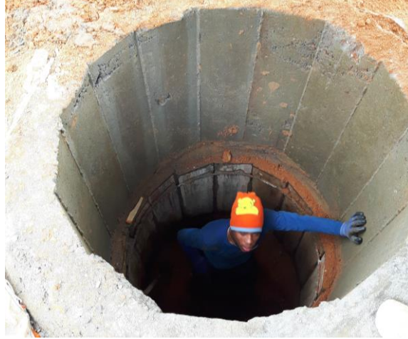
Figura2. Anillos de protección de caisson Fuente: propia
