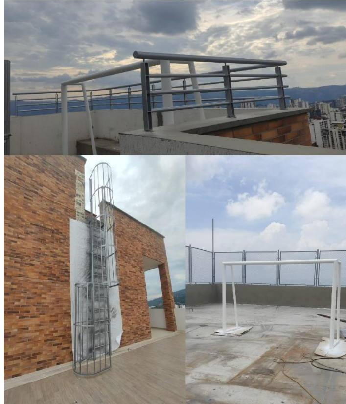
Figura 13. Trabajos completados y revisados.
