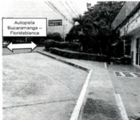
Fotografías No. 4 y 5: Andenes aledaños al acceso vehicular al conjunto residencial, no se aprecia instalación de loseta texturizada guía ni loseta texturizada guía de alerta ni franja demarcadora visual
