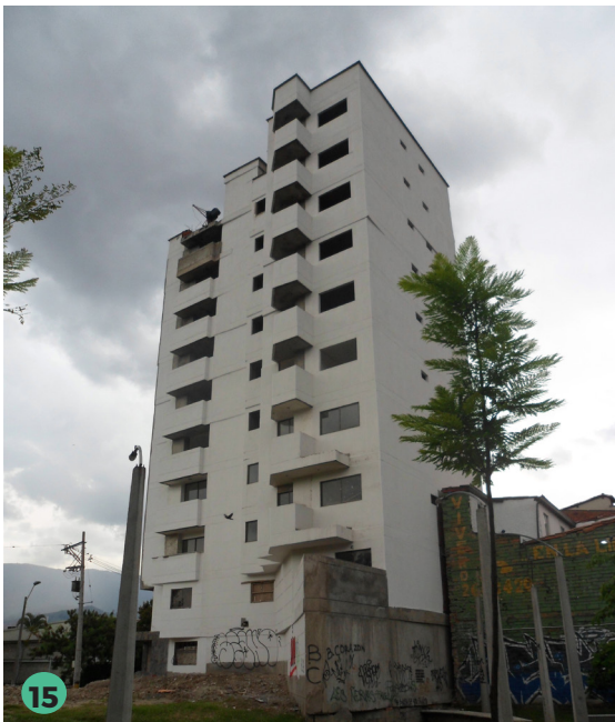
FIGURA 57. (15) EDIFICIO. CARRERA 68#44B-227. FUENTE PROPIA.JPG. FECHA11/04/2017.
