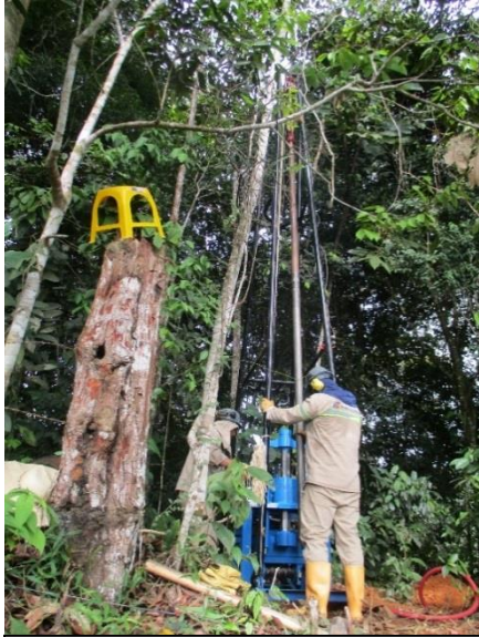
Figura No. 28: Perforación en Rotación
