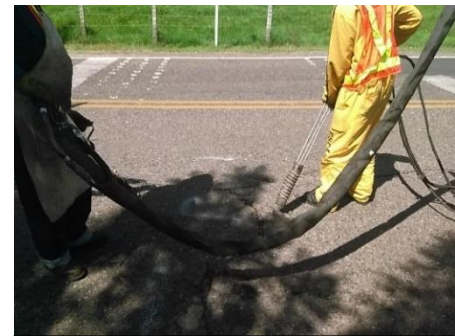
Figura No. 17: Sello de Grietas 2
