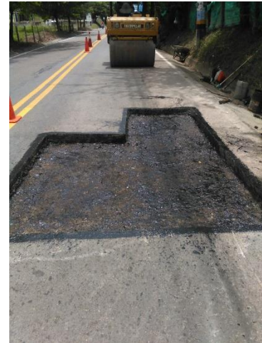
Figura No. 12: Imprimación
