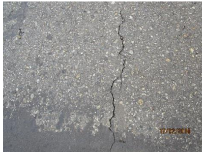
Figura No. 2: Fisura Longitudinal
