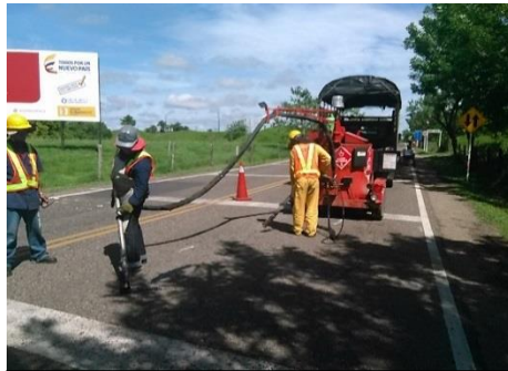
Figura No. 16: Sello de Grietas 1
