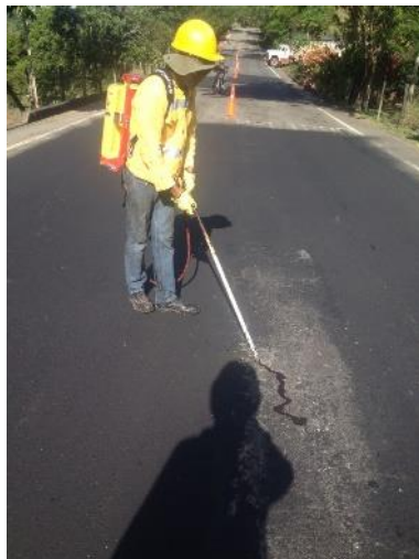
Figura No. 15: Sello de Fisuras
