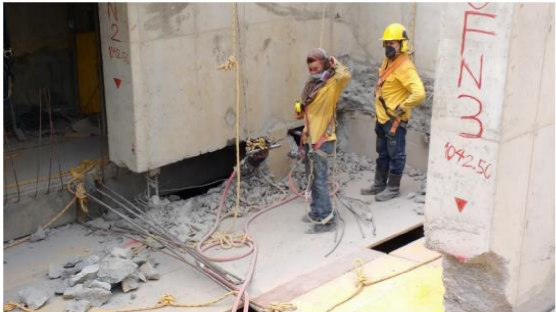
Figura 15. Demolición del contrafuerte Norte del Sótano 2
