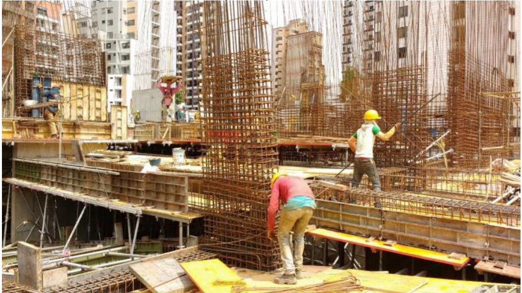
Figura 20. Armado de rampa Sur, placa inclinada y plana del piso 2
