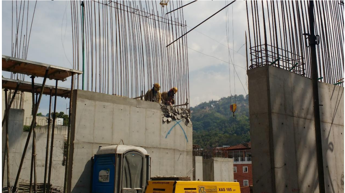
Figura 29. No conformidad 005. Demolición de la pantalla tipo 9 del Sótano 1
