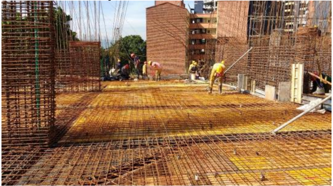
Figura 24. Fundida de la placa del piso 3
