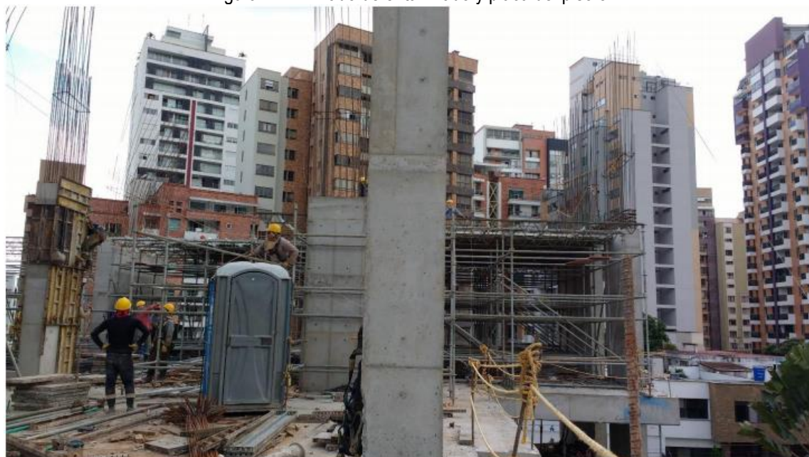
Figura 27. Armado de entarimado y placa del piso 5
