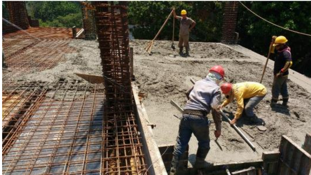
Figura 21. Fundida de placa inclinada del piso 2
