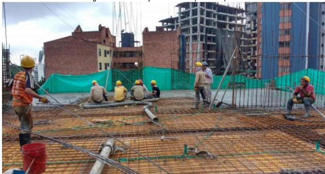
Figura 26. Armado y fundida de la placa del piso 4
