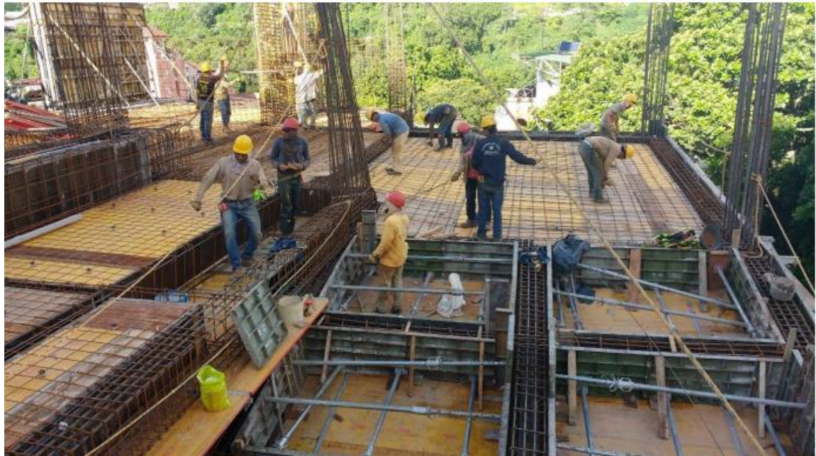
Figura 25. Armado de placa inclinada y rampa del piso 3
