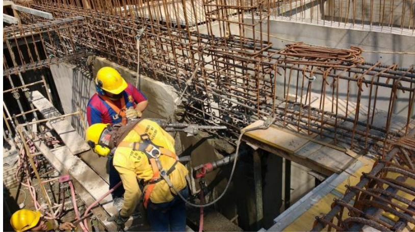
Figura 42. Demolición de la sección afectada del foso del ascensor del piso 1
