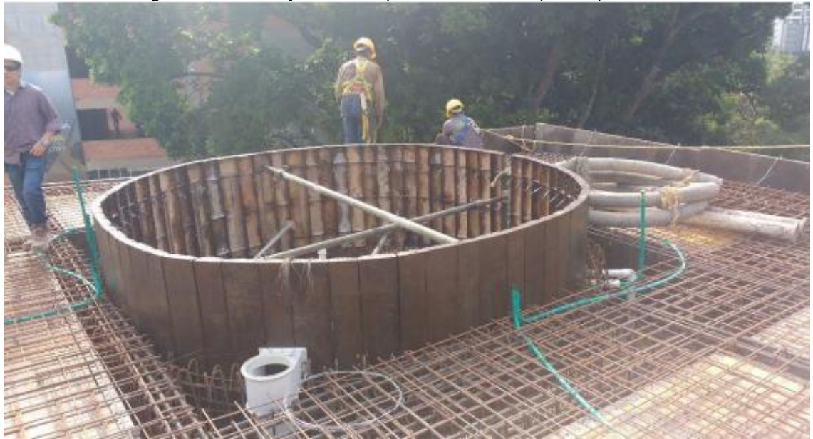
Figura 18. Armado y fundida de placa en la zona de piscina para niños
