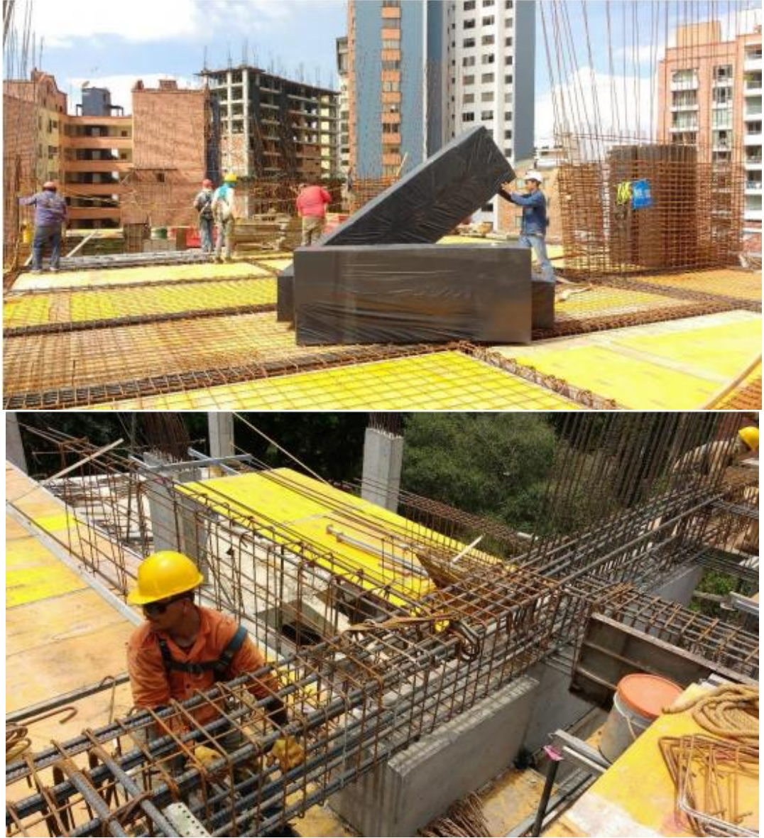
Figura 23. Armado de la placa del piso 3
