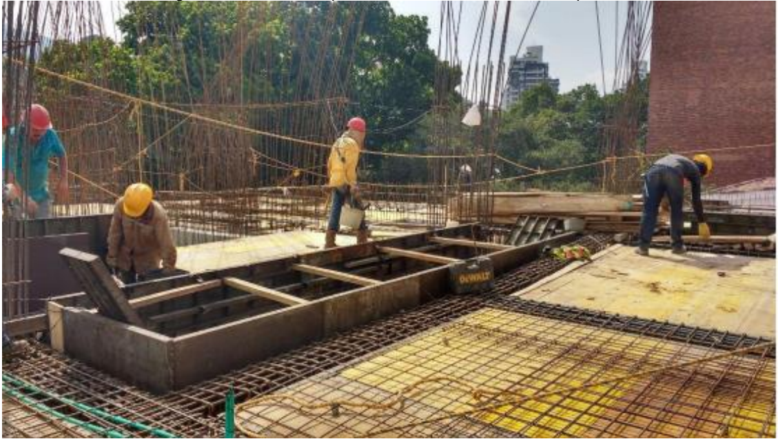
Figura 16. Armado de placa costado Nor-occidental del piso 1
