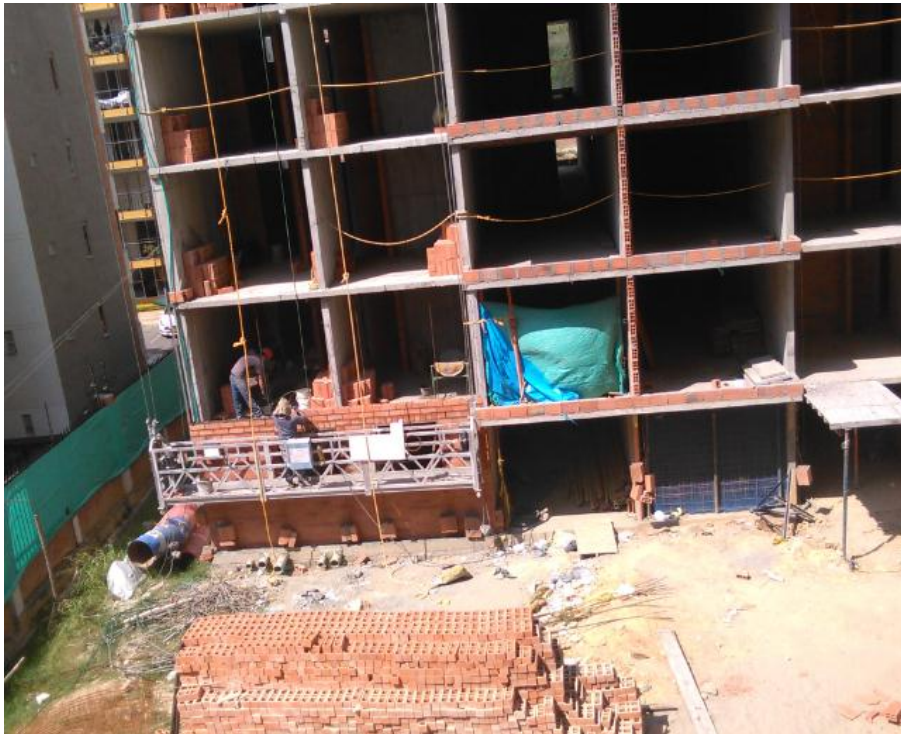
Figura 21: Mampostería de fachada.
