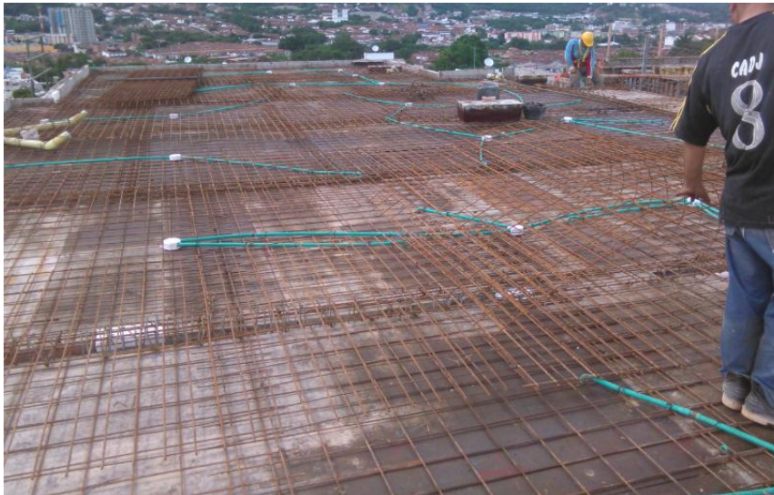
Figura 11: Armado de placa de cubierta. Allí se tiene en cuenta para la revisión los calibres, dimensiones, separaciones y traslapos.
