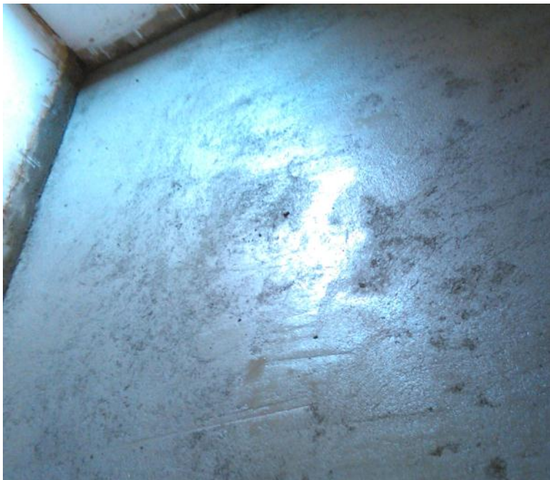
Figura 23: Mortero de nivelación después de la prueba hecha por parte de Cemex.
