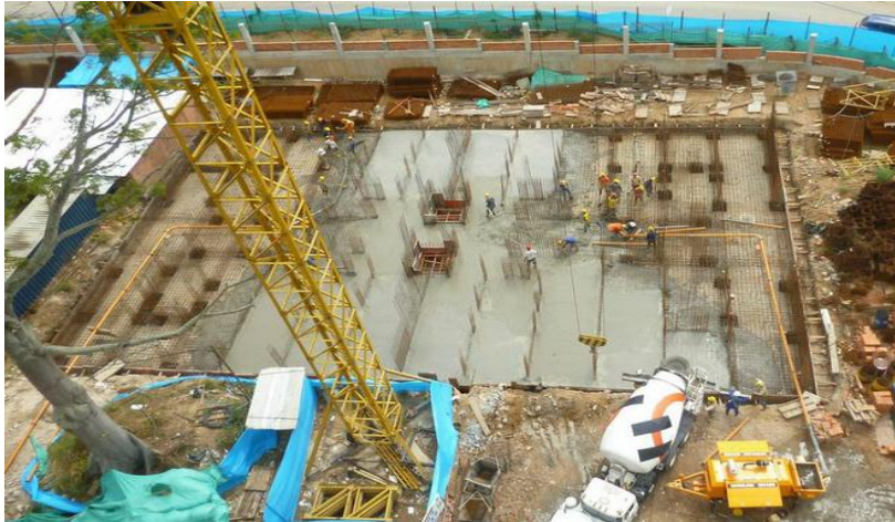
Figura 18: Fundida de losa de cimentación de torre 1.
