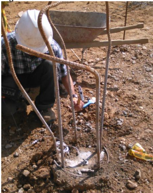
Figura 9: Ensayo de afinidad de pilotes
