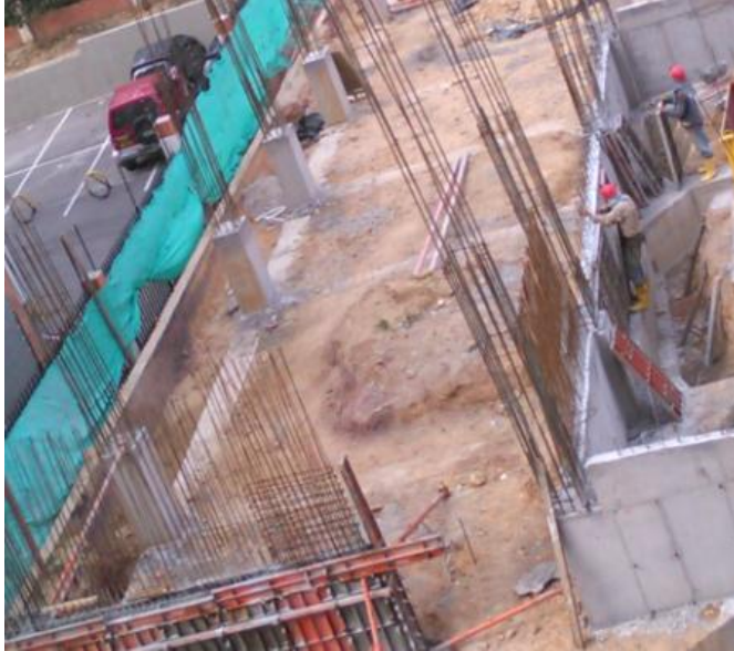
Figura 22: Columnas de parqueadero.
