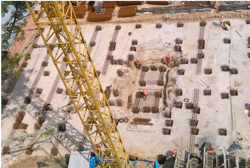
Figura 16: Armado de losa de cimentación de torre 1.
