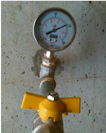
Figura 13: Pruebas hidráulicas, usando manómetros calibrados de 200 y 300 psi.
