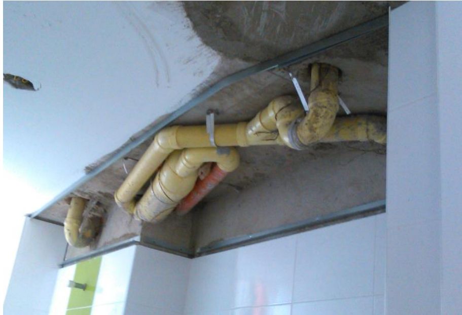
Figura 24: Perfilera de Drywall.
