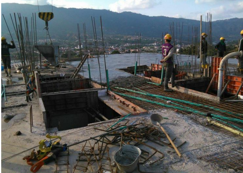
Figura 10: Fundida de placa de cubierta de torre 3.
