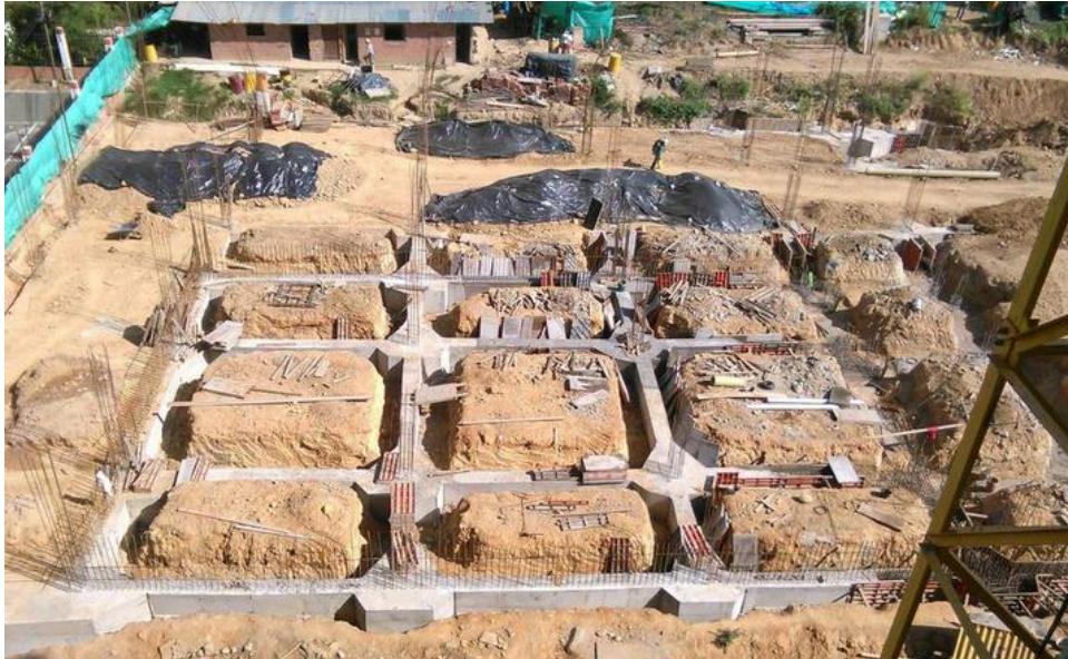
Figura 8: Cimentación de estructura de parqueadero
