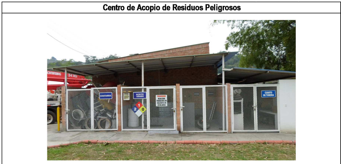
Figura 8. Cuarto de almacenamiento de residuos peligrosos
