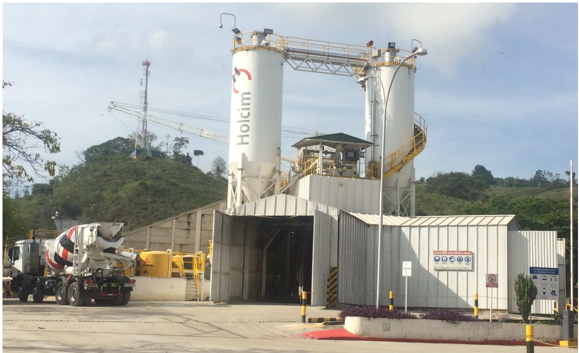
PLANTA DE CONCRETO HOLCIM FLORIDABLANCA 2016
