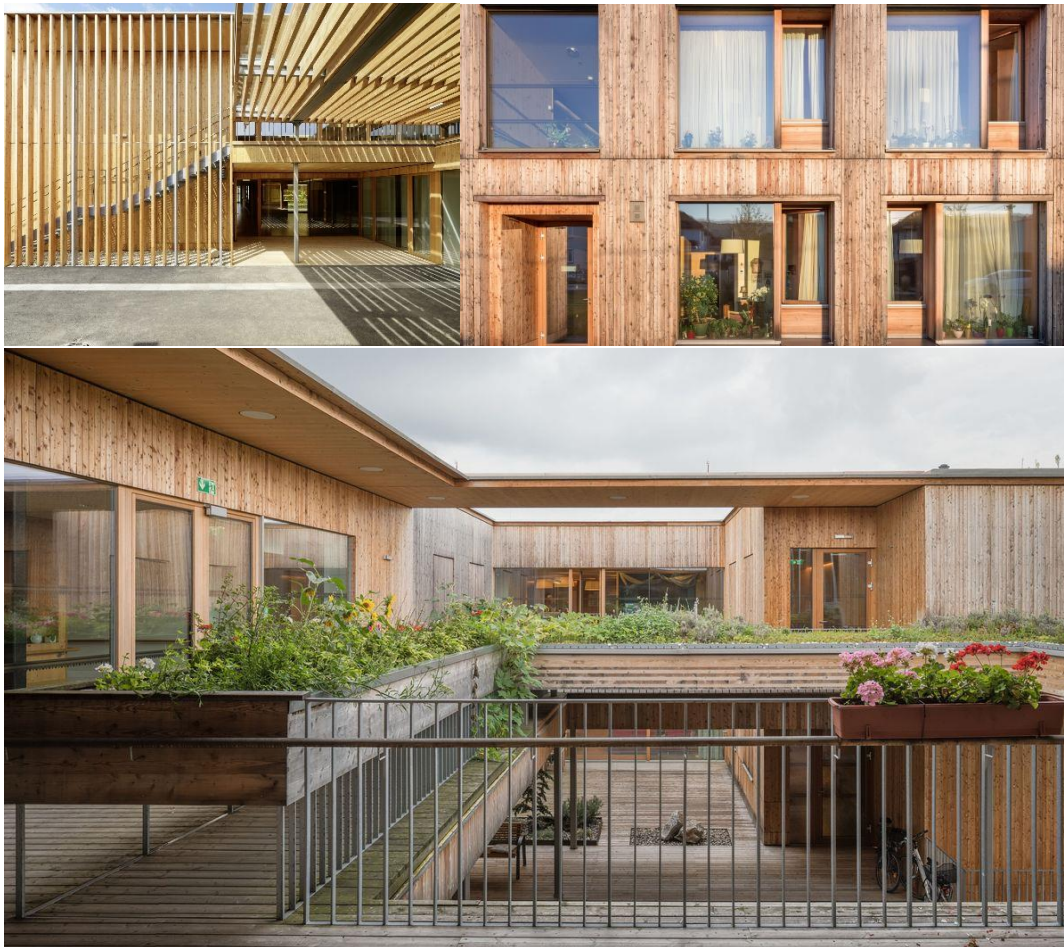
Imagen 37. Fotografías que muestran la materialidad de la residencia. Fotos tomadas por Dietger Wissounig Architekten
