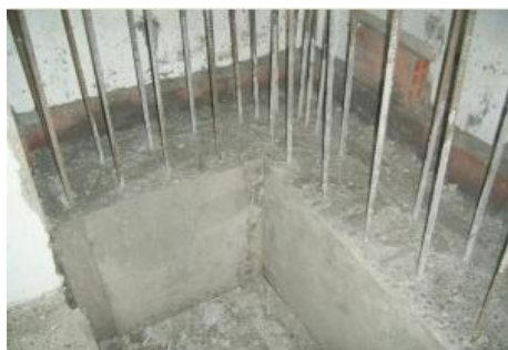
Figura 76. Desencofrado y fraguado.
