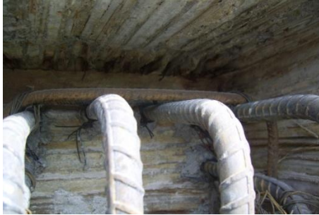
Figura 64. Anclajes en forma de L
