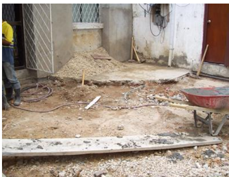
Figura 49. Demolicion de placa existente de espesor de 10 cm.
