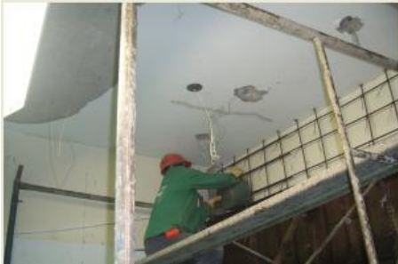
Figura 107. Se inicia el proceso de vaciado y el proceso de vibrado.
