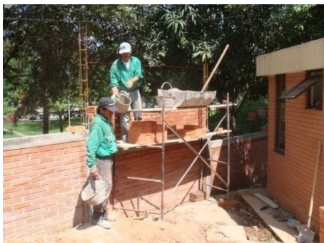
Figura 150. Construcción de muro en ladrillo a la vista tipo Holffman alineado por ambas caras
