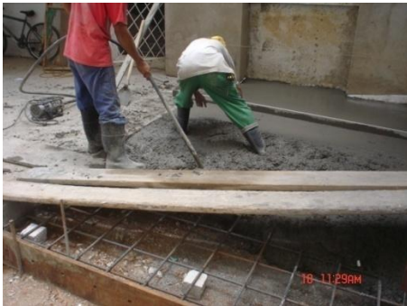
Figura 55. Método de vibración neumática, el cual fue muy satisfactorio, ya que trabajo directamente sobre el concreto y la manejabilidad es efectivo, puesto que se puede cambiar rápidamente y fácilmente de una posición a otra.
