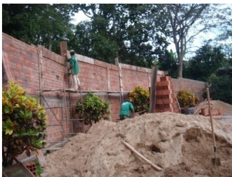
Figura 153. Construcción de vigas corona sobre mampostería H-15
