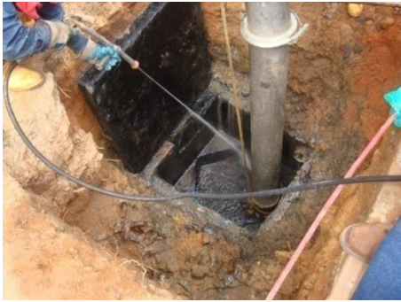
Figura 165. Limpieza de caja de inspección.
