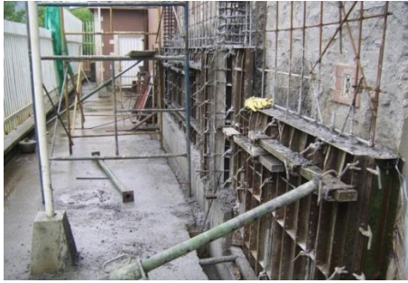
Figura 122. Armado de formaleta del segundo tramo.
