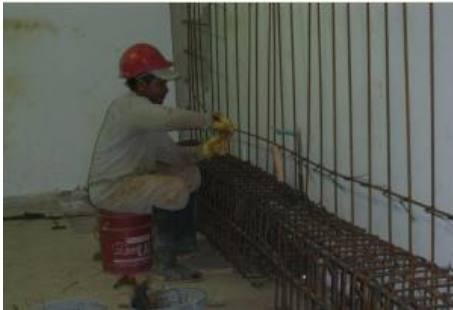
Figura 95. Instalación de los hierros verticales del elemento.
