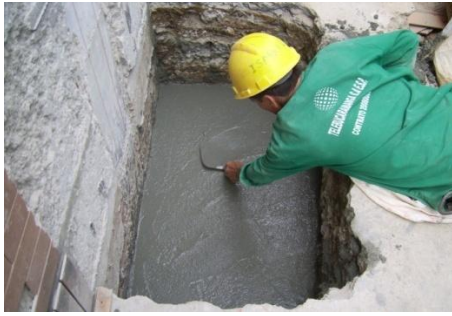
Figura 130. Terminación de la actividad de vaciado de concreto obteniendo como resultado el pilote en concreto ciclópeo, previamente se realizaron las perforación, y se anclaron los correspondientes aceros en forma de L.
