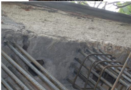
Figura 117. Perforaciones en la placa
