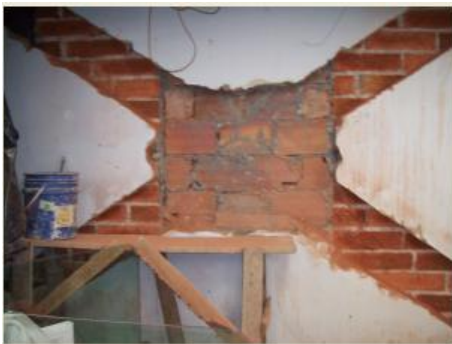
Figura 30. Demolición de muro interior para la previa ubicación de la estructura.
