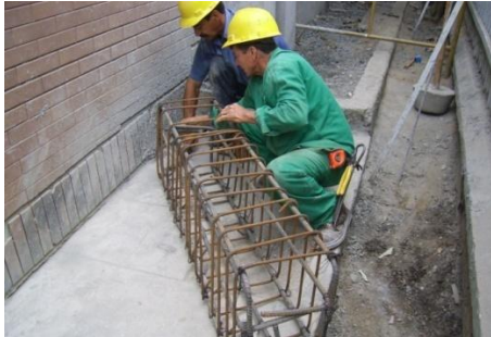
Figura 131. Armado de la viga de cimentación.
