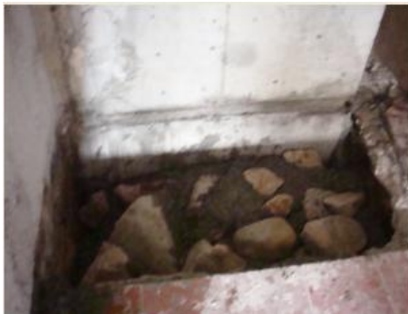
Figura 91. Relleno de los espacios adyacentes al elemento con concreto ciclópeo.
