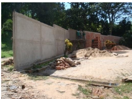
Figura 155. Friso liso sobre muros y dilataciones en juntas constructivas.
