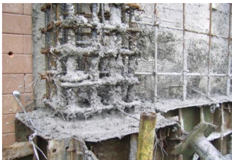
Figura 121. Vaciado de concreto de la columna.
