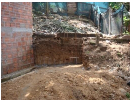
Figura 160. Instalación de aceros de reforzamiento
