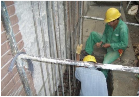
Figura 134. Colocación de aceros horizontales.
