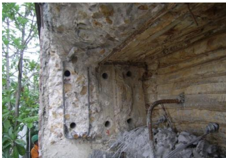
Figura 61. Perforaciones para posteriormente colocar los anclajes.
