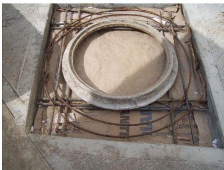
Figura 58. Armazón del hierro para las tapas.
