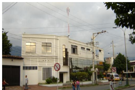
Figura 1. Fachada exterior es de piedra blanca adherida a muros sin confinamiento que aumenta considerablemente el riesgo de que con movimientos sísmicos se pueda caer, generando una amenaza para la integridad física de las personas.
