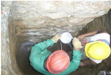
Figura 139. Aplica epóxico a la punta de la varilla que va a ser introducida al suelo, para que obtenga una mayor adherencia a este.
