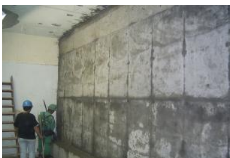
Figura 111. Fraguado del elemento estructural.
