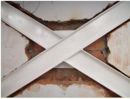
Figura 36. Finalización de Elemento estructural, quedando detalles arquitectónicos (mampostería, friso, estuco, pintura).
