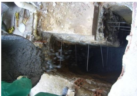
Figura 141. Una vez hallado suelo firme se inició la actividad de fundición del pilote en concreto ciclópeo
