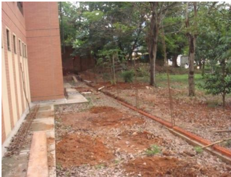
Figura 148. Replanteo de mampostería en ladrillo a la vista tipo Holffman rosado sobre viga de cimentación.
