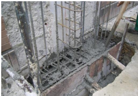
Figura 136. Vaciado de concreto a la viga de cimentación.
