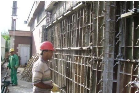
Figura 123. Armado de formaleta tercer tramo.
