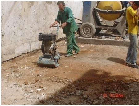
Figura 50. Compactación de la sub-base de forma mecánica con la maquina compactadora manual, haciendo las correspondientes pasadas hasta alcanzar el espesor requerido para la placa 20 cm de acuerdo a los diseños establecidos.
