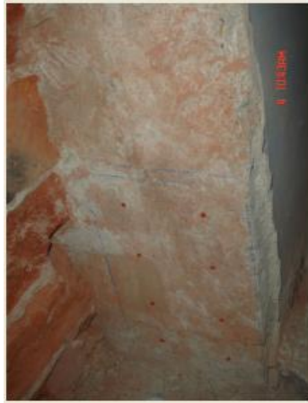
Figura 26. Previa demarcación o plantilla en columnas y vigas.
