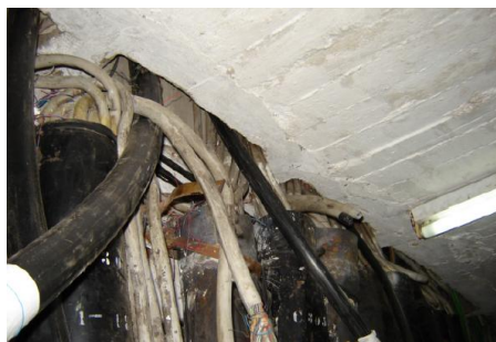
Figura 21. Túnel de salida de las líneas de la central.
