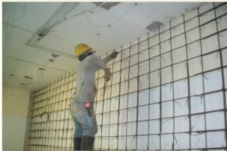
Figura 96. Instalación de los hierros verticales del elemento.
