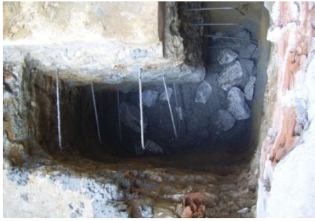
Figura 142. Utilización de materiales tales como la piedra Rajón y el cemento, para realizar el pilote en concreto ciclópeo.
