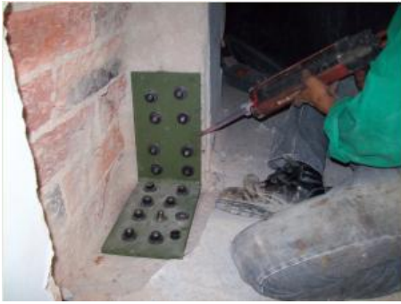
Figura 32. Inyectando Sikadur 35 HI MOD LV en las juntas donde se aprecia dilatación o grietas.
