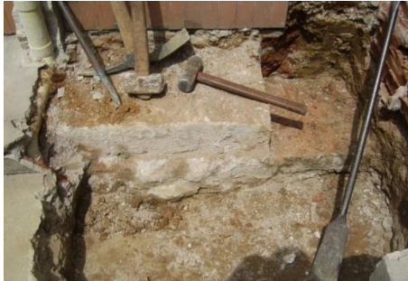
Figura 138. Apique, buscando suelo firme.
