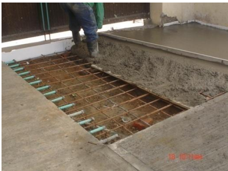
Figura 56. Anclajes de varillas de transferencia
