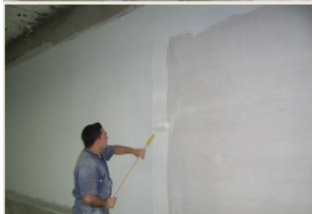
Figura 113. Acabados finales que constan de Friso, estuco y pintura.
