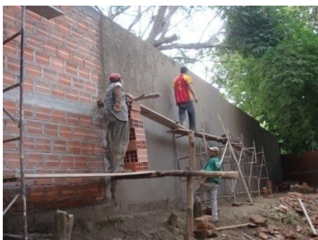
Figura 158. Proceso de aplicación de friso sobre muro.
