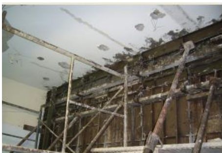
Figura 109. Finalizan la fundida del elemento.
