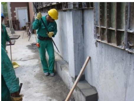
Figura 126. Desencofrado de la pantalla.
