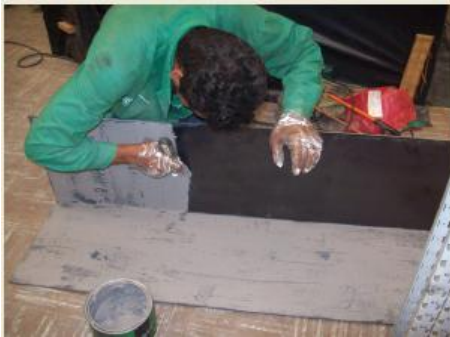
Figura 39. Aplicación del Aditivo Pegante Epóxico Sikadur 32 Primer a las laminas de 3/16" y a cada una de las caras de las columnas de Sección de 30 x 30 cm., para su revestimiento.
