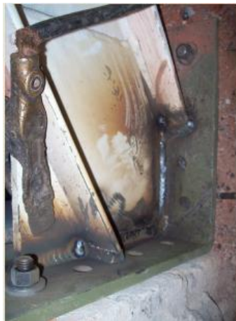
Figura 34. Realización de los Cordones de Soldadura del elemento estructural con la platina.
