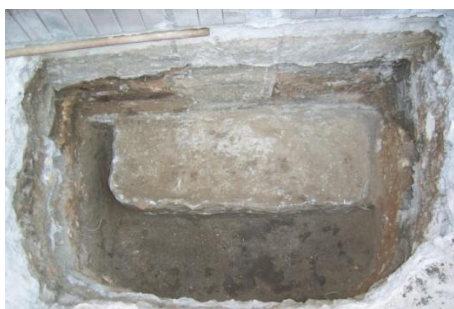
Figura 128. Realizado el apique se encuentra finalmente suelo firme y confiable para la realización de las actividades de fundición.
