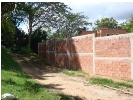
Figura 156. Vista panorámica del cerramiento en ladrillo h-15
