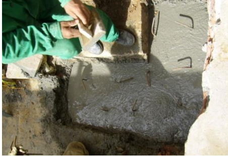
Figura 143. Terminación de la construcción del pilote.
