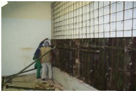
Figura 103. Instalación del encofrado metálico, para la fundición del segundo tramo del elemento.
