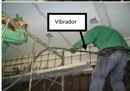
Figura 108. La formaleta debe quedar bien soportada debido a la presión del vaciado.
