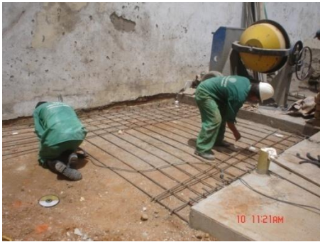
Figura 51. Para armar los hierros se utilizaron varillas de \frac{1}{2} " de diámetro cada 25 cm de separación, Armadura Secundaria o transversal destinada para confinamiento, se utilizó varilla de \frac{5}{8} " de diámetro de forma transversal cada 30 cm.
