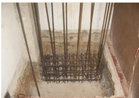
Figura 84. Instalación de los hierros verticales del elemento
