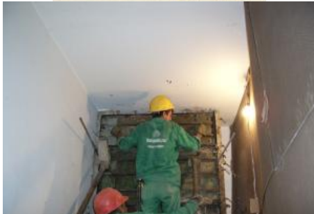
Figura 89. Se inicia el proceso de vaciado y el proceso de vibrado.
