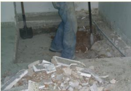
Figura 69. Demolición de los pisos acabados en donde se ejecutara el elemento estructural.
