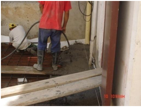
Figura 54. vaciado de concreto de 3500 psi a 3600 psi con una proporción 1:2:2y utilizando acelerante Aditivo reductor de retracción de fraguado
