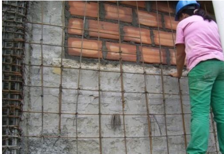
Figura 67. Armado del acero para la pantalla, y columna ya armada con sus respectivos aceros, y estribos debidamente amarrados con el alambre negro.
