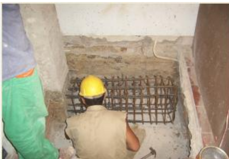
Figura 83. Previa demolición del piso acabado e Instalación de la canasta de la viga de soporte
