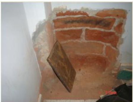
Figura 29. Demolición de muro interior para la previa ubicación de las platinas estructurales.
