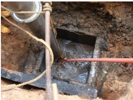
Figura 166. Limpieza de tubería con la sonda de la vactor.
