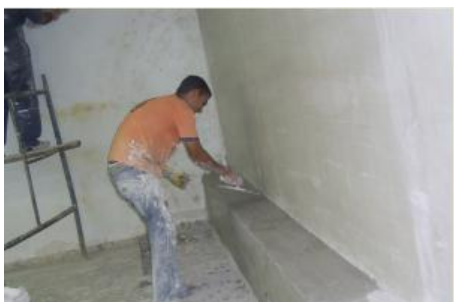
Figura 112. Acabados finales que constan de Friso, estuco y pintura.
