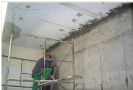
Figura 110. Desencofrado y fraguado del elemento estructural.
