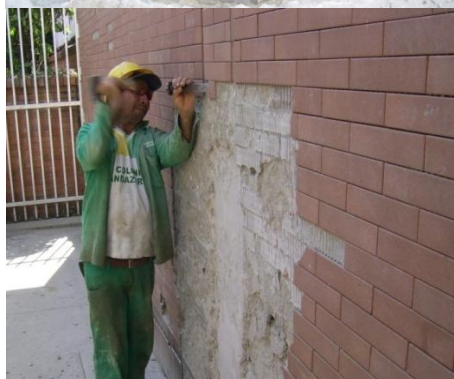
Figura 129. Demolición de fachaleta existente.
