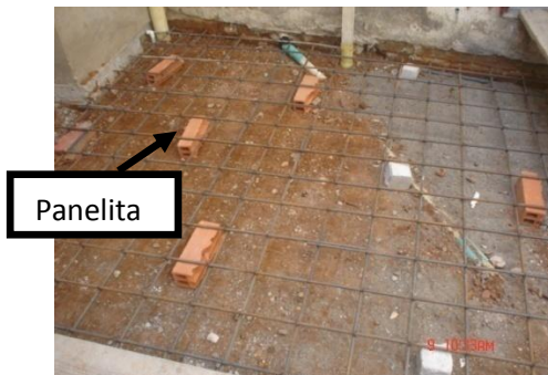
Figura 52. Fijación de panelitas, con el fin de que la malla alcanzara el eje especificado en los planos.
