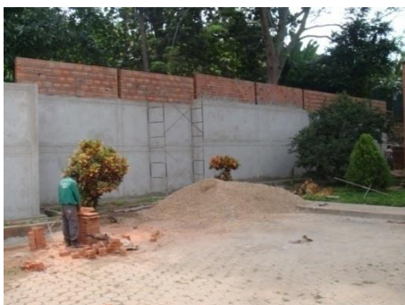
Figura 159. Construcción de hiladas adicionales con el fin de garantizar la altura establecida por el área de seguridad, 3,50 cm.
