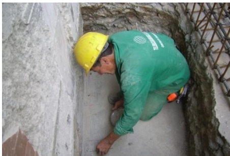
Figura 132. Perforaciones en el pilote de concreto, y posteriormente se unta con epoxico para mayor adherencia de las varillas de acero.
