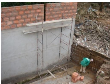
Figura 161. Instalación de aceros de reforzamiento
