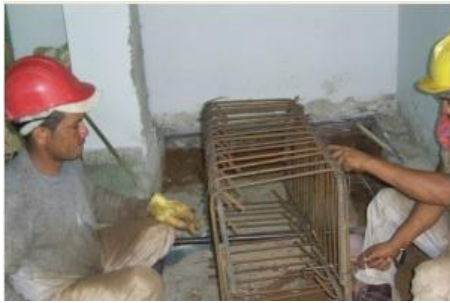
Figura 70. Armazón de hierro principal para la viga de soporte.
