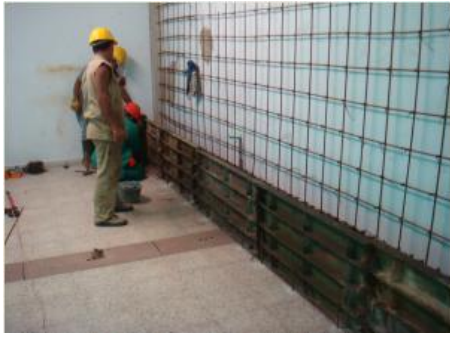
Figura 98. Instalación del encofrado metálico.
