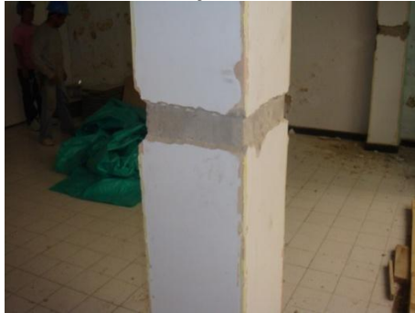
Figura 13. Demarcación de columnas y ejes
