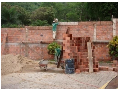
Figura 154. Construcción de vigas corona sobre mampostería H-15
