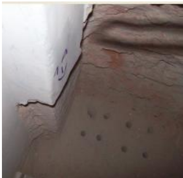
Figura 27. Perforación en las columnas y vigas.
