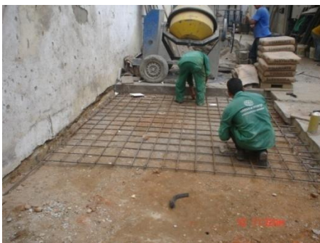
Figura 53. Armazón de hierros tanto longitudinales como transversales.
