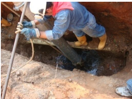
Figura 167. Limpieza del pozo séptico.
