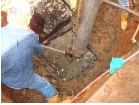
Figura 164. Limpieza de caja de inspección.
