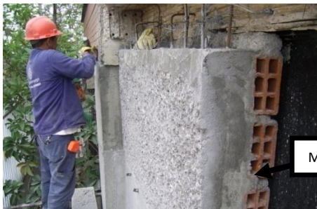
Figura 68. Construcción de mampostería.
