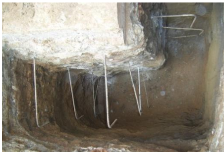
Figura 140. Inician las perforaciones para realizar los debidos anclajes en forma de L, con longitud entre 1,00 y 3,00 metros y un diámetro de las varillas de \phi 3/8"
