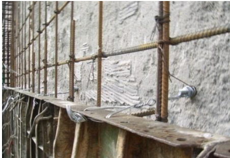
Figura 115. Demolición total de la Fachaleta, amarres del acero tanto horizontal como vertical con alambre negro.
