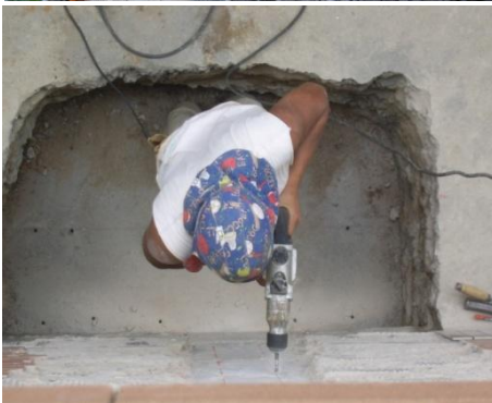
Figura 62. Realizando perforaciones en columna y viga de cimentación.
