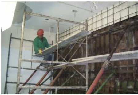
Figura 106. Instalación del encofrado metálico, para realizar la fundición del tercer tramo del elemento.
