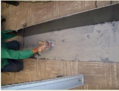
Figura 38. Aplicación del Aditivo Pegante Epóxico Sikadur 32 Primer a las laminas de 3/16" y a cada una de las caras de las columnas de Sección de 30 x 30 cm., para su revestimiento.
