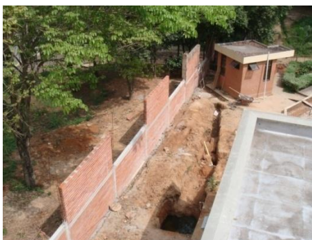
Figura 152. Vista panorámica del muro sobre la avenida café Madrid- chimita
