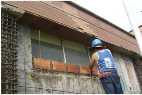
Figura 66. Construcción de mampostería, para continuar con el armado de aceros para la pantalla, sellado de ventanal.
