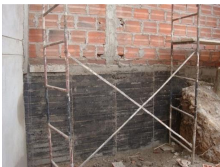
Figura 162. Tableros en madera, para formaletear el muro de contención.
