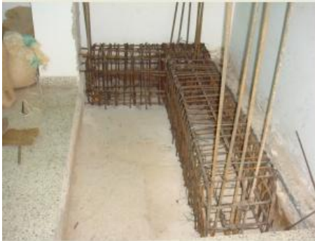
Figura 71. Instalación de la canasta para la viga y armazón de los hierros verticales para las columnas dentro del elemento.
