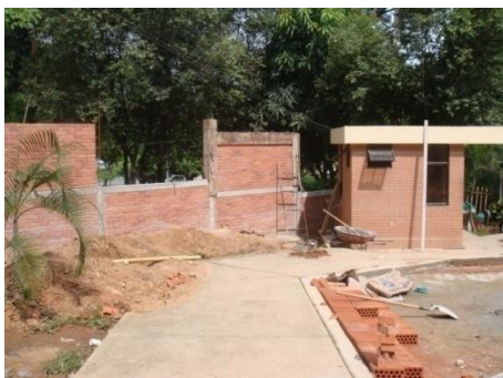
Figura 151. Construcción de viga de corona sobre muro en mampostería a la vista.
