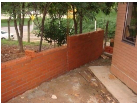
Figura 149. Construcción de muro en ladrillo a la vista tipo Holffman
