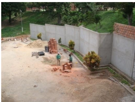
Figura 157. Vista panorámica del cerramiento en ladrillo h-15 con la terminación de friso y dilataciones en juntas constructivas.
