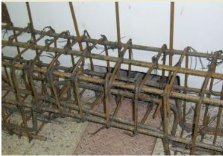
Figura 94. Instalación de la canasta de la viga de soporte.
