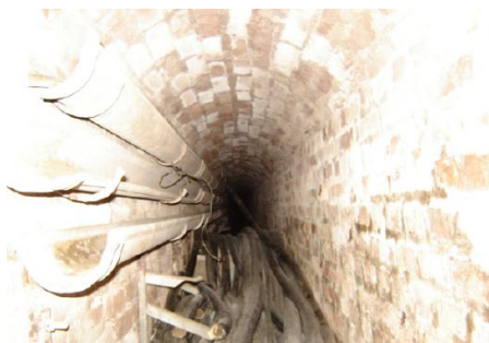
Figura 22. Parte Final del Túnel
