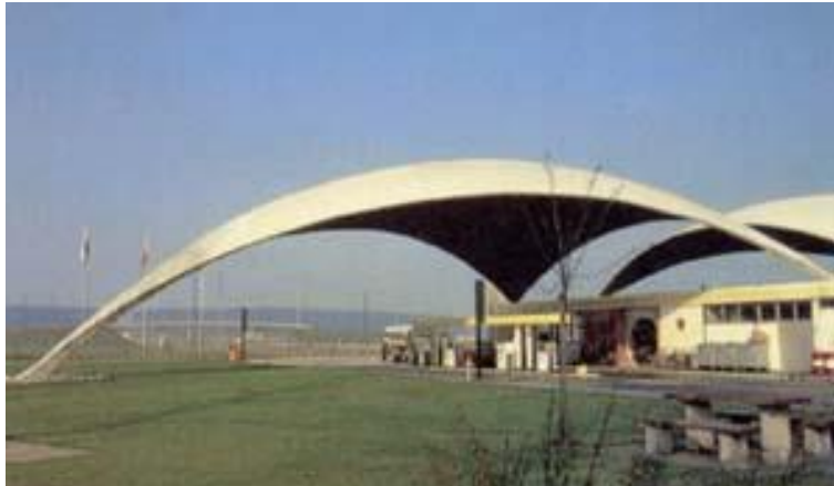
Ilustración 4: Techo estación de gasolina en Suiza. Cáscara de concreto 3
