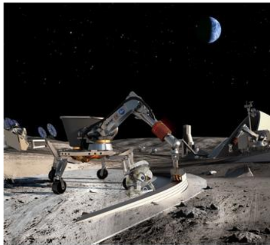
Ilustración 110: La tecnología de Contour Crafting tiene el potencial para construir estructuras en la Luna o en Marte 92
