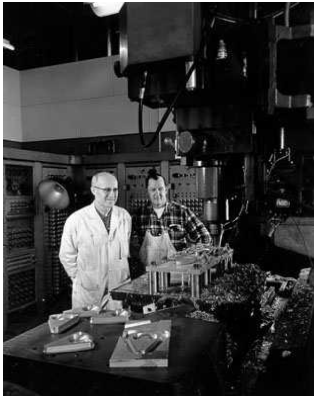
Img. 4.6 John Parsons y la primera fresadora de control numérico 73
