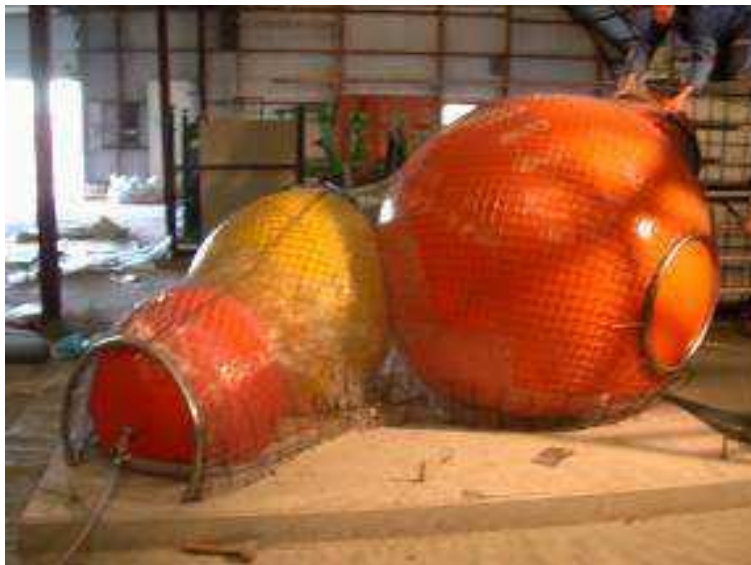
Ilustración 10: Se inflaron tres balones y luego se recubrieron con aros de acero y una malla 6
