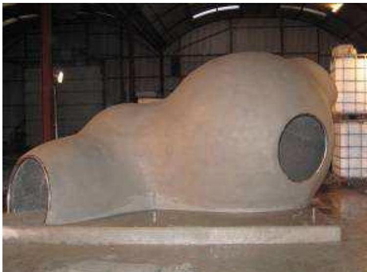
Ilustración 10: Se inflaron tres balones y luego se recubrieron con aros de acero y una malla 6
