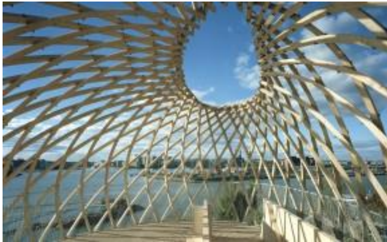
Ilustración 17: Ville Hara structure 9
