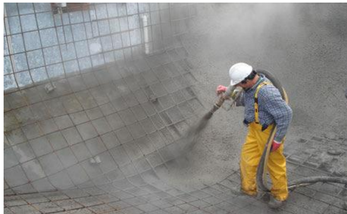
Ilustración 36: Aplicación a presión del cemento 27
