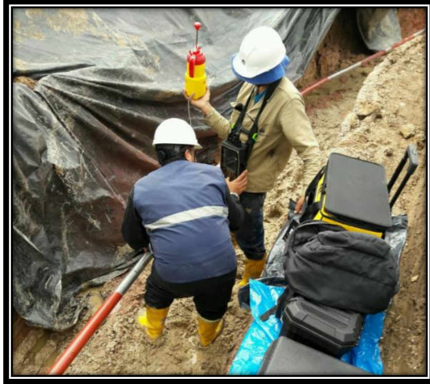
Ilustración 5. Boyacá, Combita, vereda Concepción, Nelson Caro. Valoración de tubería mecánica.
