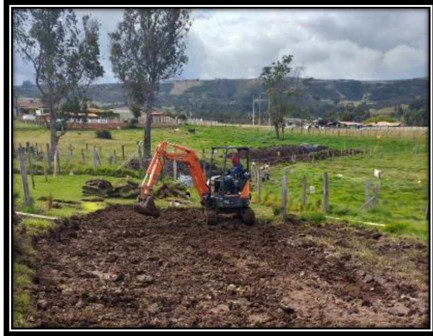
Ilustración 6. Boyacá, Combita, vereda Concepción, Nelson Caro. Relleno compactado.
