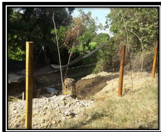
Ilustración 19. Fotografía de cerramiento. Armero, Santo Domingo, Supervisor de obra Gabriel Umaña.
