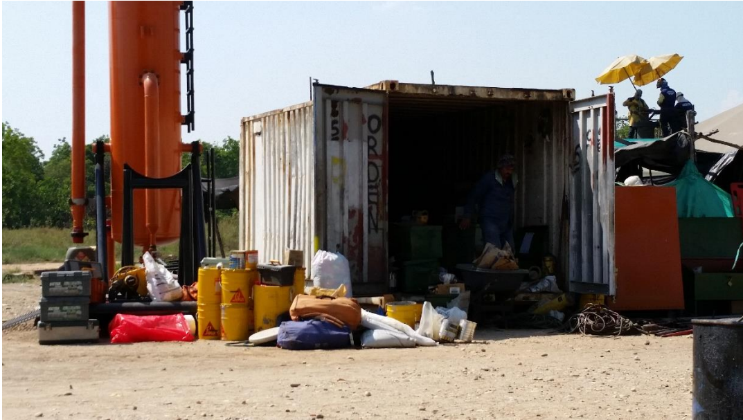
Figura 4 Adecuación De Bodega De Materiales
