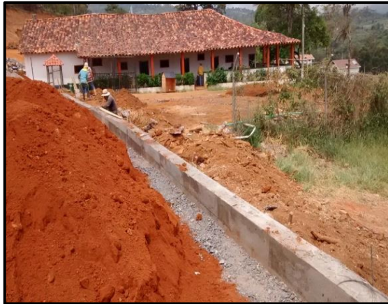
Ilustración 42 – Muro de contención y filtro.
