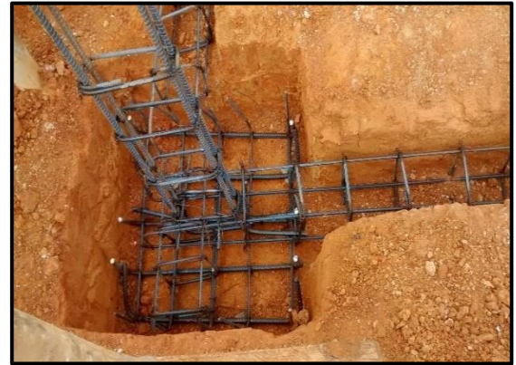
Ilustración 45 - Refuerzo Cimentación Zona Húmeda
