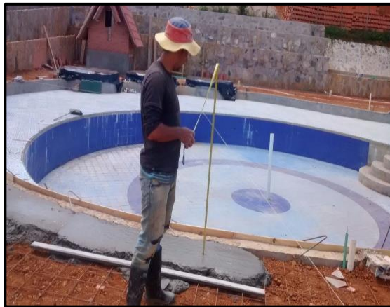
Ilustración 36 – Verificación niveles terraza.
