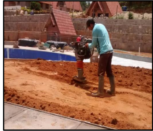
Ilustración 35 – Compactación Terreno.
