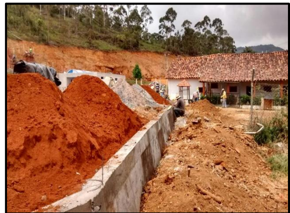
Ilustración 76 – Muro de contención Vía.
