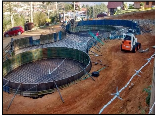
Ilustración 44 - Formaleta y refuerzo Piscina
