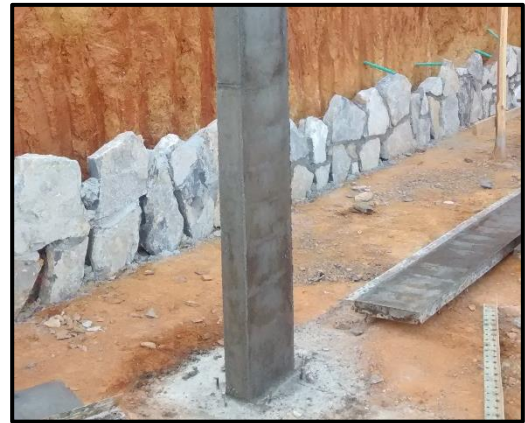
Ilustración 14 – Desencofrado Columnas.
