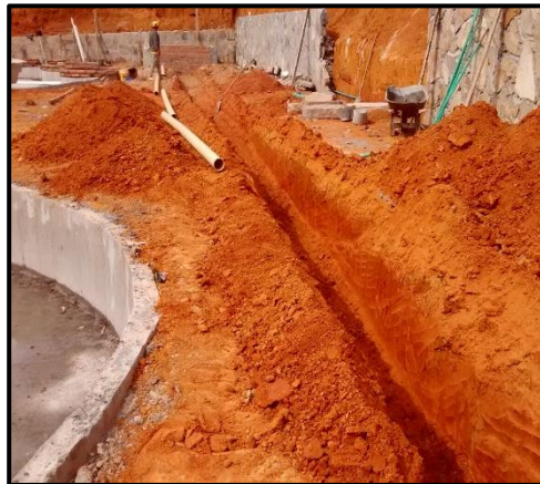
Ilustración 29 –Zanja para tubería 4”.
