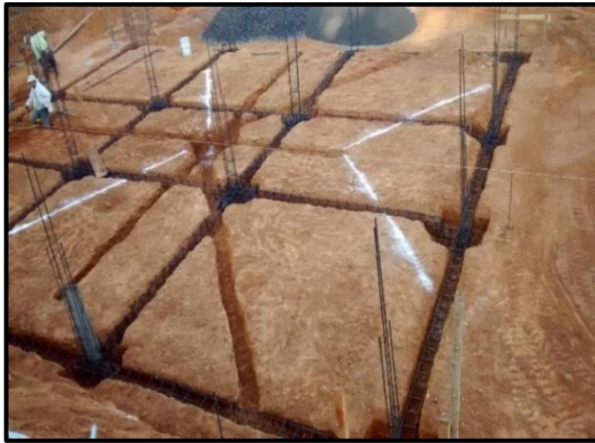
Ilustración 48 - Cimentación y Red Sanitaria.
