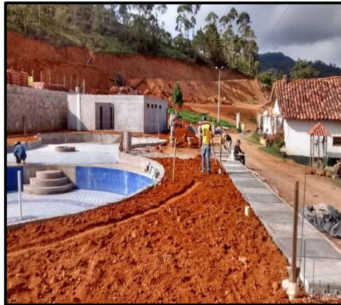
Ilustración 34 – Replanteo Terraza Piscina.
