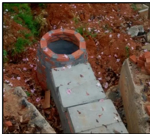
Ilustración 27 –Cámara de caída, Posterior.
