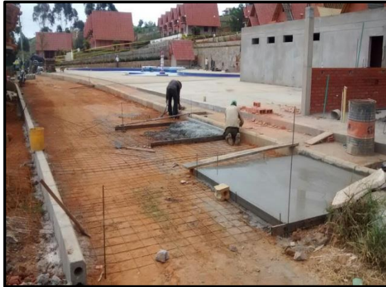
Ilustración 77 – Fundición Losas Vía.
