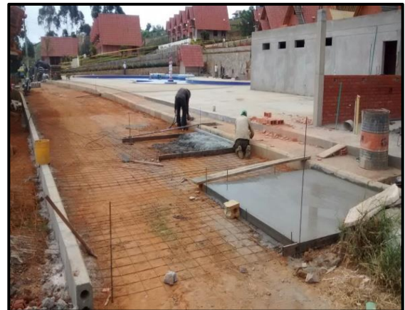
Ilustración 43 – Fundición losas vía.
