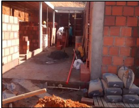
Ilustración 54 – Mampostería Zona Húmeda.
