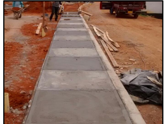
Ilustración 39 – Fundición Andenes.
