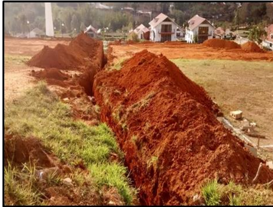
Ilustración 71 – Excavación Alcantarillado Principal.
