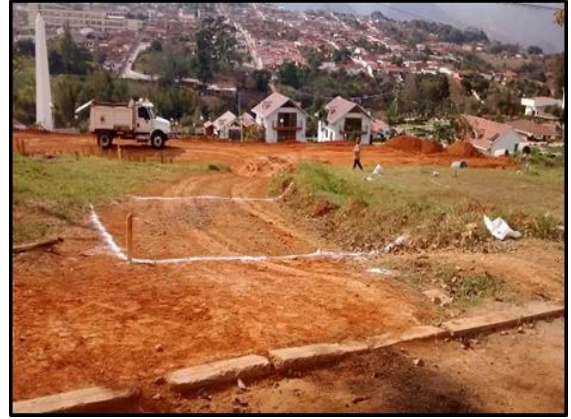
Ilustración 72 – Replanteo Administración.
