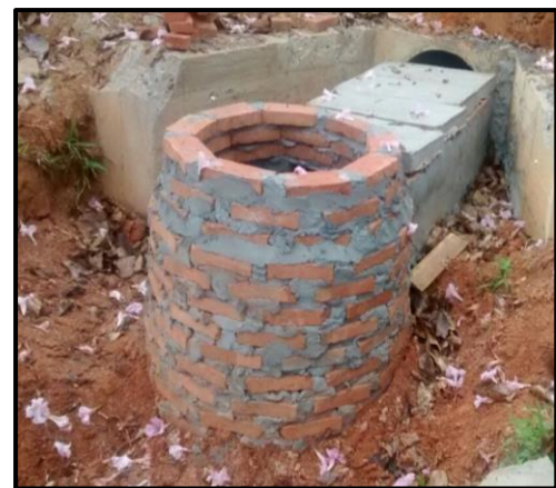
Ilustración 28 –Cámara de caída, Frontal.
