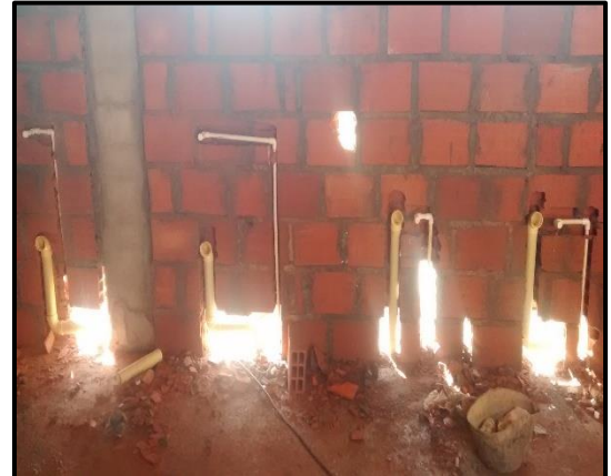
Ilustración 55 – Reubicación Tubería.
