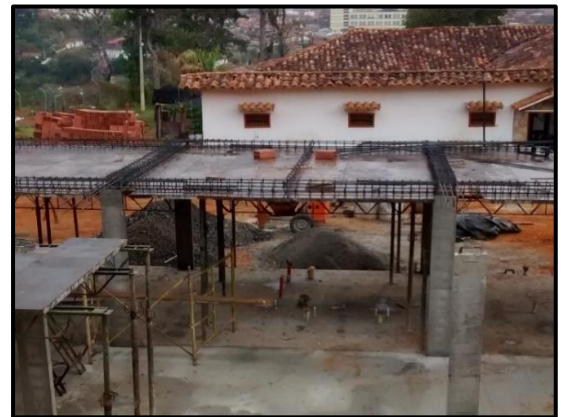
Ilustración 51 - Refuerzo Placa de Cubierta.
