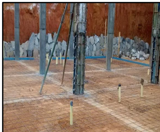
Ilustración 11 – Formaleta Columnas.
