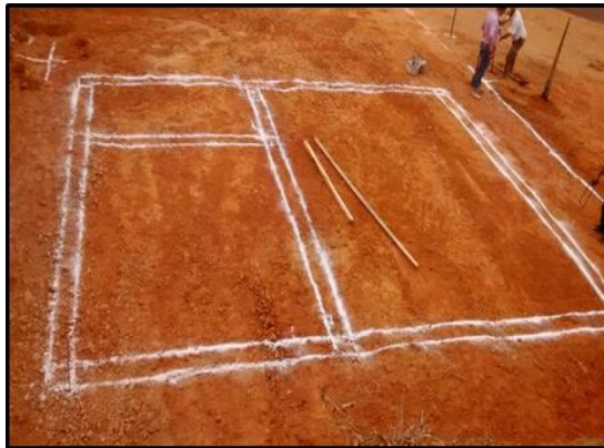
Ilustración 63 – Replanteo Chalet.
