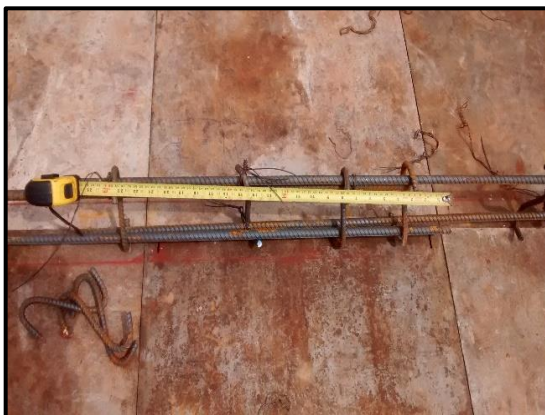
Ilustración 52 - Detalle traslapo.
