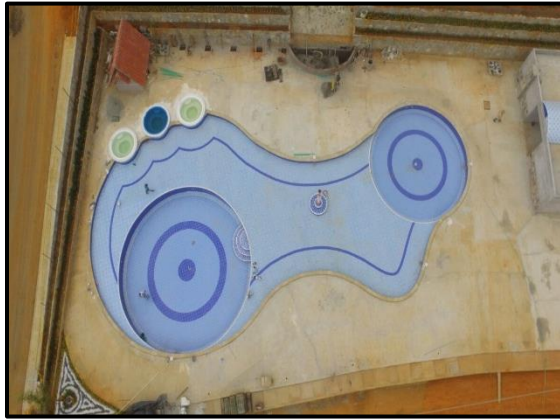
Ilustración 62 – Fin labores Enchape Piscina.
