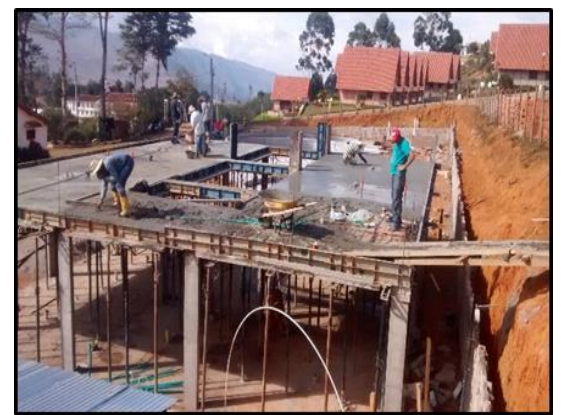
Ilustración 53 - Fundición Placa Aligerada.
