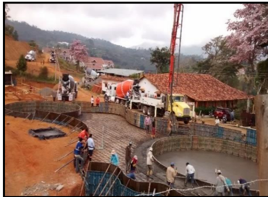
Ilustración 46 - Fundición Piscina.
