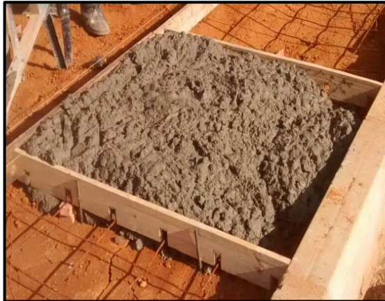
Ilustración 38 – Detalle Formaleta Andén.
