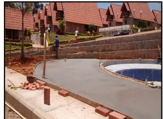
Ilustración 74 – Placa Contrapiso Terraza Piscina.
