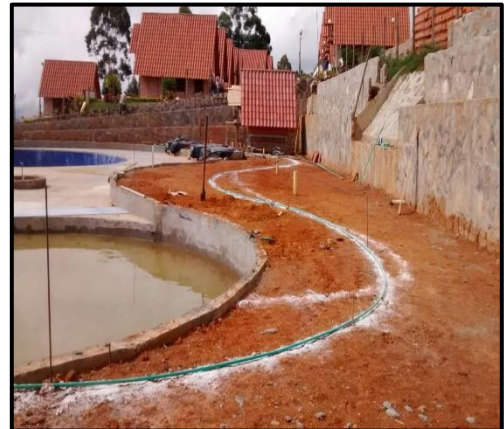
Ilustración 25 – Trazado Terraza.
