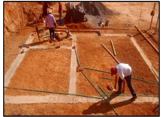
Ilustración 64 – Cimentación y Labores Eléctricas.
