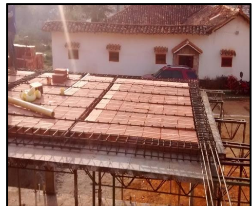
Ilustración 12 – Detalle Placa Aligerada.
