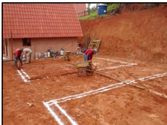
Ilustración 80 – Replanteo Chalets Una Planta.
