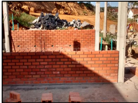
Ilustración 79 – Mampostería y Estructura Snack Bar.
