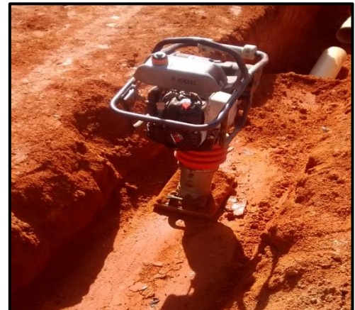
Ilustración 30 – Compactación Terreno Excavado
