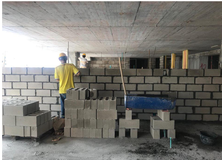
Figura 11: Seguimiento a levantamiento de muros en mampostería. Proyecto: Monza23. Fuente: autor.
