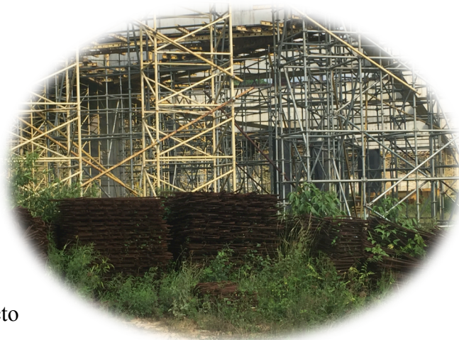
Fotografía 1. Acero ubicado a la intemperie sin ninguna protección
