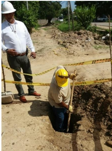
Ilustración 28. Empalmes en el barrio pradera se desconectó el tubo de 3" y se empalmo uno de 6" para mejorar el caudal y la presión del barrio
