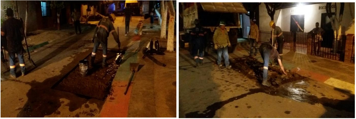
Ilustración 53 Demolición de pavimento en malas condiciones y aplicación de emulsión
