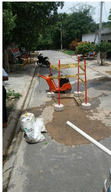
Ilustración 33. Corte de pavimento para reparar fuga en el barrio brisas
