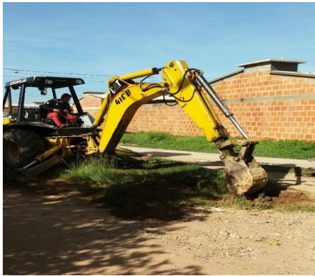
Ilustración 24. Prolongación de tubería de 6" en la urbanización ALBEQUIN, se pretende meter unos 200 m de tubería
