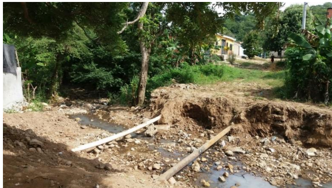
Ilustración 22. Visita al caño para mirar el cómo levantar un poco más la tubería del acueducto
