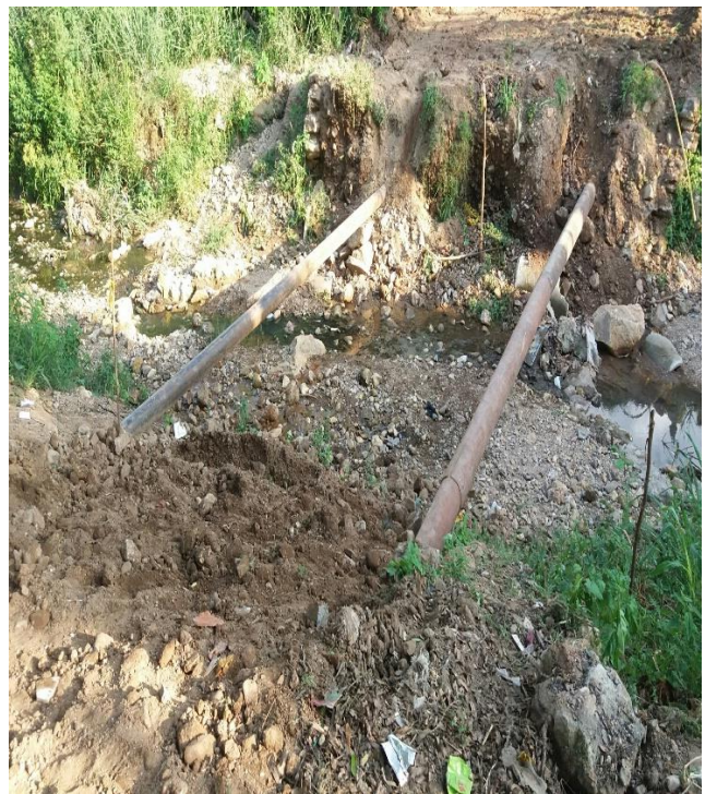
Ilustración 47 Debido a que la tubería de 6" PVC de acueducto atravesaba el caño y en las Fuertes lluvias esta estaba expuesta a las crecientes del caño fue necesario encamisarla en tubería de perforación para protegerla de la escorrentía del agua, quedo programado la
