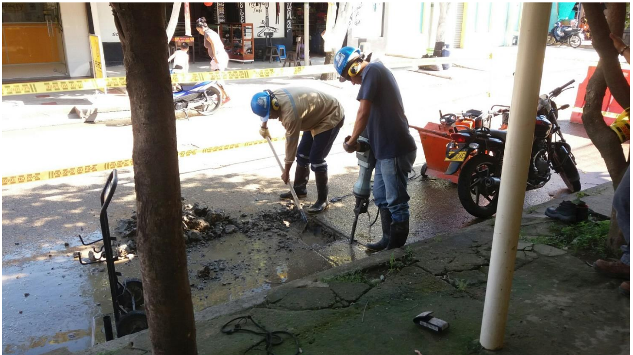
Ilustración 48 Corte y demolición de pavimento rígido para darle solución a fuga en la Carrera 39 D con calle Sabanita
