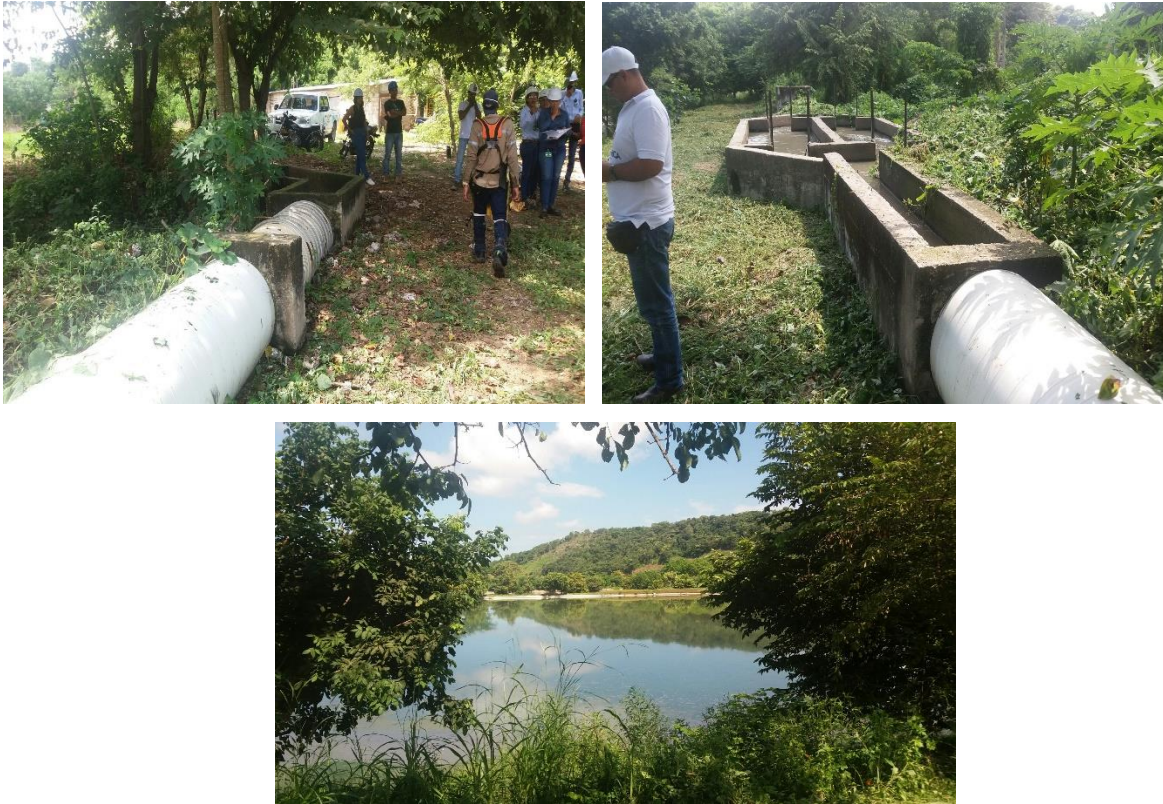
Ilustración 5 Corte de maleza y mantenimiento de los canales de la STAR Jerusalén
