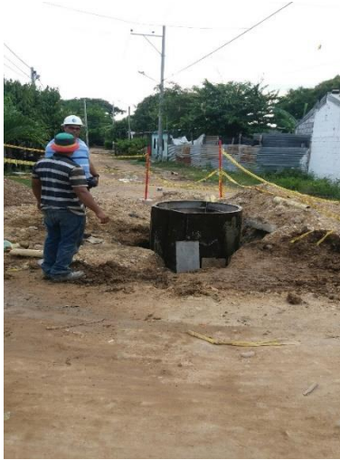
Ilustración 40 Construcción de pozo de inspección para el empalme del barrio Oasis a la red de alcantarillado.
