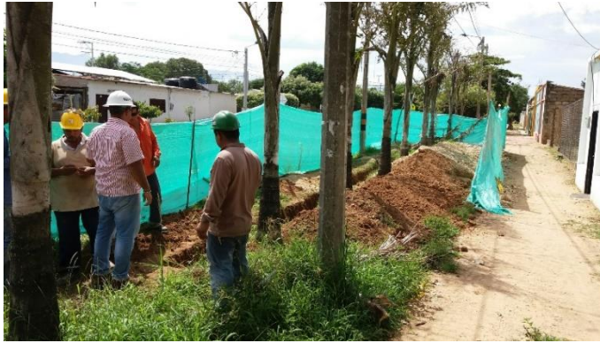
Ilustración 20. Excavación o remoción de tierra para la instalación de alcantarillado de 8"
