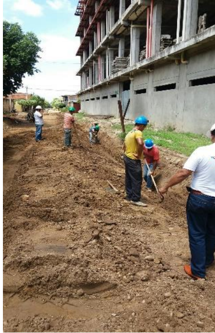
Ilustración 18. Trabajo de reposición de tubería de asbesto cemento a PVC debido a la pavimentación de la vía
