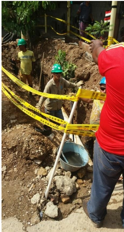
Ilustración 34. Empalme cra 14 cll 16 para el mejoramiento del servicio de los barrios San Marcos, Maria Auxiliadora y San Lázaro
