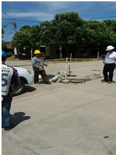
Ilustración 19. Limpieza de pozo de inspección debido a taponamiento en la red y sedimentación en el pozo
