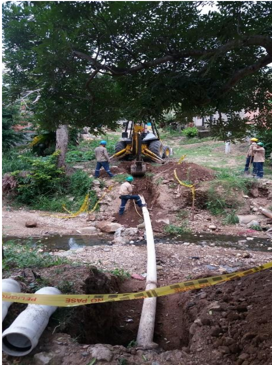
Ilustración 47 Debido a que la tubería de 6" PVC de acueducto atravesaba el caño y en las Fuertes lluvias esta estaba expuesta a las crecientes del caño fue necesario encamisarla en tubería de perforación para protegerla de la escorrentía del agua, quedo programado la
