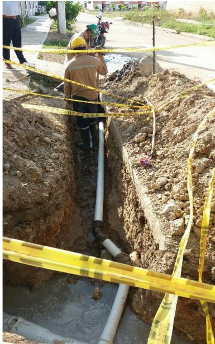
Ilustración 45 Empalme de tubería de 6" a 3" en el barrio Arboleda de Alvequin, para mejoramiento del servicio.
