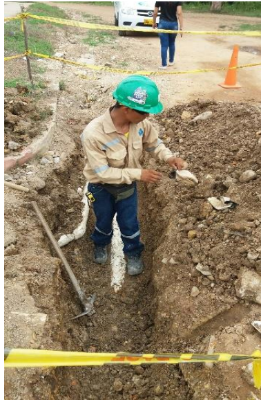
Ilustración 42 Excavación manual en búsqueda del extremo de la tubería de 6" para empalme con tubería de 3" barrio Alvequín.
