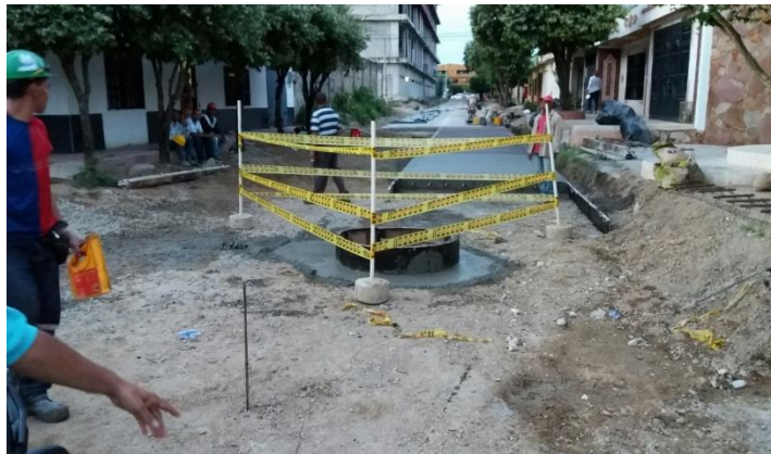
Ilustración 41 Construcción de pozo de inspección debido a la pavimentación de la calle 26A entre carreras 6 y 5.
