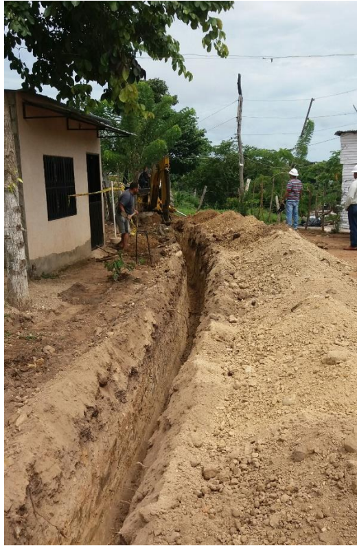
Ilustración 46 Excavación con maquinaria pesada en el barrio Buena Vista para la ampliación del servicio de acueducto, se instaló tubería de 4" PVC.
