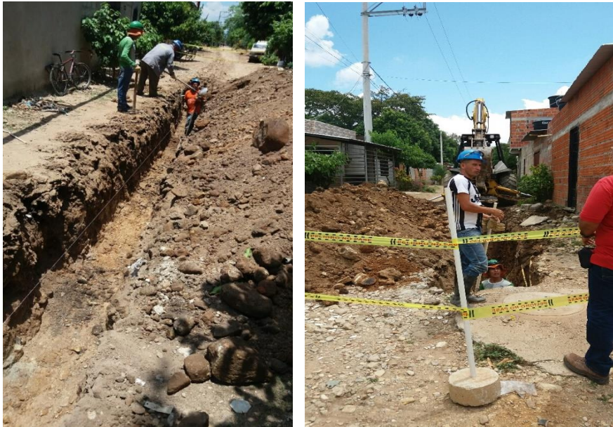
Ilustración 32. Después de la toma de niveles, procedemos a iniciar con la excavación en la cll 11 cra 39 D y 40, barrios 20 de enero y Buenos aires
