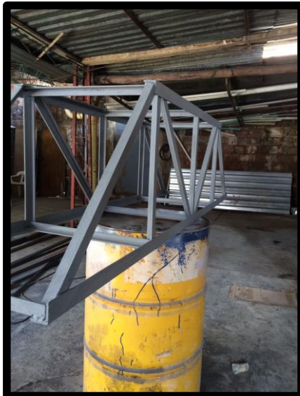
Figura 3. Construcción de cercha en taller.
