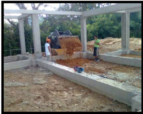
Fotos 56 y 57, Relleno y replanteo para placa. Fuente Propia
