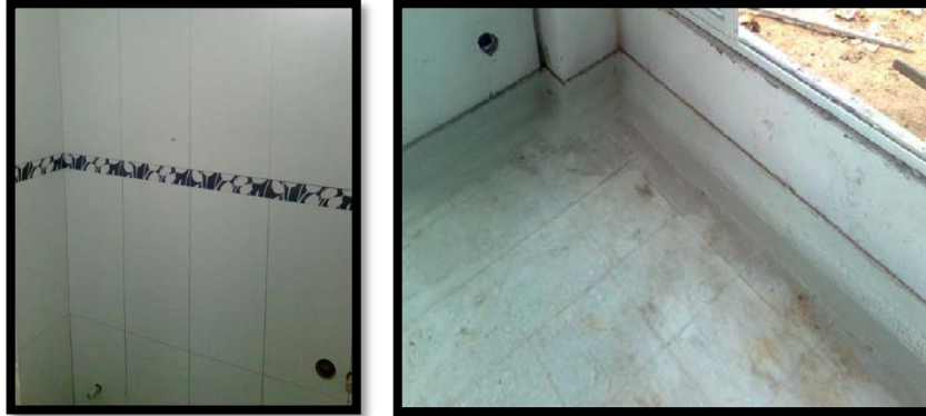
Fotos 69 y 70, Enchape de baño y piso en granito Salón Social. Fuente Propia
