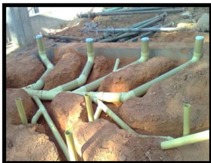
Fotos 60, 61, 62 Instalaciones sanitarias y manómetro en prueba hidráulica. Fuente Propia
