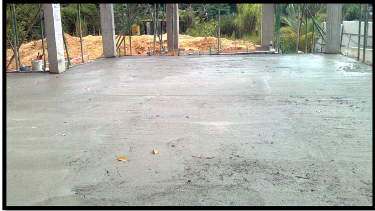
Fotos 58 y 59, Fundida y proceso de allanado de la placa de antepiso. Fuente Propia
