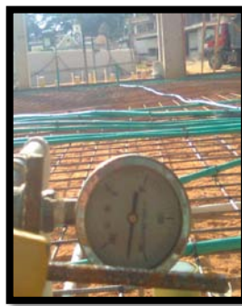
Fotos 60, 61, 62 Instalaciones sanitarias y manómetro en prueba hidráulica. Fuente Propia
