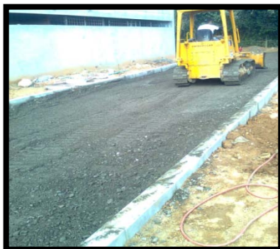
Fotos 74 y 75, Extendida de material de base granular, Fuente Propia
