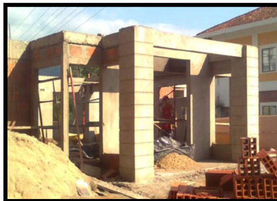
Foto 45, Guardería en actividad de mampostería y friso. Fuente Propia
