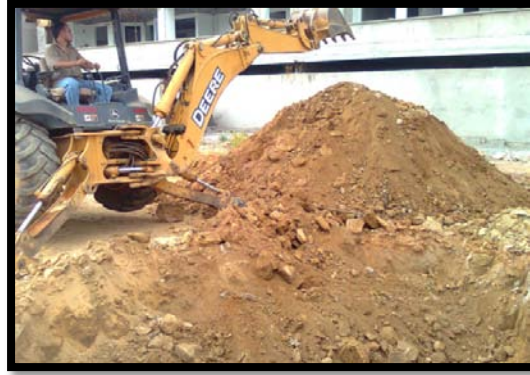
Fotos 24, Excavación del área de piscina. Fuente Propia
