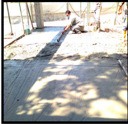
Fotos 58 y 59, Fundida y proceso de allanado de la placa de antepiso. Fuente Propia
