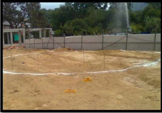
Fotos 23, Replanteo con cal del área de piscina. Fuente Propia
