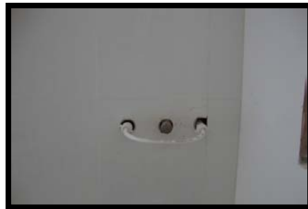
Foto 4, Acople para empalme de la red. Fuente Propia
