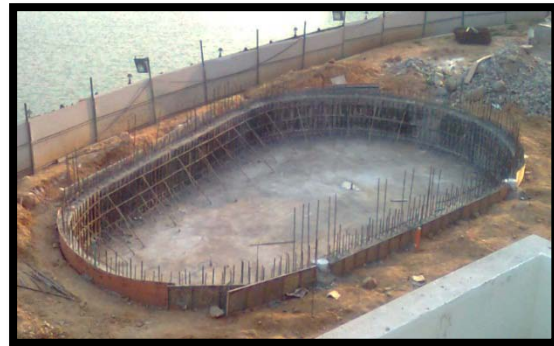
Foto 29, Vista superior estructura de piscina. Fuente Propia
