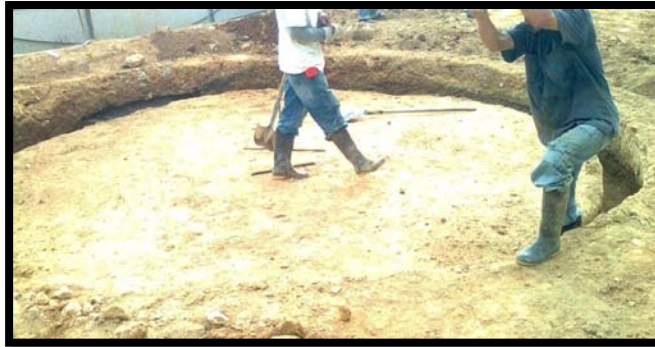
Foto 36, Área excavada de la piscina niños. Fuente Propia
