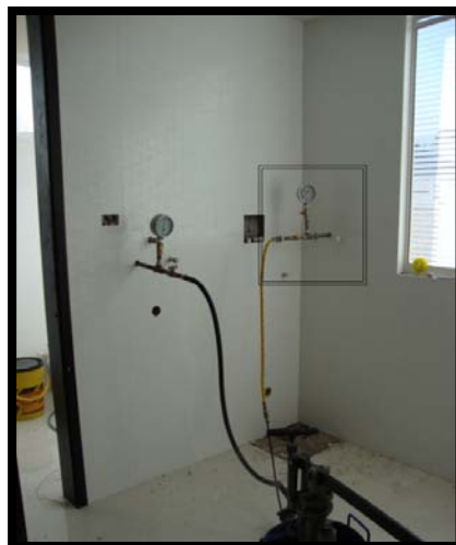
Foto 10, Montaje para prueba de gas y prueba hidráulica. Fuente Propia
