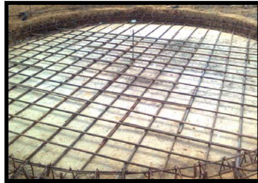
Foto 37, armada de estructura de placa piscina niños. Fuente Propia
