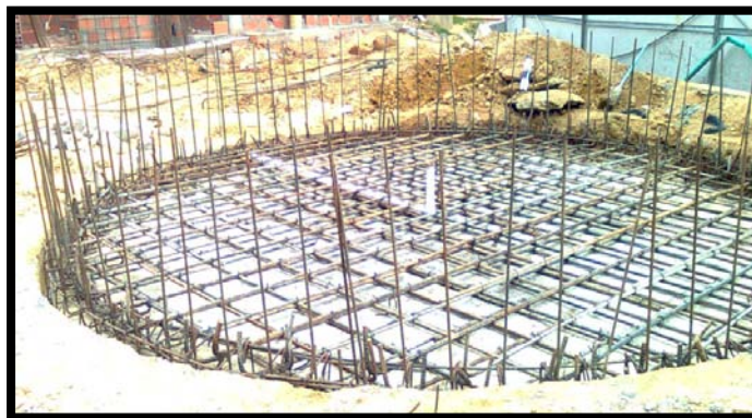
Foto 38, armada de estructura del muro de piscina niños. Fuente Propia
