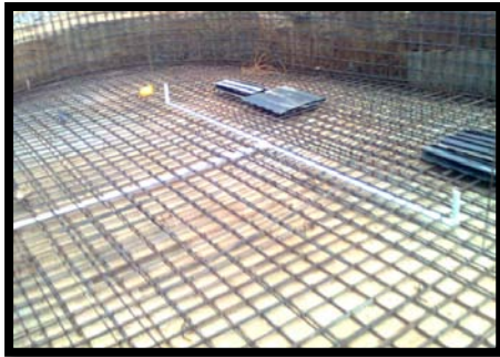
Foto 30, Ubicación de sifones de desagüe de 2". Fuente Propia
