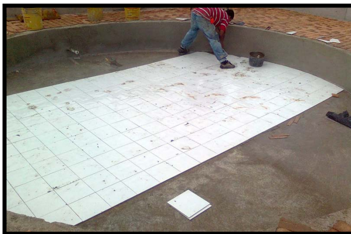
Foto 35, Piscina niños en instalación de enchapes. Fuente Propia
