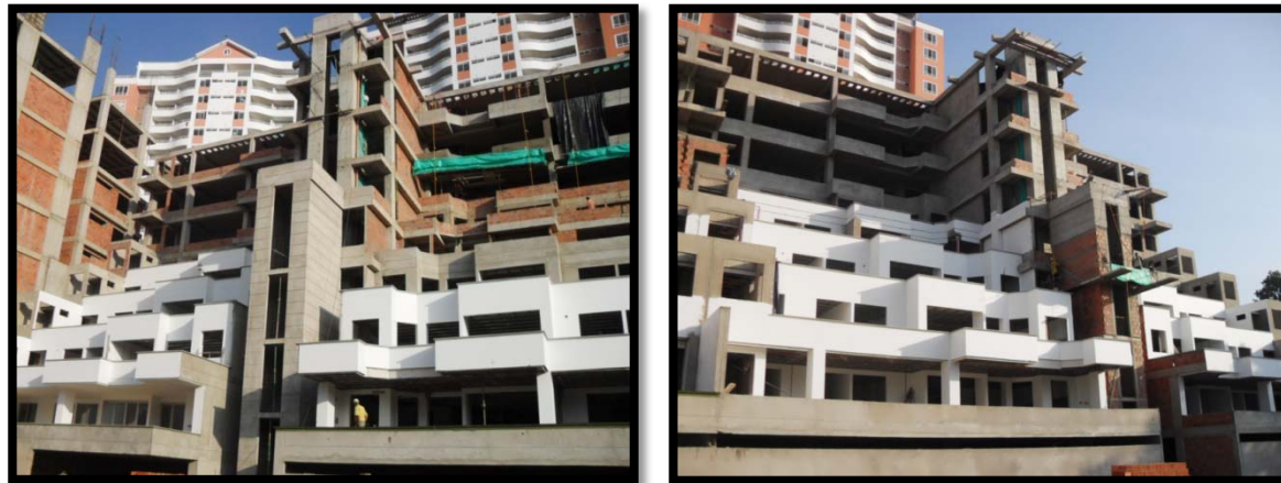
Fotos 14 y 15, Fachada del Proyecto Firenze Viviendas Mediterráneas. Fuente Propia
