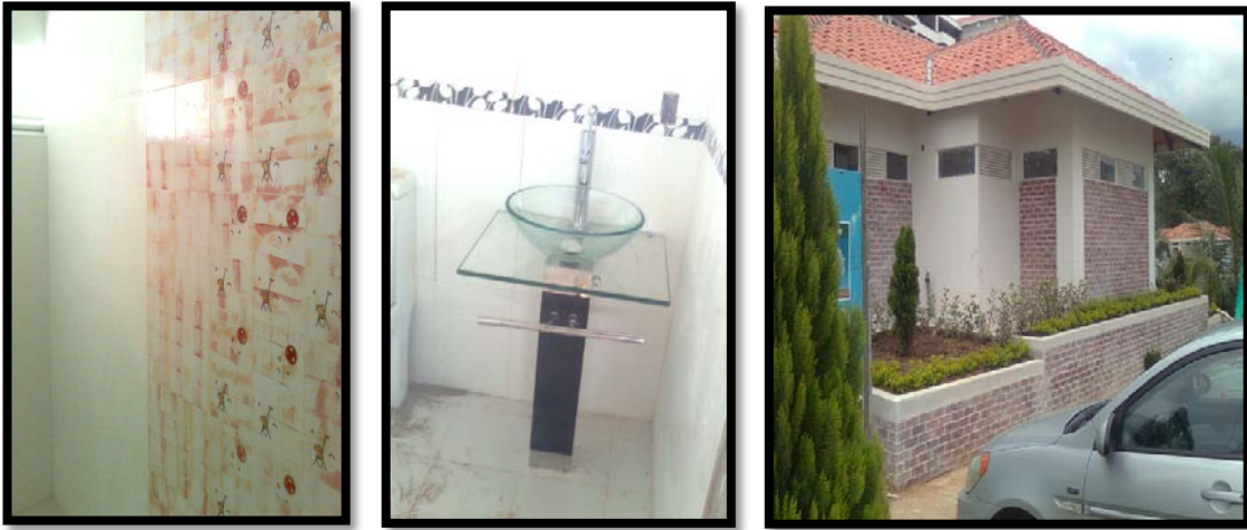
Fotos 52, 53 y 54, Detalle de enchape de baños Guardería y fachaleta posterior. Fuente Propia
