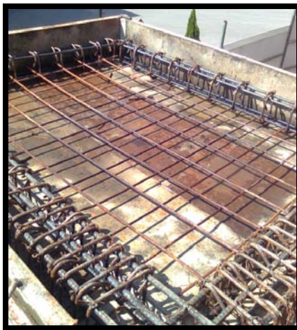
Fotos 40 y 41, Detalle de placa y vigas aéreas. Fuente Propia
