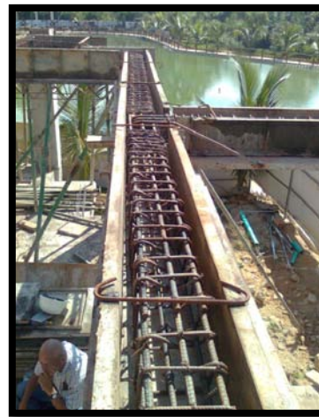
Fotos 40 y 41, Detalle de placa y vigas aéreas. Fuente Propia
