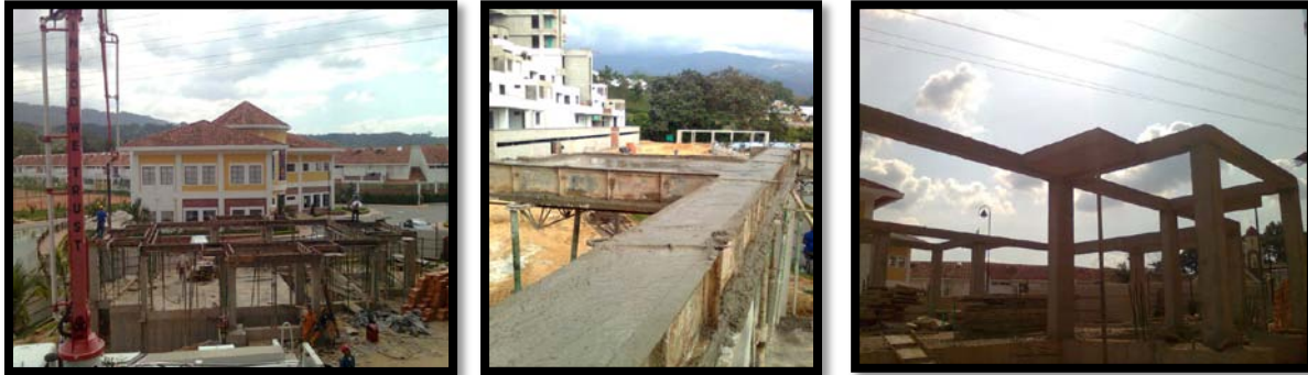
Fotos 42, 43 y 44, Detalles del proceso de fundida, extendida y terminación de placas y vigas áreas de guardería. Fuente Propia
