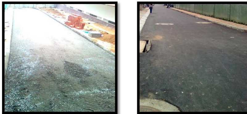
Fotos 72 y 73, Base y asfalto extendido sobre la vía respectivamente, Fuente Propia
