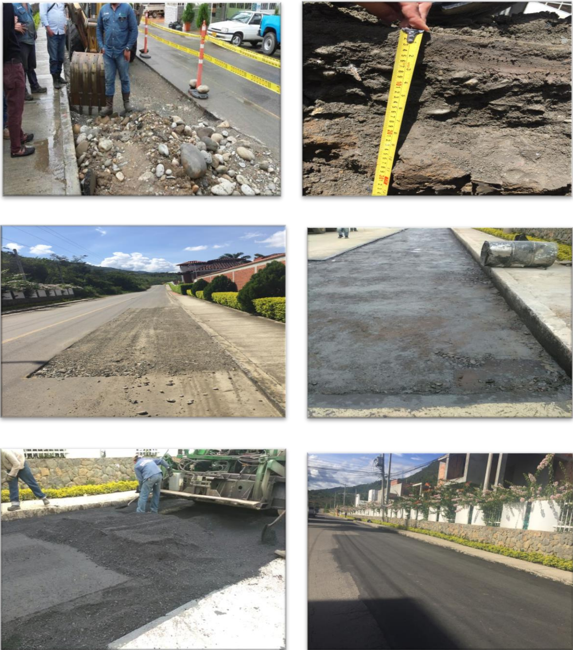
Ilustración 13. Pavimentación Barrio Bella Isla
