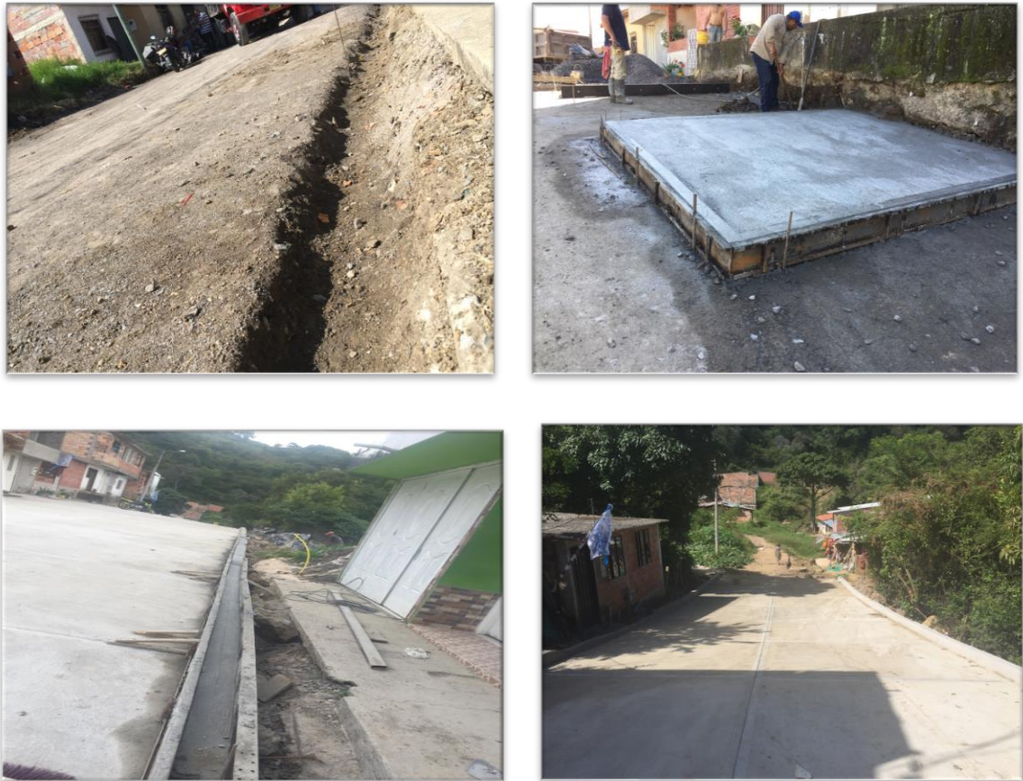
Ilustración 17. Pavimento rígido de la carrera 23 entre calles 4 sur y 5 sur
