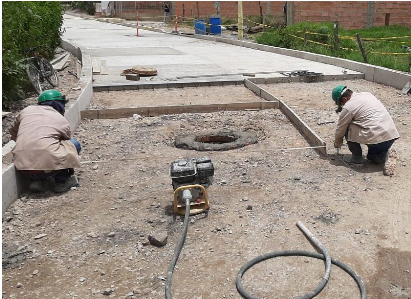
FOTOGRAFÍA 11 Instalación de formaletas de madera
