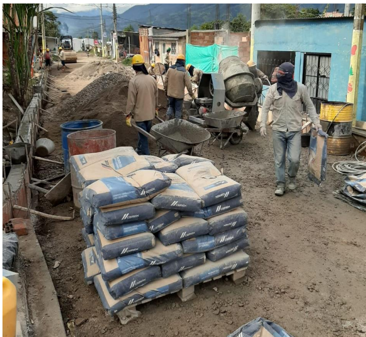
FOTOGRAFÍA 13 Mezclado del concreto
