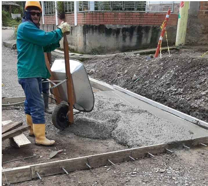
FOTOGRAFÍA 14 Vaciado de Concreto de 41 MR
