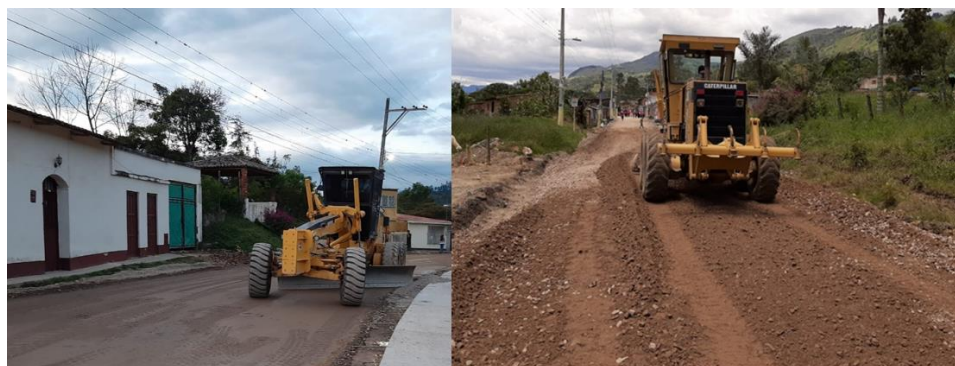
FOTOGRAFÍA 4 Nivelación de base con moto- niveladora
