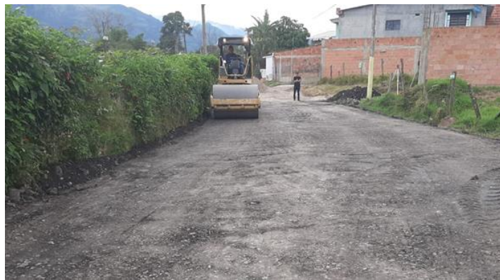
FOTOGRAFÍA 3 Sellado de rasante.
