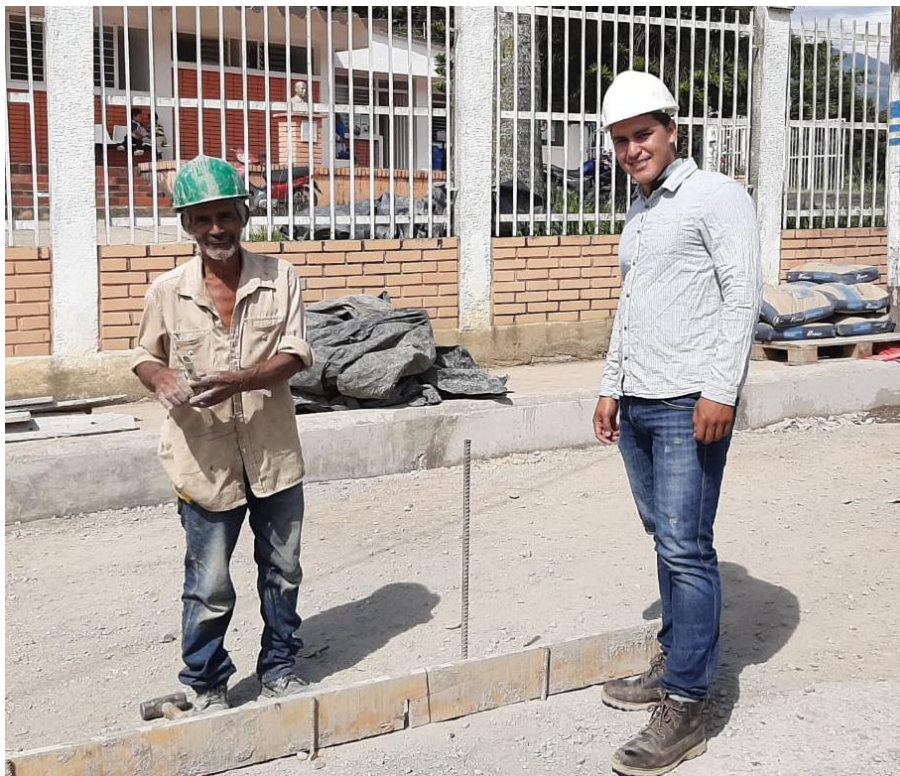
FOTOGRAFÍA 30 Instalación de Formaletas de Madera
