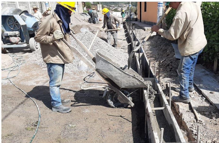
FOTOGRAFÍA 29 Elaboración de Bordillos en Concreto de 3000 PSI
