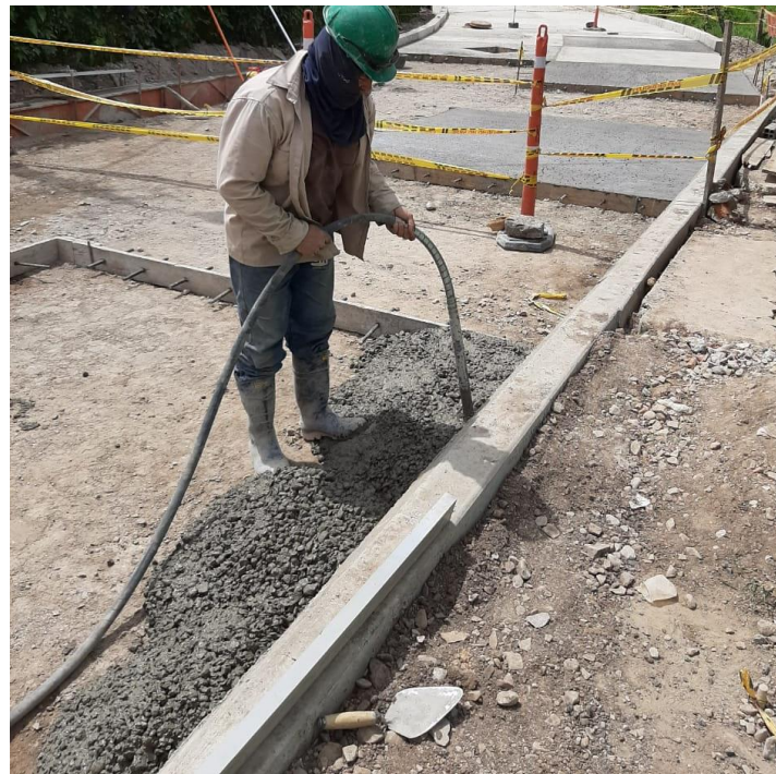
FOTOGRAFÍA 15 Vibrado del concreto
