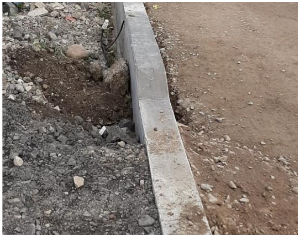
FOTOGRAFÍA 10 Bordillos de Concreto
