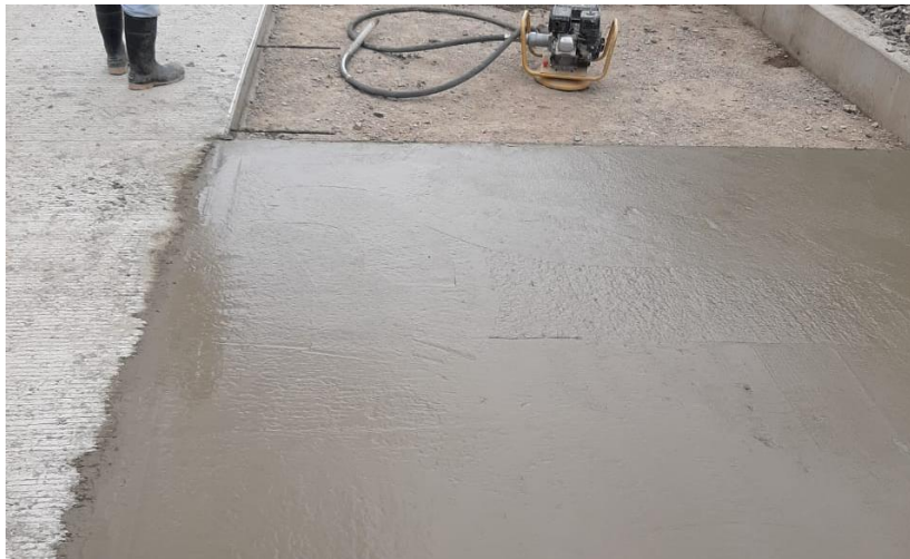
FOTOGRAFÍA 16 Allanado de losa de concreto
