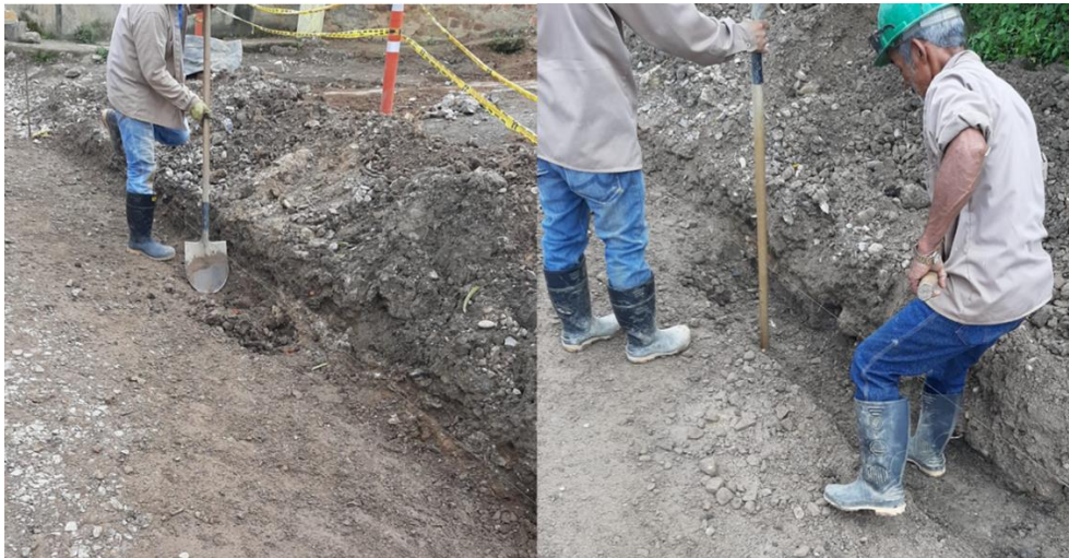
FOTOGRAFÍA 6 Excavación de bordillos
