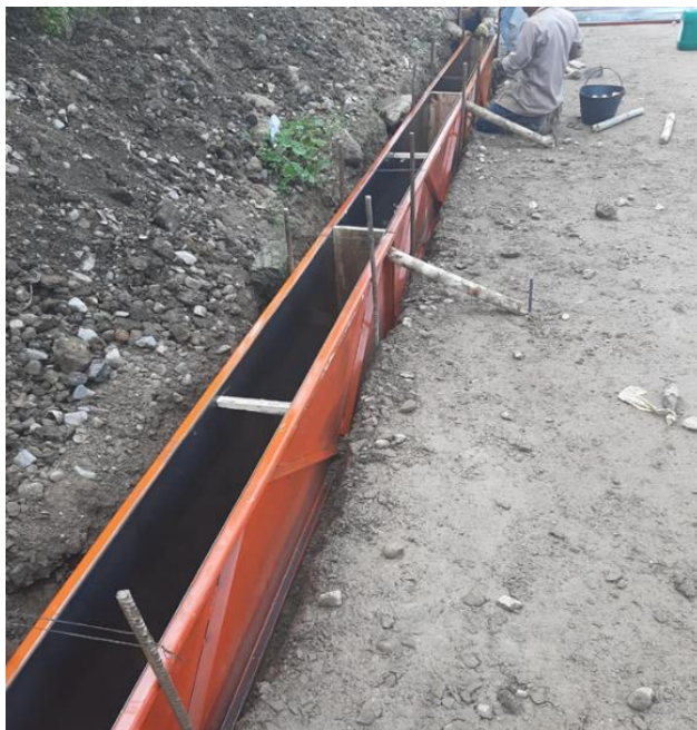
FOTOGRAFÍA 7 Instalación de formaleta
