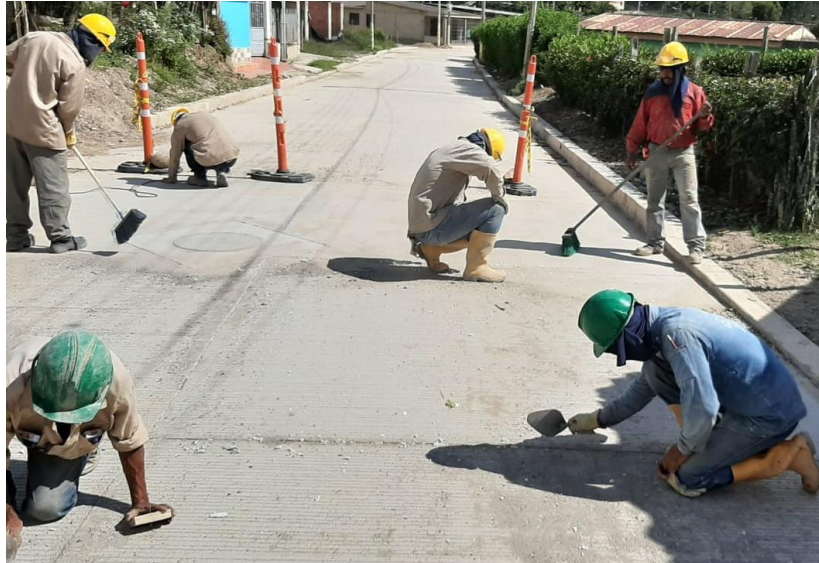
FOTOGRAFÍA 19 Personal Instalando las juntas de las losas en concreto.
