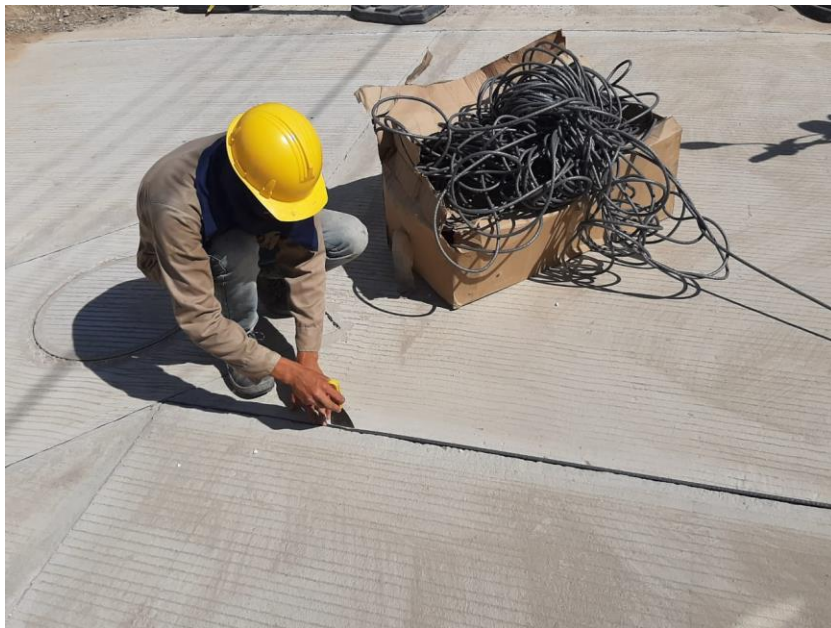
FOTOGRAFÍA 20 Instalación de membrana de poliuretano
