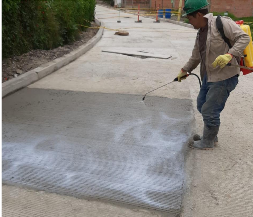
FOTOGRAFÍA 18 Aplicación de Anti- Sol
