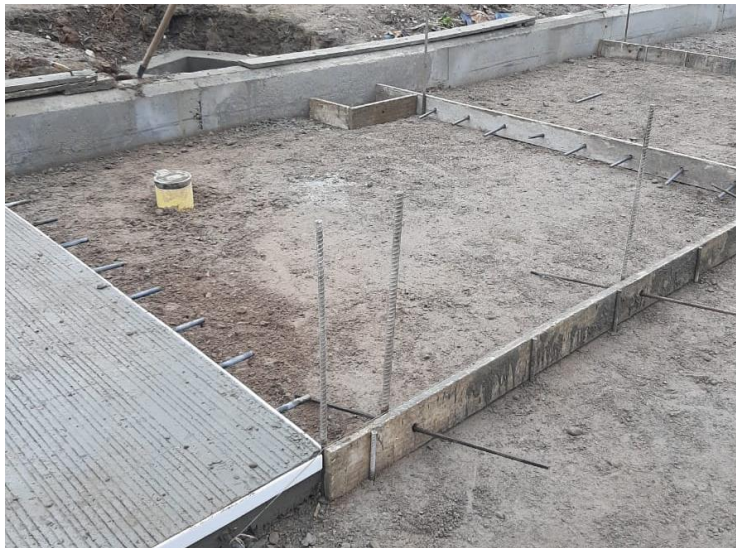
FOTOGRAFÍA 12 Instalación de Acero
