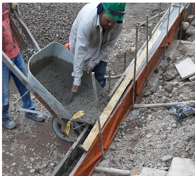
FOTOGRAFÍA 8 Vaciado de Concreto
