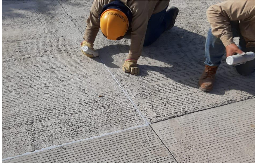
FOTOGRAFÍA 21 Instalación de SIKAFLEX para sellado de juntas
