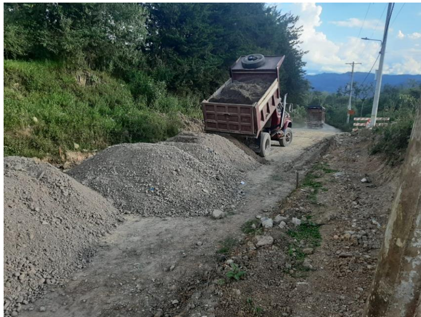
FOTOGRAFÍA 22 Almacenamiento de Materiales de Cantera
