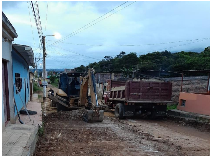
FOTOGRAFÍA 2 Excavación y cargue de material
