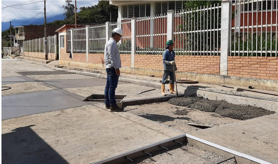
FOTOGRAFÍA 28 Elaboración de Losas en Concreto In-situ
