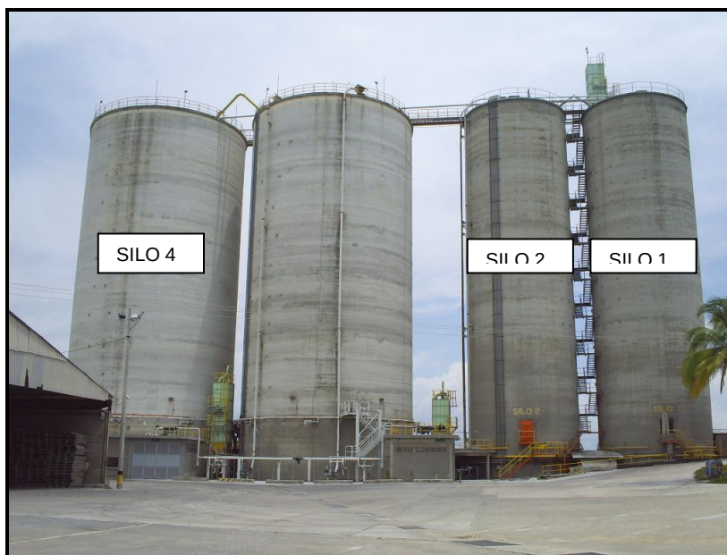
Figura 7. Fotografía del patio de silos.
