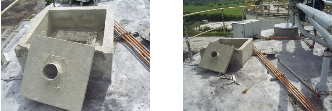
Figura 6. Abertura de escotillas superiores para el sondeo.
