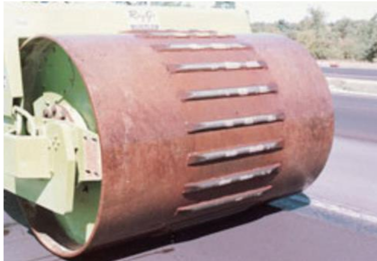
Figura 52. Conformación de bandas sonoras mediante amasado.
