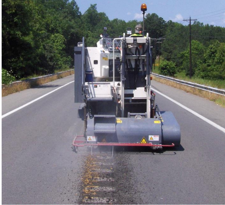
Figura 51. Conformación de bandas sonoras mediante fresado.
