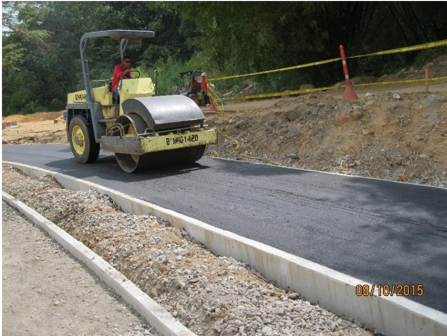
FIGURA 31. Compactación y sello de pavimento flexible.
