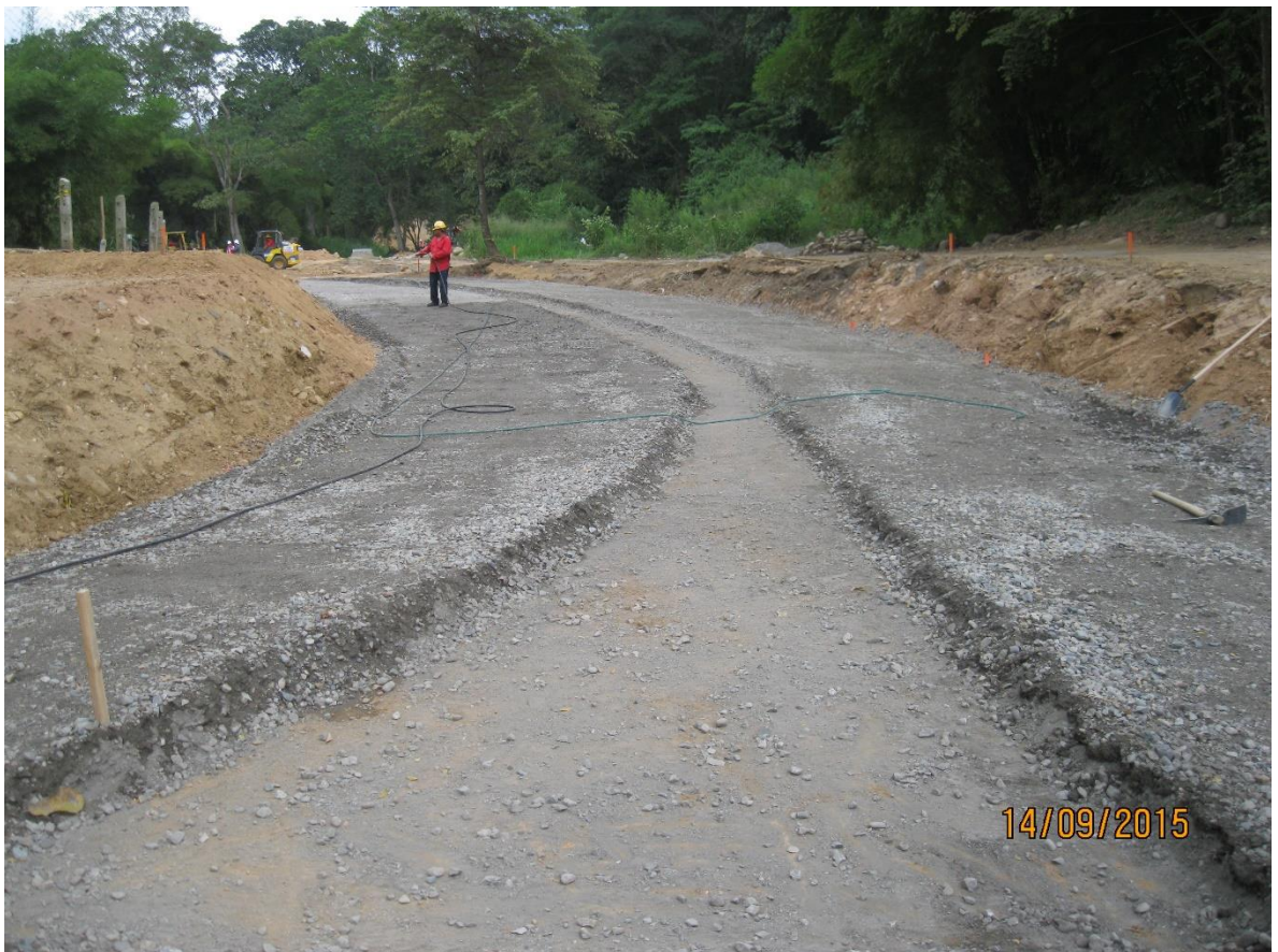
FIGURA 19. Vista final de base granular
