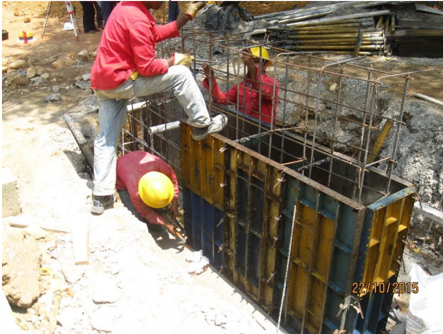
FIGURA 34. Instalación formaleta mano portable para Estribo de puente.
