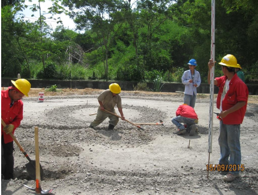
FIGURA 21. Instalación de formaleta para bordillos
