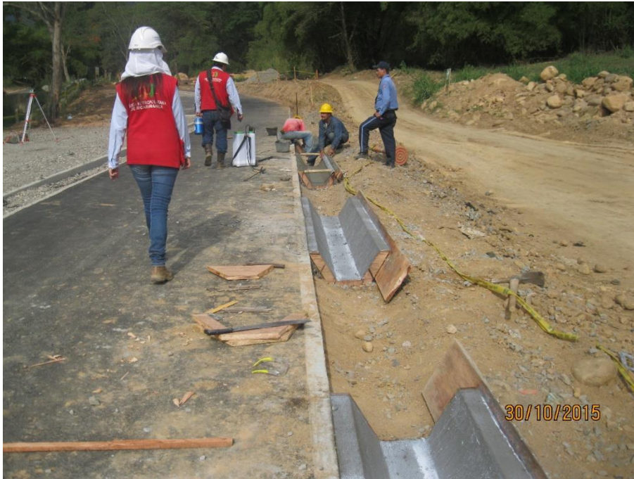
FIGURA 40. Fundición de cunetas.
