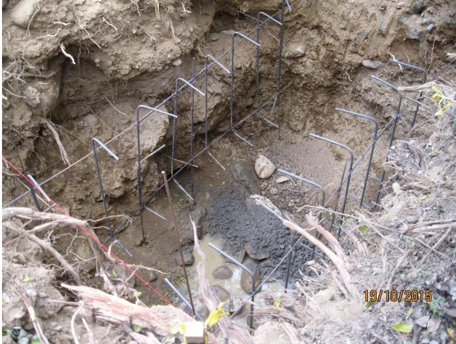
FIGURA 33. Fundición de concreto para zapata.
