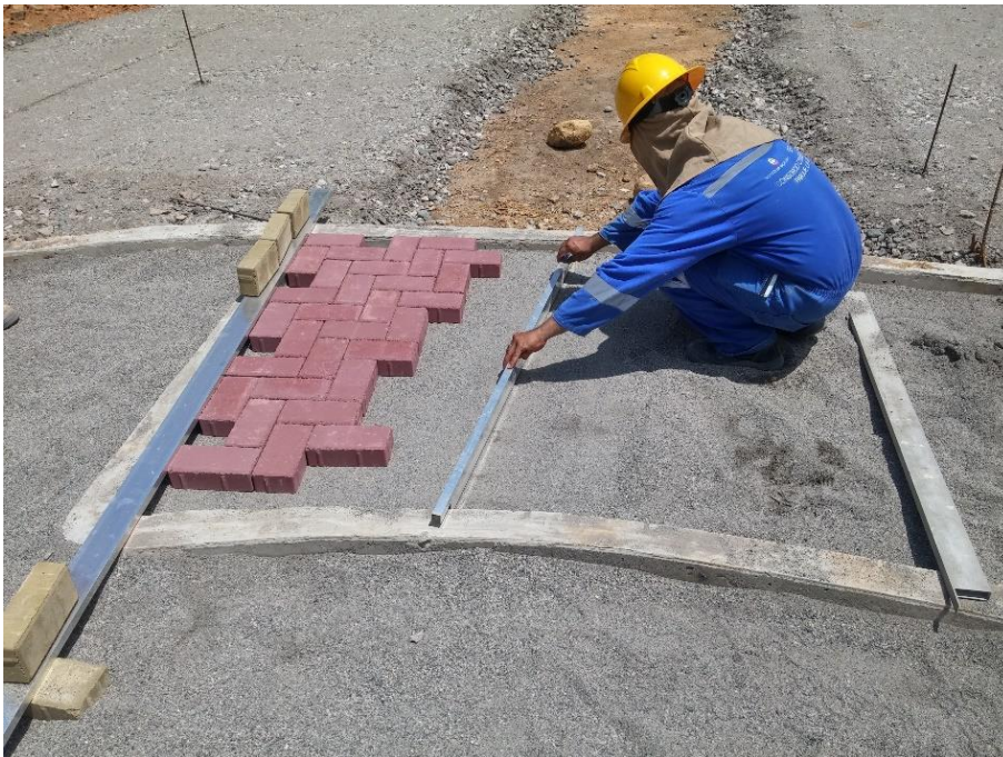
FIGURA 24. Instalación de adoquines.
