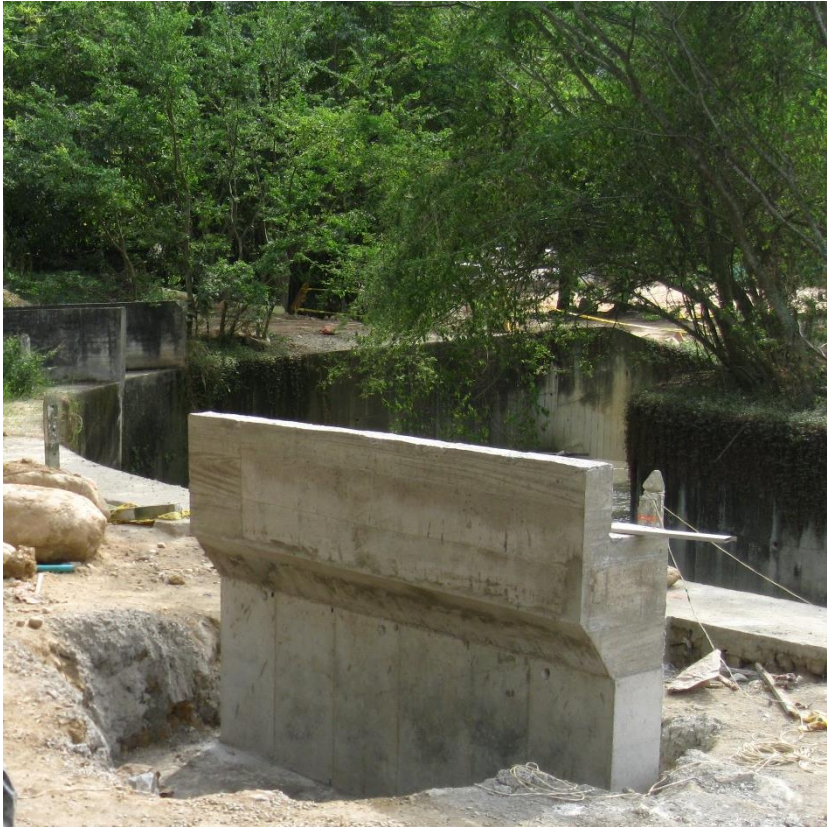
FIGURA 37. Instalación de formaleta para plaza de puente.
