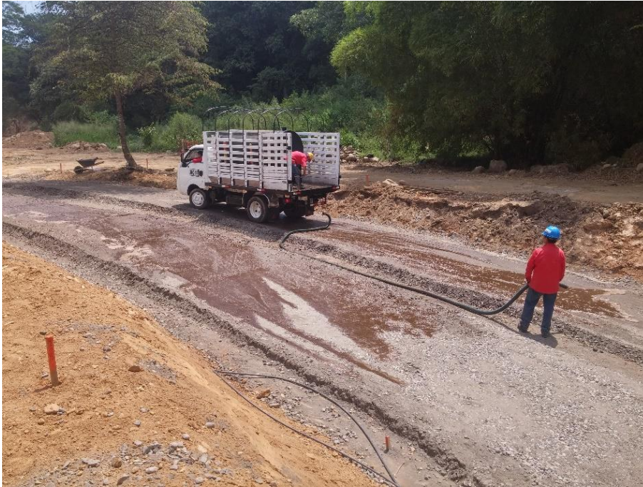
FIGURA 27. Aplicación del imprimante.
