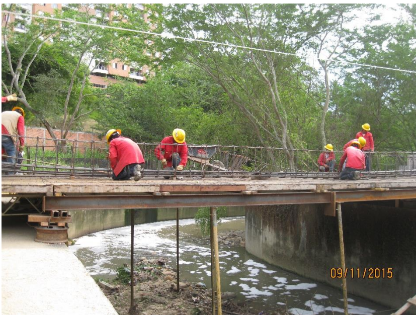
FIGURA 37. Instalación de formaleta para plaza de puente.
