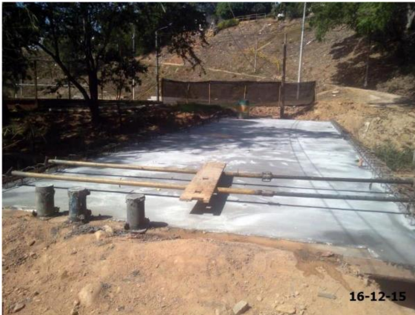
FIGURA 39. Placa de puente fundida y curada.
