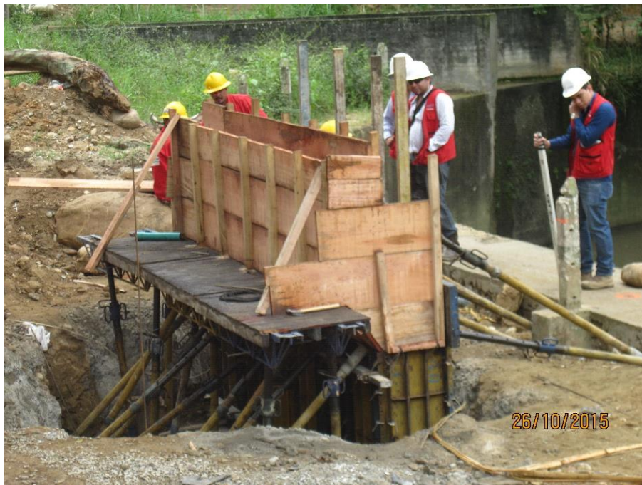
FIGURA 35. Formaleta de estribo finalizada.
