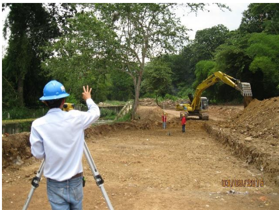
FIGURAS 15 y 16. Nivelación de terreno
