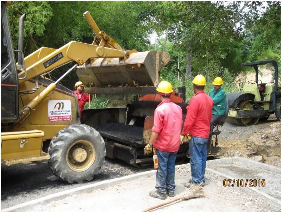
FIGURA 28. Aplicación de pavimento flexible en caliente.
