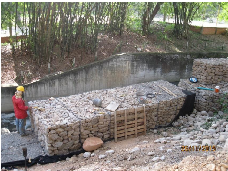
FIGURAS 47. Construcción de gaviones.
