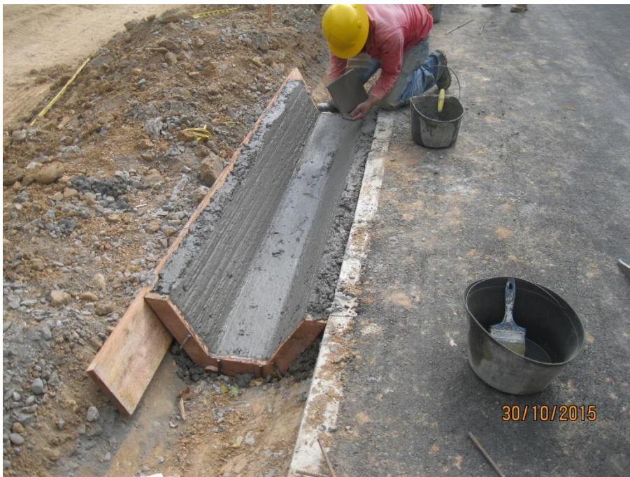
FIGURA 41. Fundición de cunetas.
