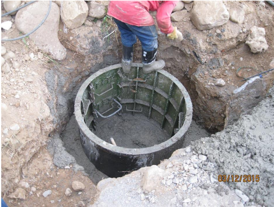
FIGURA 43. Excavación para tubería de red de alcantarillado.
