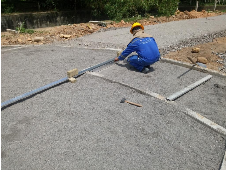
FIGURA 23. Riego de arena de asiento e instalación del cuadro.
