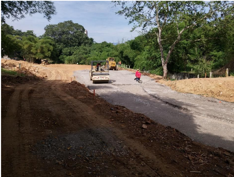
FIGURA 26. Preparación para aplicación del imprimante.
