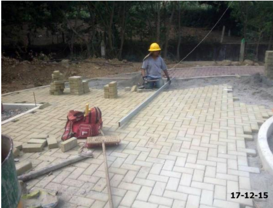
FIGURA 25. Instalación de adoquines.
