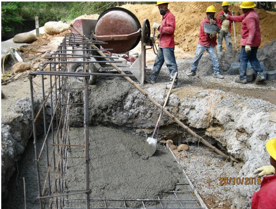
FIGURA 33. Fundición de concreto para zapata.
