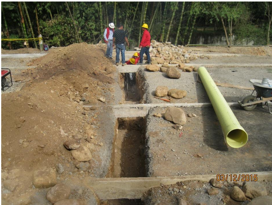
FIGURA 44. Instalación de tubería para red de alcantarillado.
