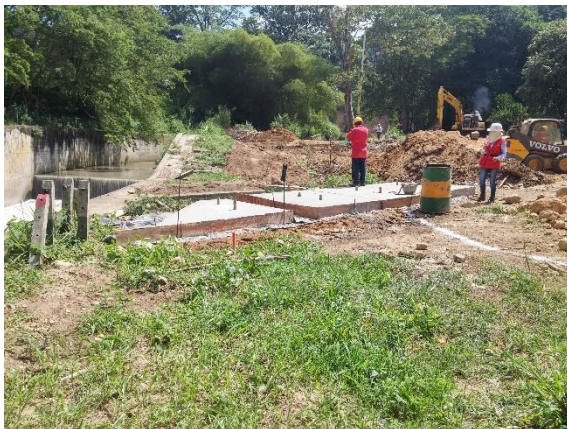
FIGURAS 45 y 46. Fundido de placas para canal.
