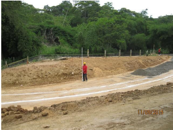
FIGURAS 17 y 18. Aplicación de base granular
