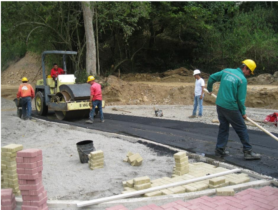
FIGURA 30. Compactación y sello de pavimento flexible.
