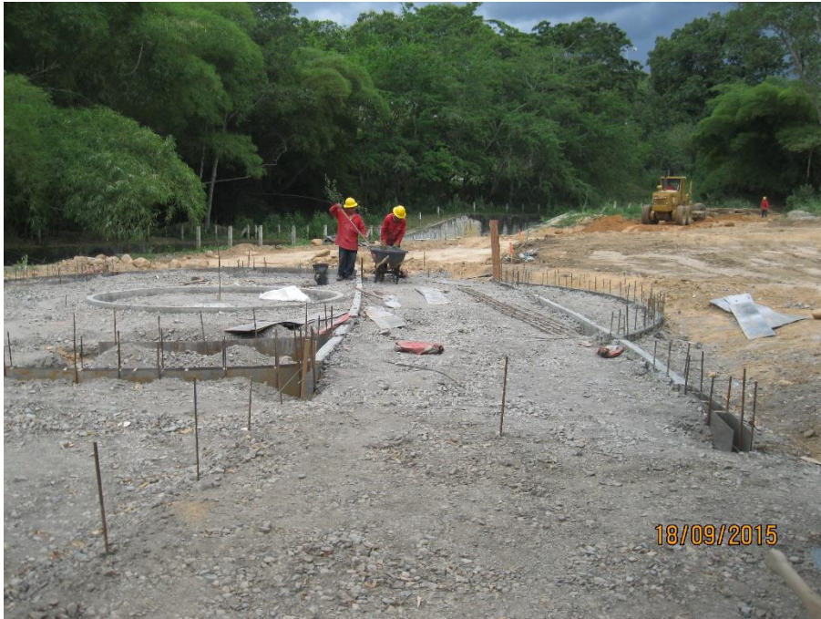
FIGURA 22. Fundición de bordillos
