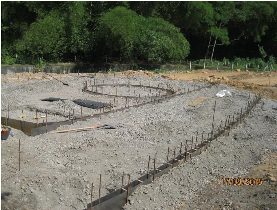
FIGURA 21. Instalación de formaleta para bordillos
