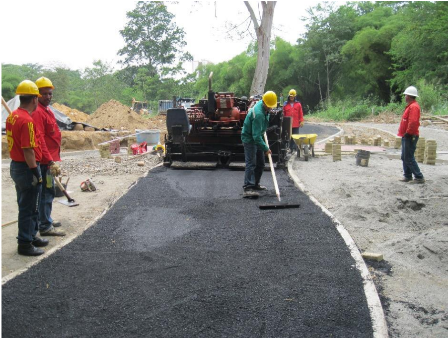
FIGURA 29. Aplicación de pavimento flexible en caliente.
