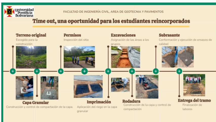
Figura 3. Paso a paso de la construcción del pavimento flexible
