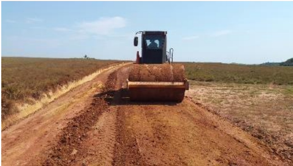
Figura 4. Proceso de compactación Campo – Quifa SW
