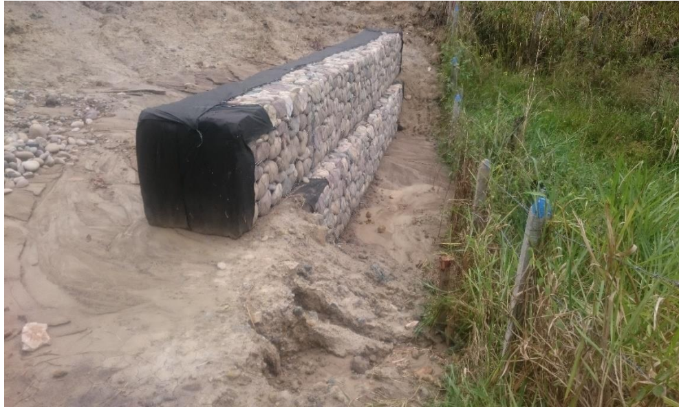
Figura 2. Construcción de 90 m3 Gaviones en el zodme 2
