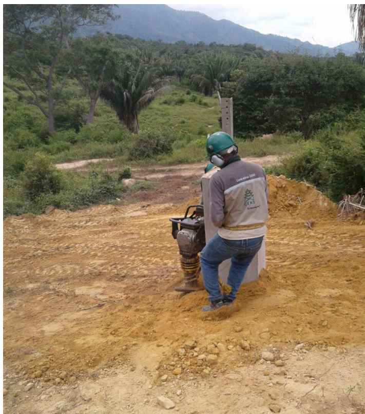
Imagen 24. Compactación a nivel del terreno natural con saltarín.
