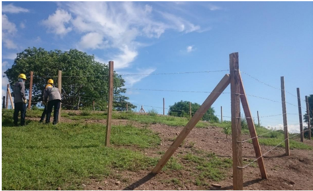
Imagen 12. Encerramiento del sitio de torre con 5 hiladas de alambre de púa como lo sugieren las especificaciones
