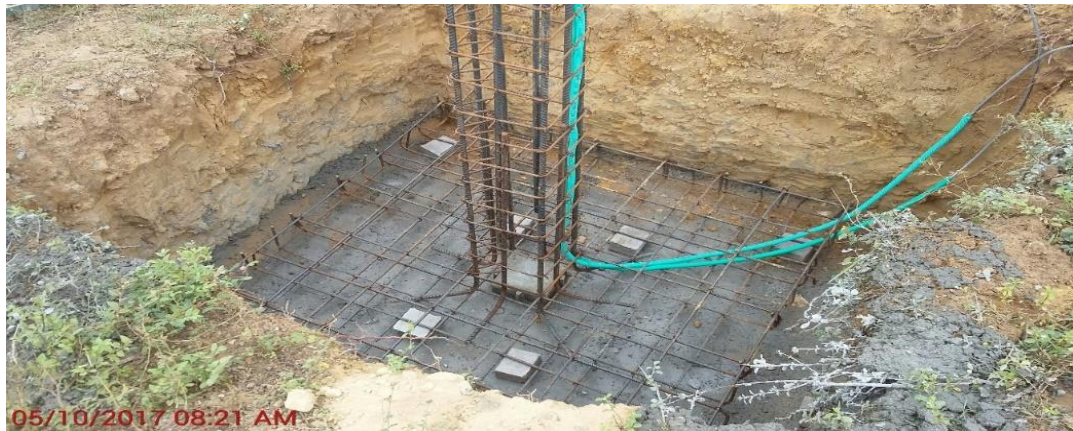
Imagen 16. Instalación de acero de refuerzo de zapata y pedestal.
