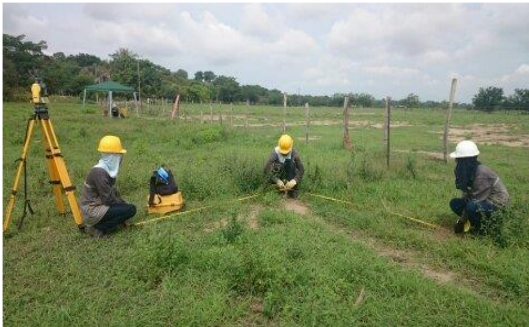
Imagen 11. Marcación de las patas de la torre
