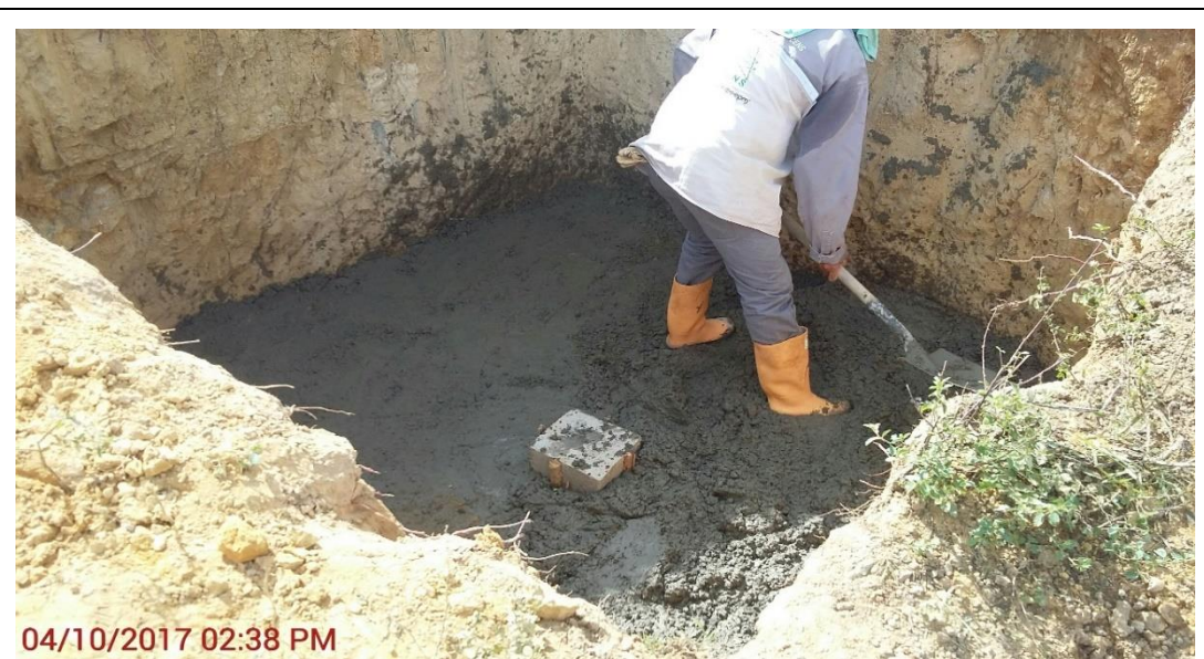
Imagen 15. Vaciado de solado con espesor de 5 cm
