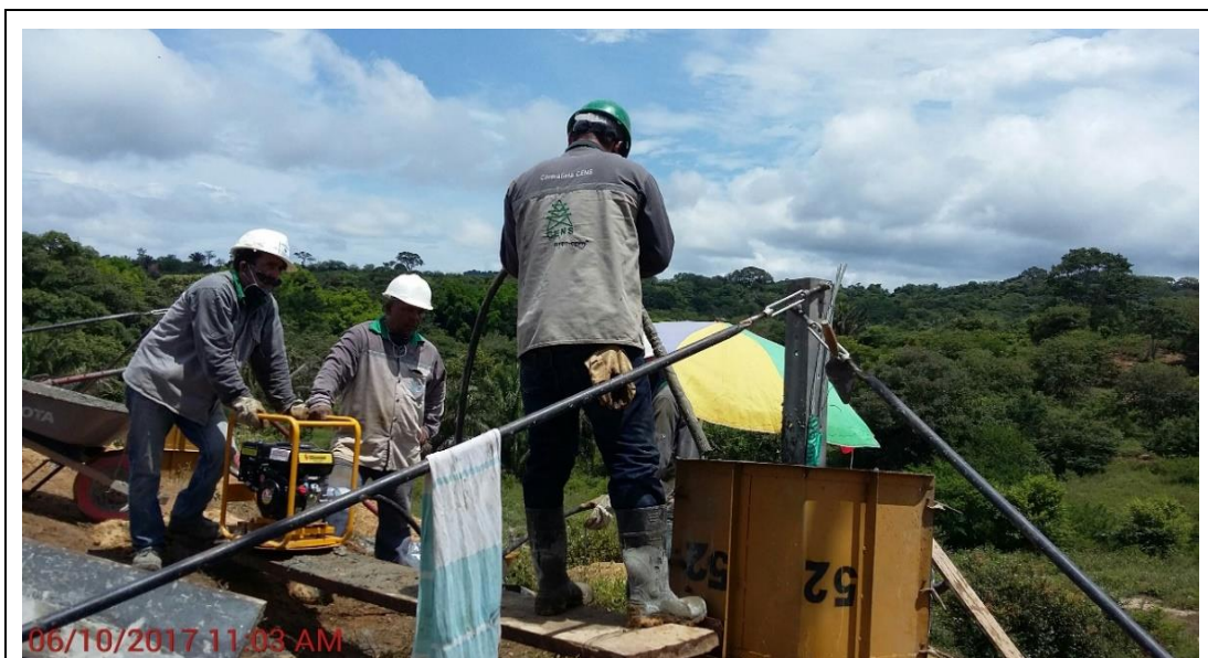
Imagen 18. Vibrado en el concreto de zapatas y pedestales.
