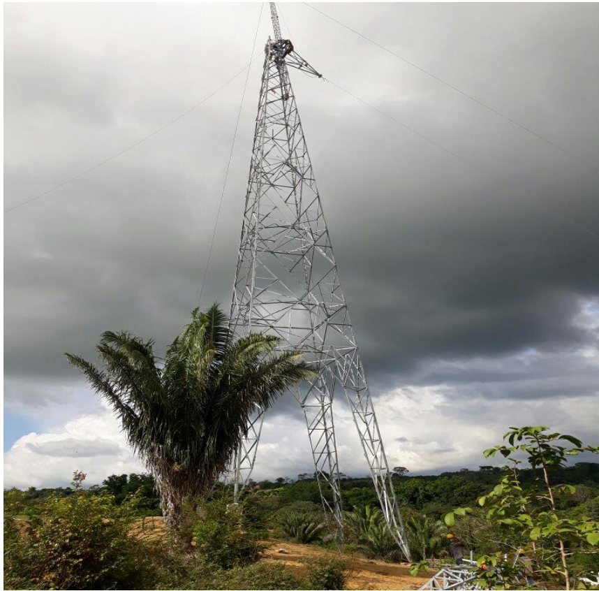
Imagen 25. Montaje de torre 89, se puede observar el tipo de pedestales y de patas de torre que se utiliza para que esta quede nivelada.
