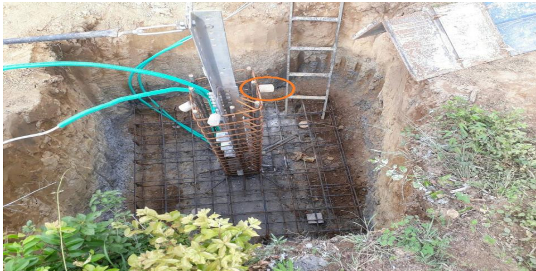
Imagen 17. Nivelación de stub.
