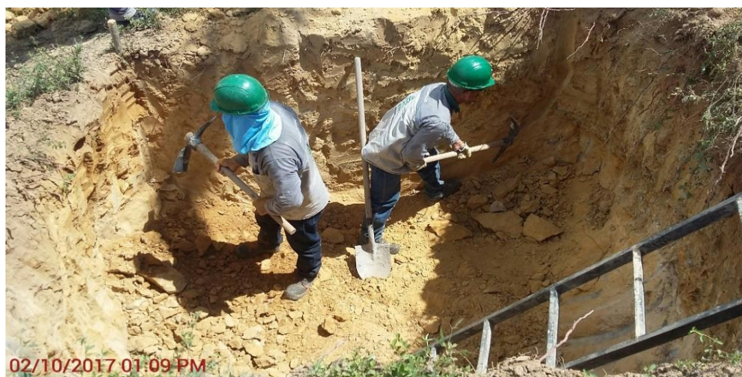
Imagen 13. Excavación mecánica y posteriormente intervención manual debido a presencia de material con roca.
