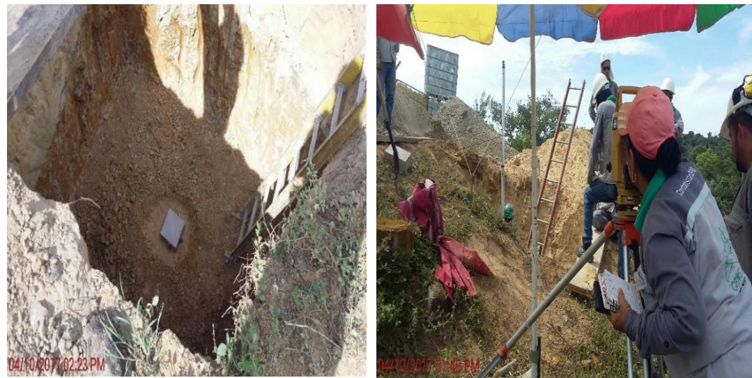
Imagen 14. Nivelación de panela de concreto prefabricada de dimensiones 20*20*10 cm
