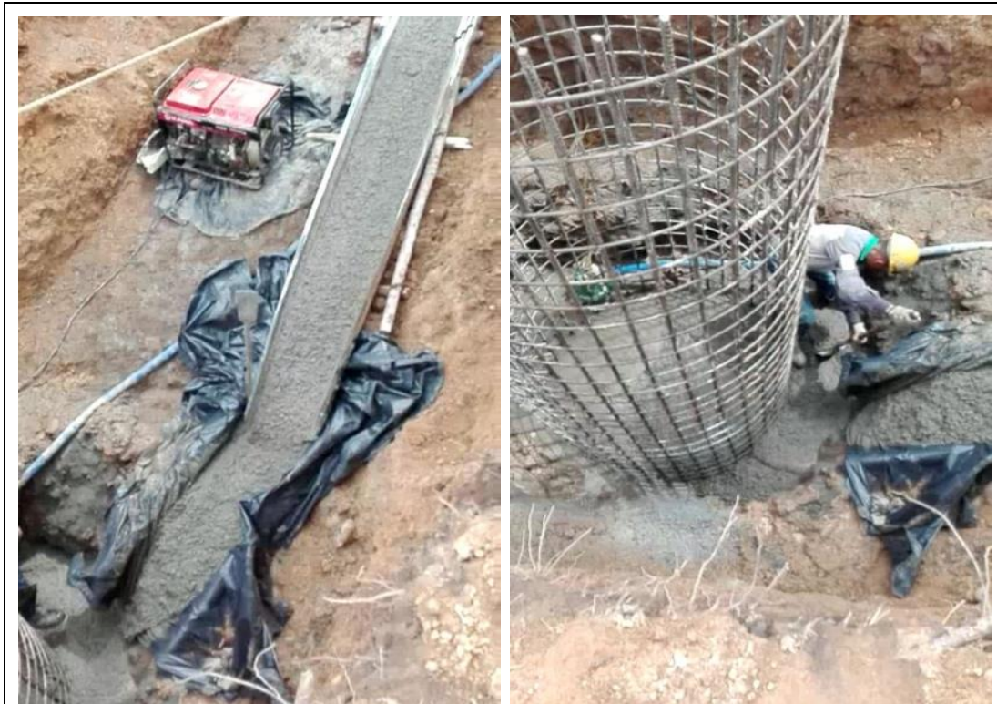
Imagen 20. Vaciado de concreto de primera etapa en caisson tripleta 14, con ayuda de lámina de acero para el vertimiento del concreto.
