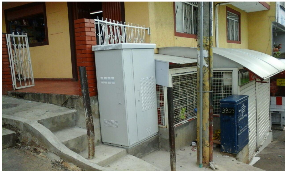
Figura 25 AFO Barrio Santana-Villabel, Instalado, recuperación del andén y del espacio público FUENTE: Autor
