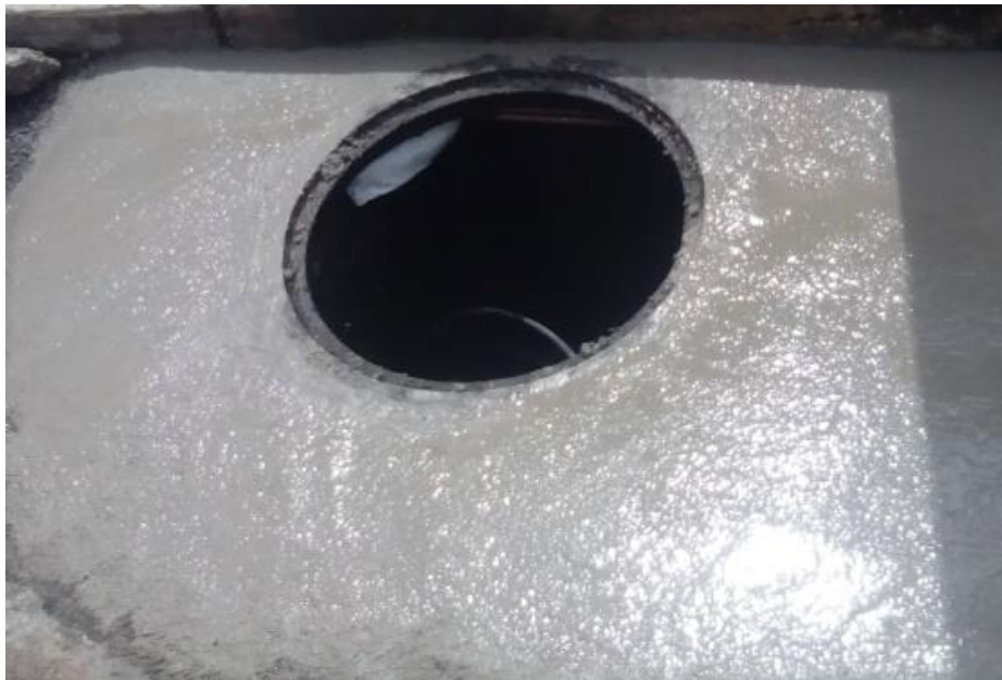
Figura 13 Fundida de losa superior cámara nueva FUENTE: Autor
