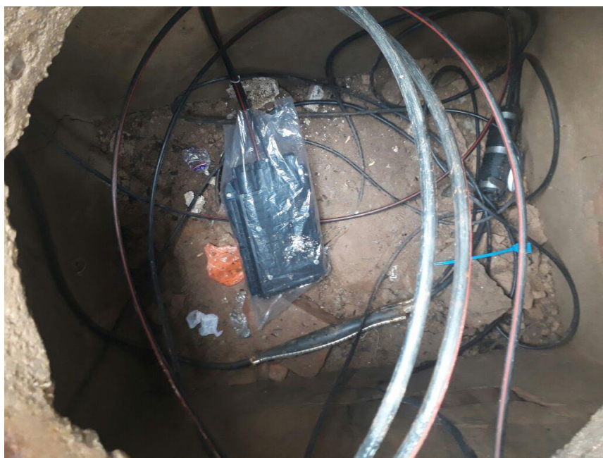
Figura 7 Nap Outdoor instalada y fusionada alojada en cámara de Telebucaramanga FUENTE: Autor
