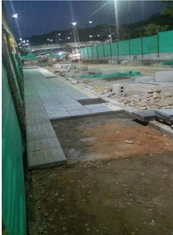
Figura 21 Recuperación de andén y espacio público sector Rincón de Girón por obras de Metrolínea FUENTE: Autor
