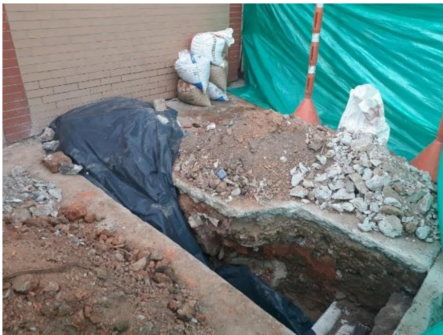
Figura 22 Excavación para encontrar la canalización existente armario frente al Colegio El Rosario Floridablanca
