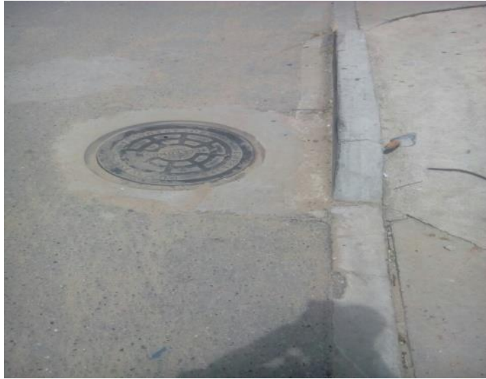
Figura 11 Arreglo de cámara en calzada, reposición de aro y tapa metálica. Calle 52 sector Cabecera. FUENTE: Autor
