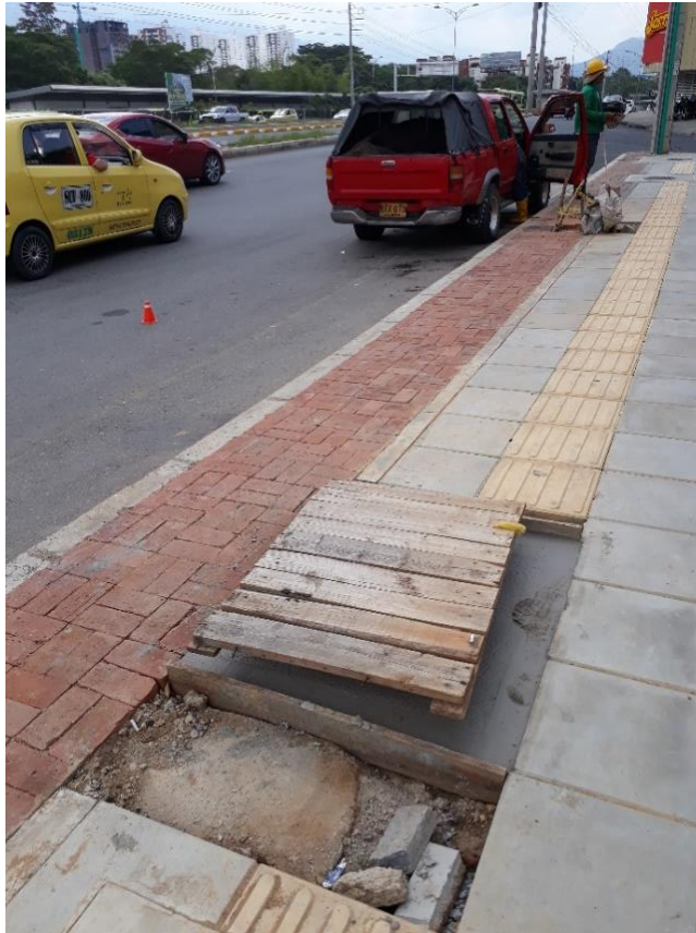
Figura 18 Fundida de losa superior y reposición de andén en el sector del Tercer Carril, Paralela Occidental-sector Diamante II FUENTE: Autor
