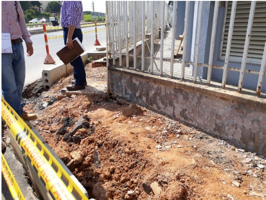
Figura 17 Recuperación de canalización en el sector del Tercer Carril autopista Bucaramanga-Floridablanca
