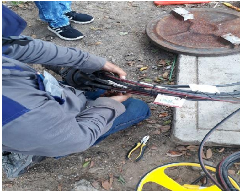
Figura 29 Supervisión del tendido de red FTTH sector San Alonso FUENTE: Autor
