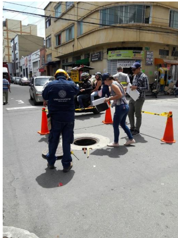
Figura 30 Supervisión del Tendido de la red sector Centro (Cra 18 Cl. 33) FUENTE: Autor
