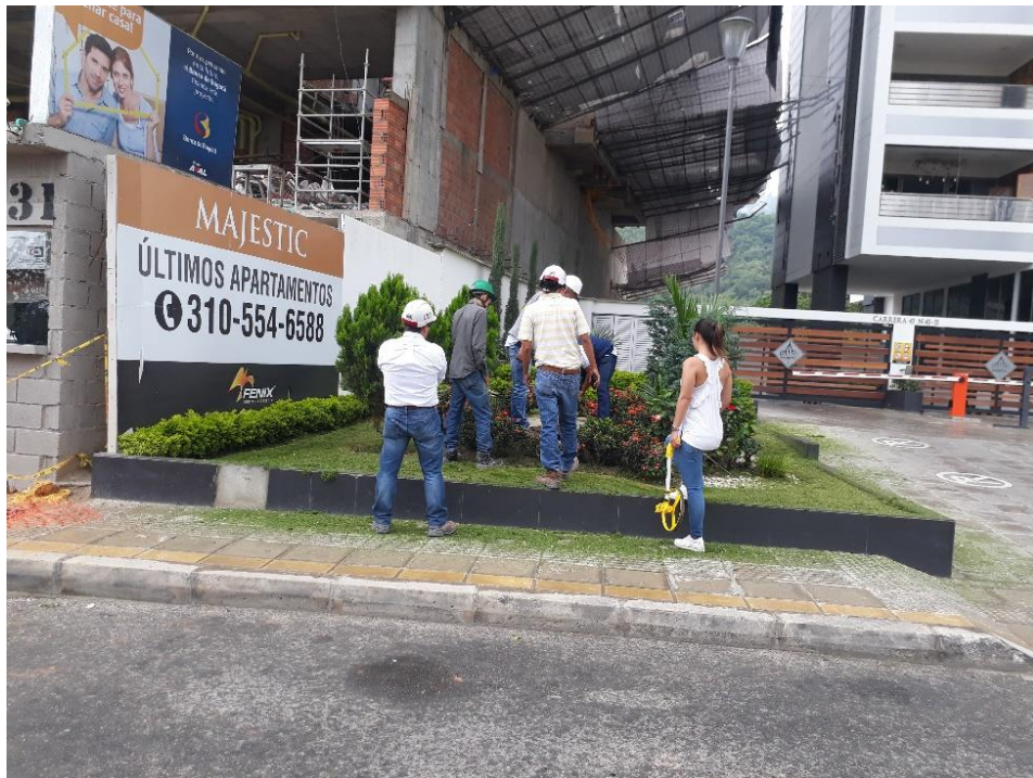
Figura 31 Visita técnica construcción AQUA sector Cabecera. Para empalme de canalización nueva del conjunto con canalización existente FUENTE: Autor
