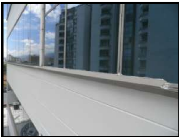
Foto 113. Detalle De Cómo Queda La Alfajía Nueva.
