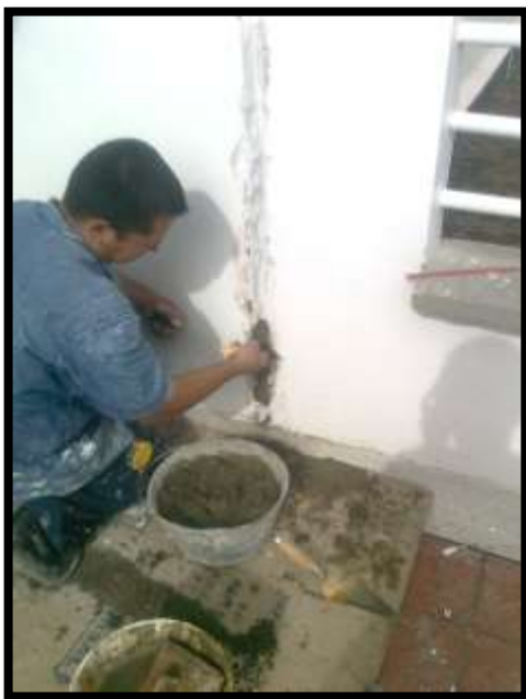
Foto 60. Detalle Del Resane De La Fisura.
