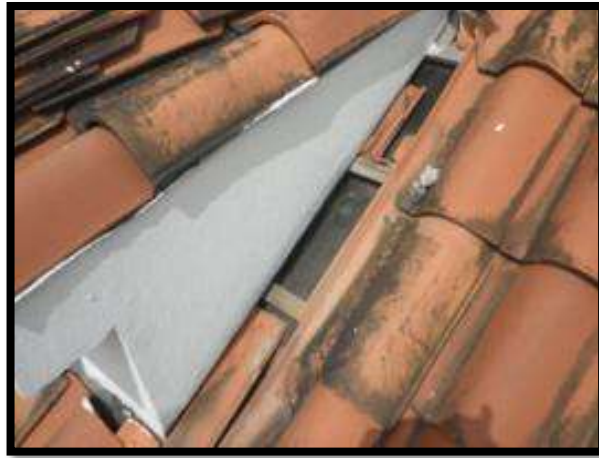
Foto 81. Detalle Lateral Cubierta Plana
