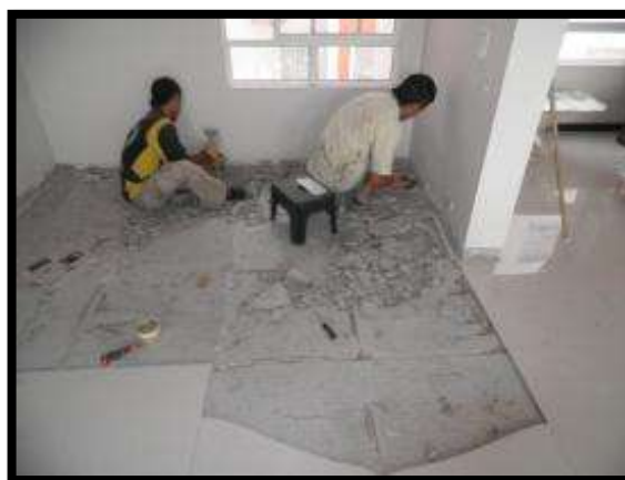
Foto 40. Levantando Material Pegante.
