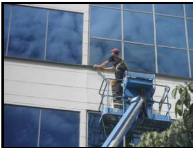
Foto 111. Trabajos en fachada externa.
