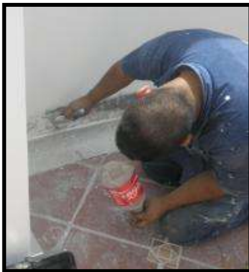
Foto 13. Aplicación De Sikadur 32 Primer.
