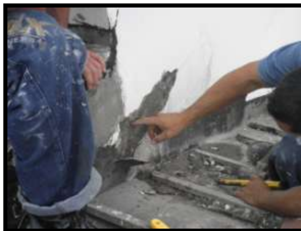
Foto 56. Evidencia De Humedad En La Fisura.
