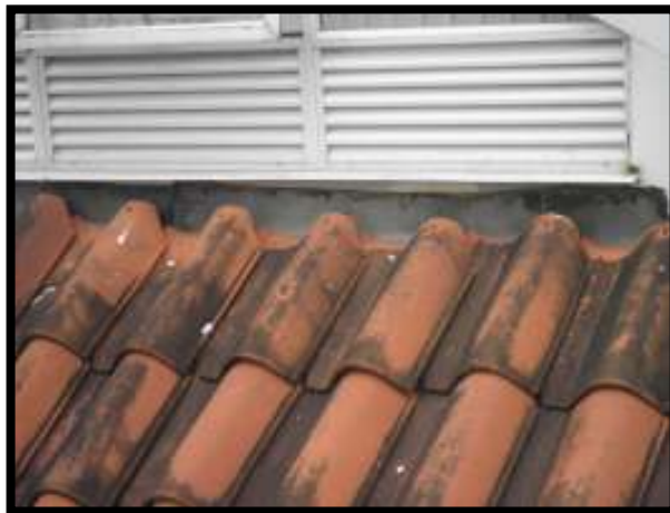
Foto 68. Ventana Triangular Parte Inferior.
