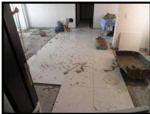
Foto 43. Instalación De Piso En Porcelanato
