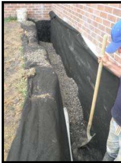
Foto 92. Adición De Triturado Al Interior De La Zanja.
