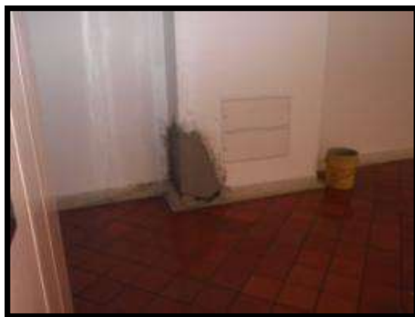
Foto18. Evidencia De La Solución De Acabados.
