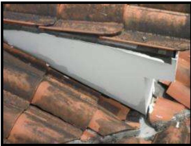
Foto 79. Lateral De Cubierta Plana
