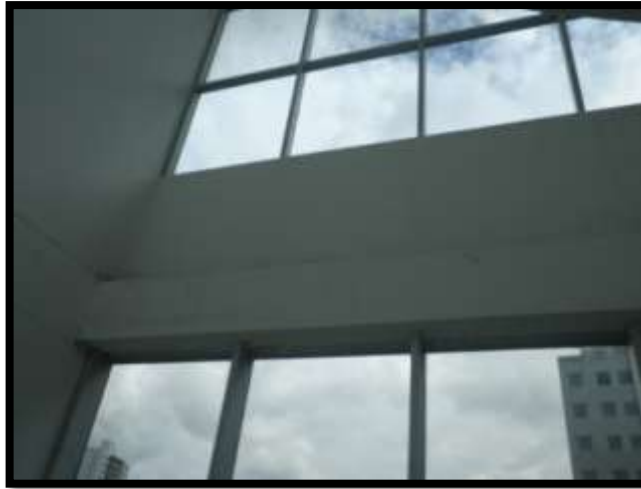
Foto 101. Fachada Interna Edificio Fbc
