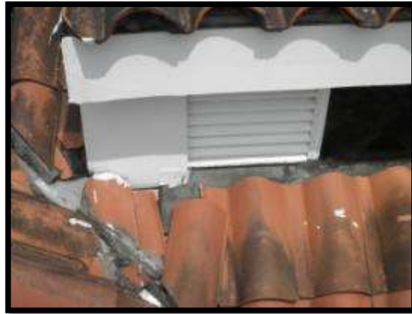
Foto 80. Detalle Frontal Cubierta Plana.
