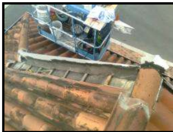
Foto 71. Detalle Ventana Triangular Parte Superior.
