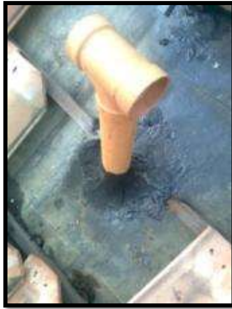
Foto 85. Detalle Reparación Embone De Tubos De Ventilación.
