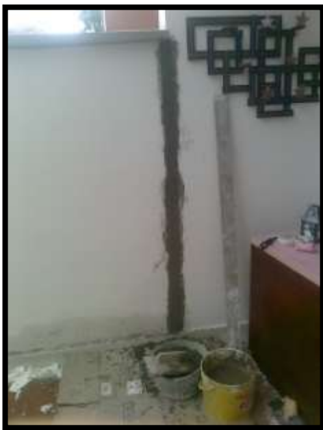
Foto 61 Detalle Del Resane Completo.
