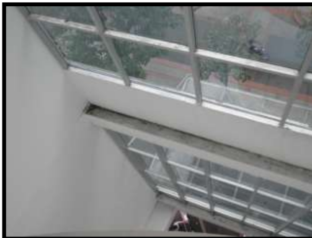
Foto 106. Detalle Recubrimiento De Viga Parte Alta.
