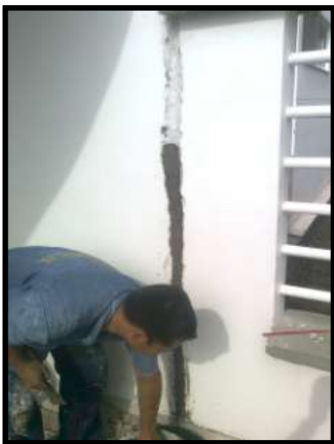
Foto 60. Detalle Del Resane De La Fisura.
