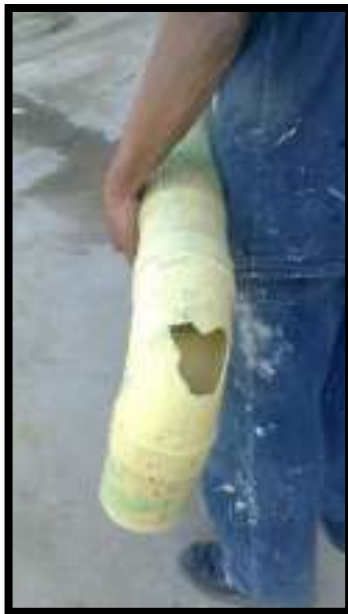
Foto 4. Accesorio 4" PVC Sanitario Roto.
