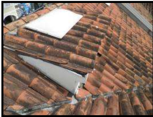
Foto 82. Panorámica Cubierta Plana.
