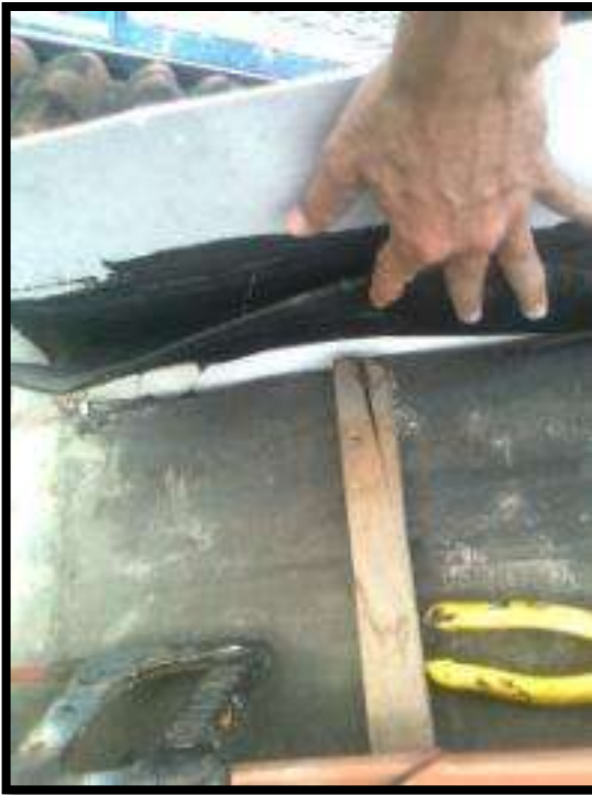
Foto 72. Detalle De Flanche Ventana Triangular Parte Superior.
