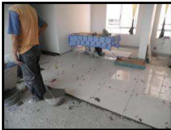
Foto 44. Instalación De Piso En Área De Sala De Tv.
