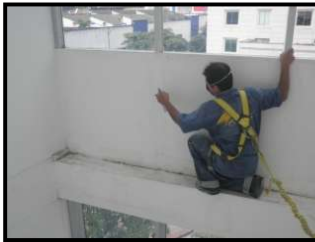
Foto 110. Detalle De Desmanche Del Superboard De La Fachada Interna.
