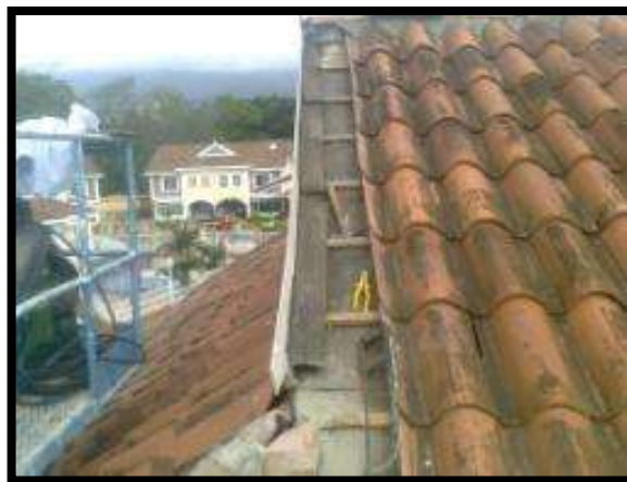
Foto 70. Detalle Ventana Triangular Parte Superior.
