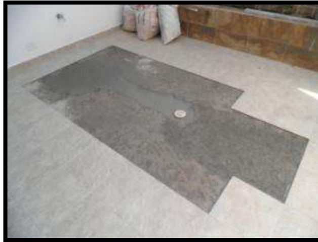
Foto 100. Detalle Del Sifón Trasladado Listo Para Enchapar.
