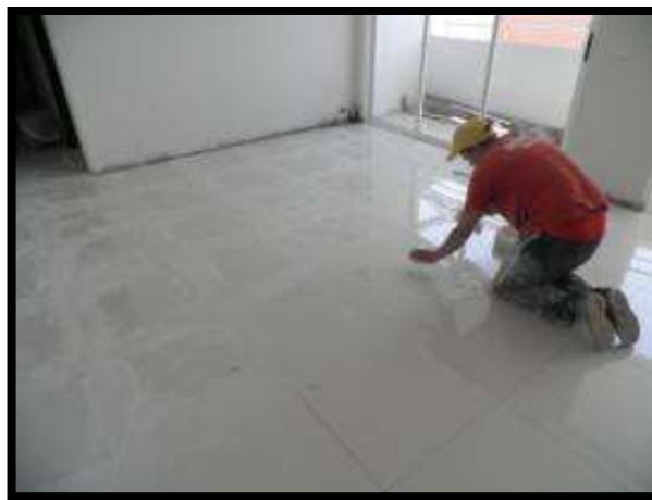
Foto 46. Instalación De Boquilla En Juntas.
