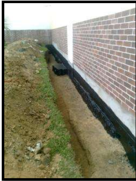
Foto 89. Aplicación De Cemento Denso En La Patera Del Muro.
