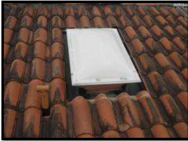
Foto 78. Evidencia De La Solución Claraboyas.
