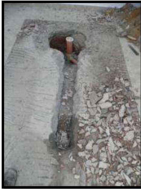
Foto 98. Detalle De La Zanja Para Trasladar El Sifón.
