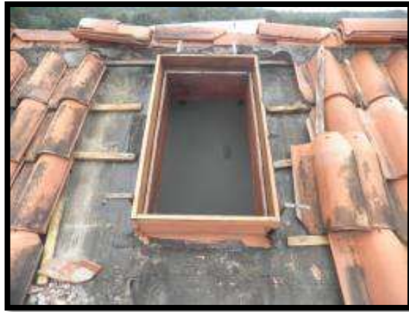
Foto 76. Evidencia De La Solución Claraboyas
