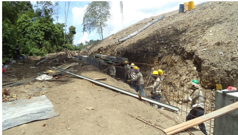
Imagen 29 Amarre de acero para módulos de canal disipador
