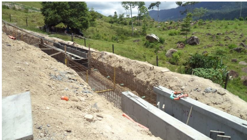
Imagen 31 Amarre de acero y encofrado de módulos de canal disipador
