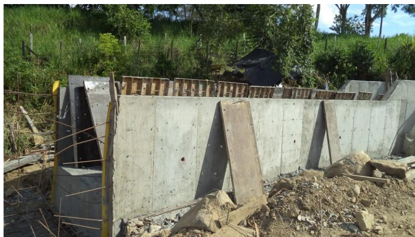
Imagen 19 Desencofrado de módulos de canal disipador
