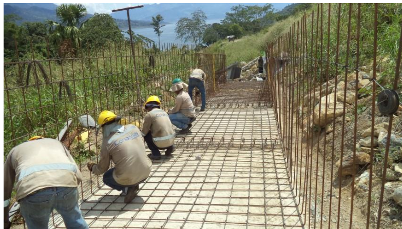
Imagen 27 Amarre de acero para módulos de canal disipador
