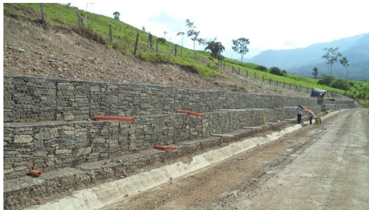
Imagen 49 Finalización de armado de gaviones
