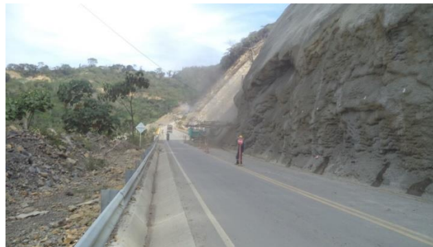
Imagen 39 Perforación para drenes largos
