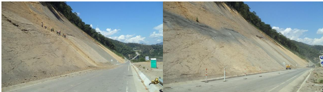
Imagen 54 Concreto lanzado
