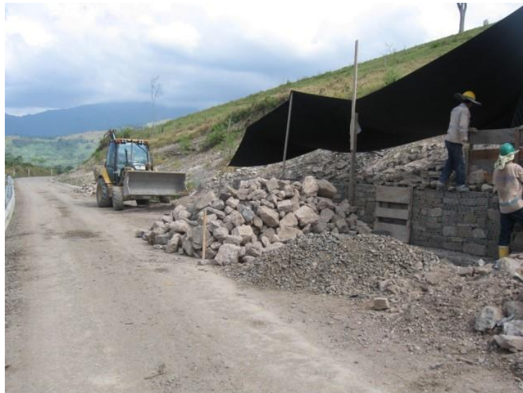
Imagen 37 Armado de gaviones
