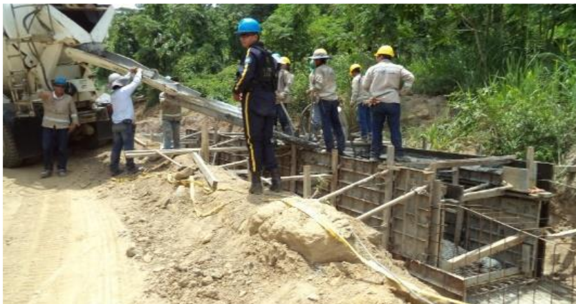
Imagen 25 Fundida de módulos de canal disipador
