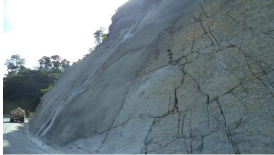
Imagen 50 Concreto lanzado secundario
