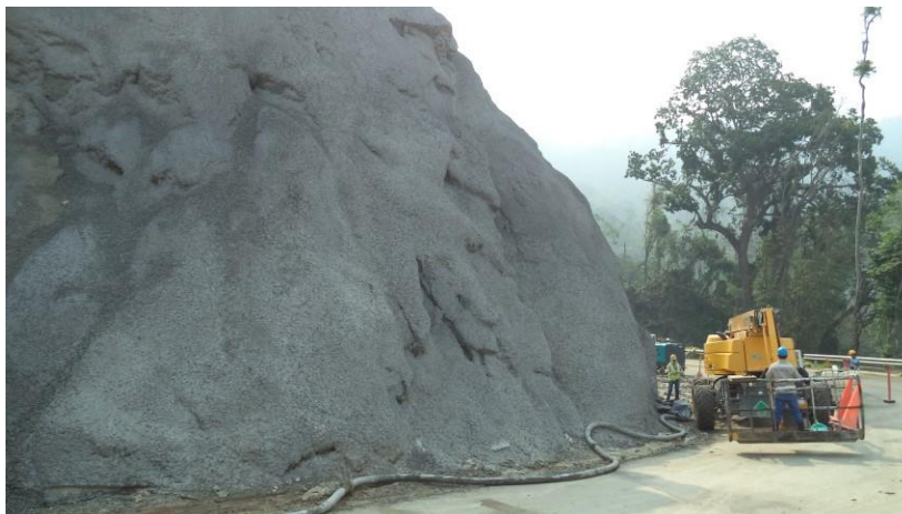
Imagen 43 Concreto lanzado
