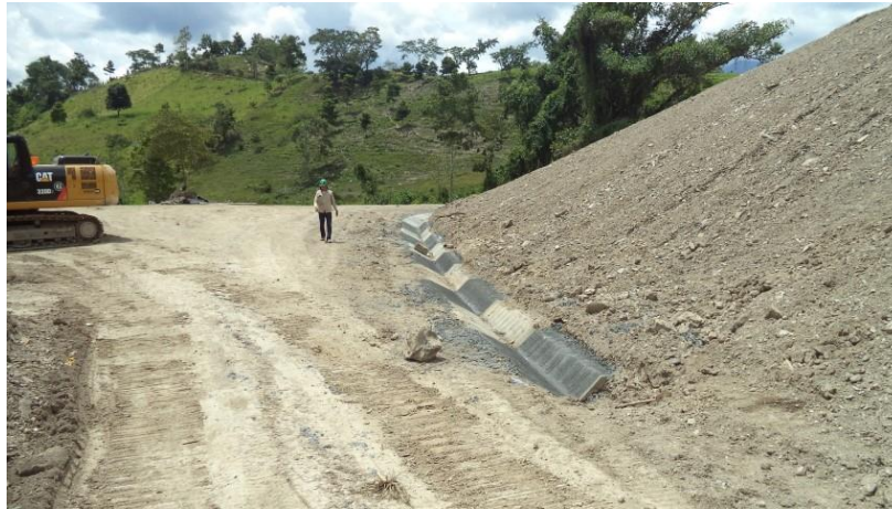
Imagen 30 Fundida de secciones de cuneta berma
