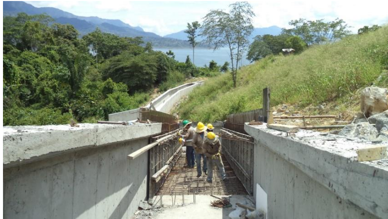
Imagen 28 Encofrado de módulos de canal disipador
