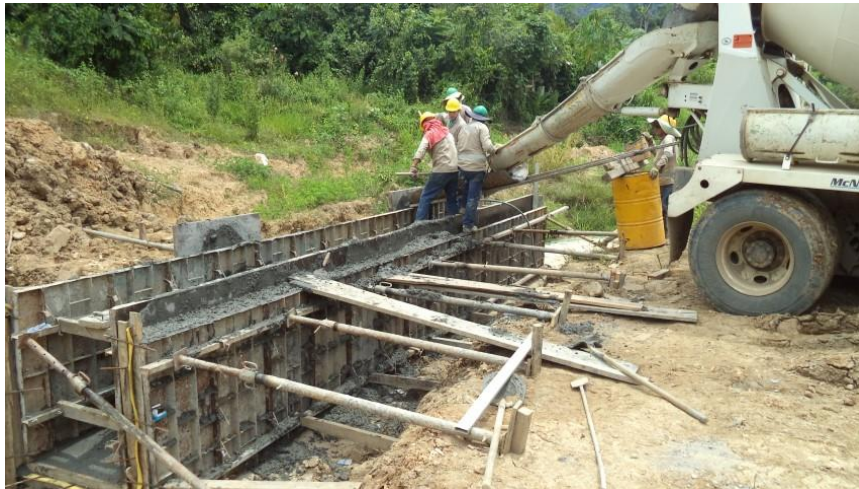
Imagen 32 Fundida de módulos de canal disipador
