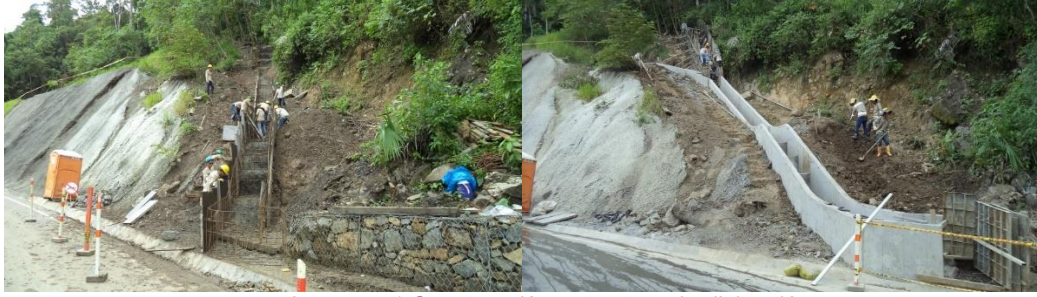
Imagen 41 Construcción estructura de disipación
