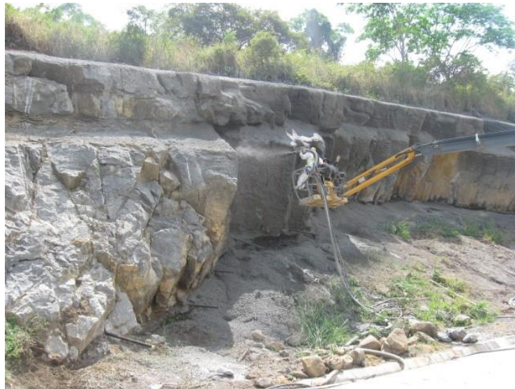
Imagen 35 Concreto lanzado
