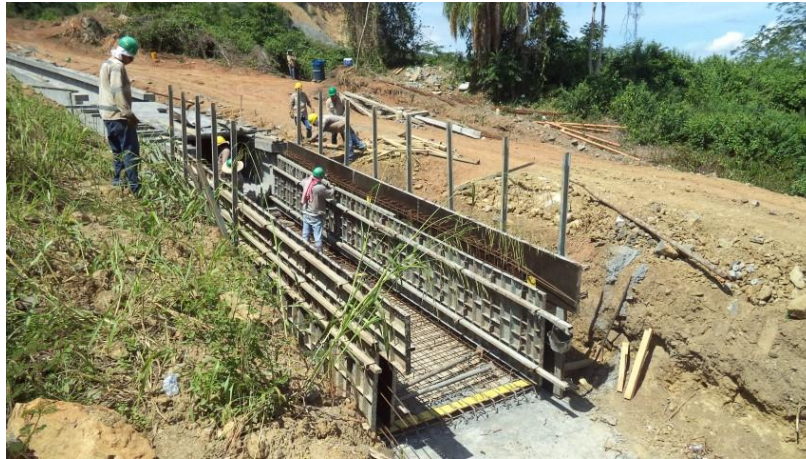
Imagen 22 Encofrado de módulos de canal disipador
