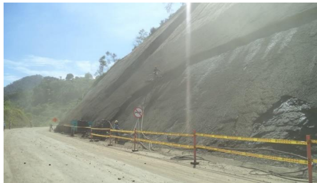
Imagen 51 Perforación para drenes
