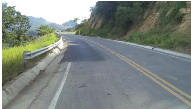
Imagen 55 Recuperación de carpeta asfáltica
