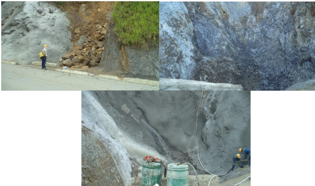
Imagen 42 Concreto lanzado para mejoramiento de encole de alcantarilla
