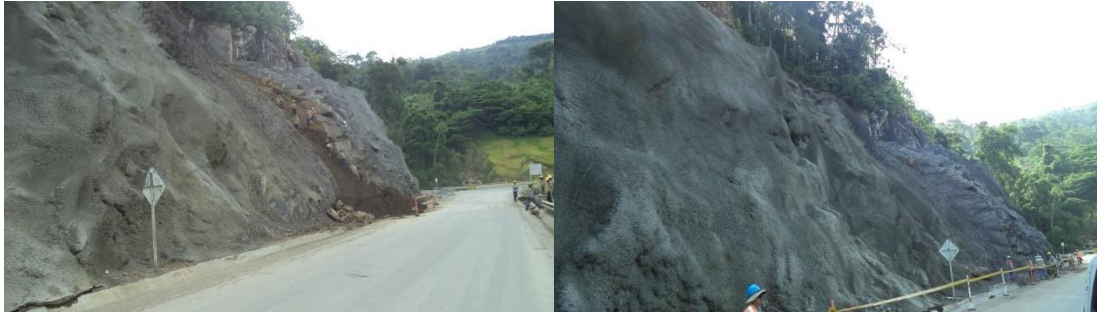
Imagen 53 Concreto lanzado
