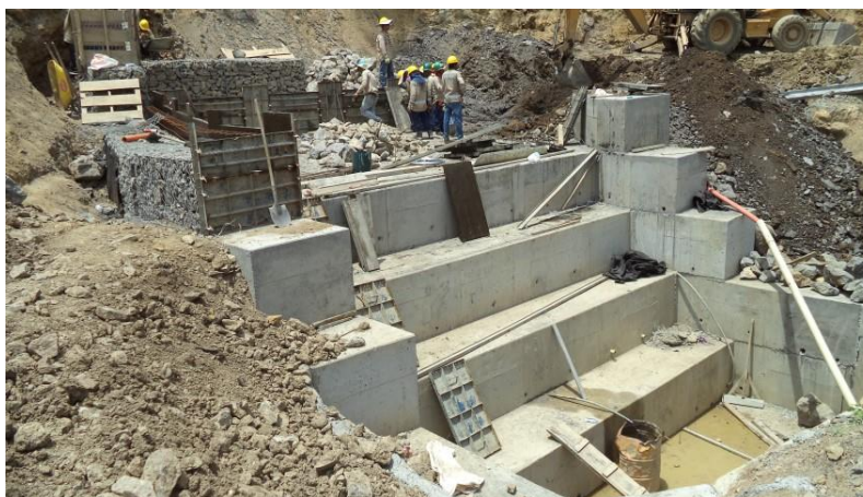
Imagen 45 Armado de gaviones
