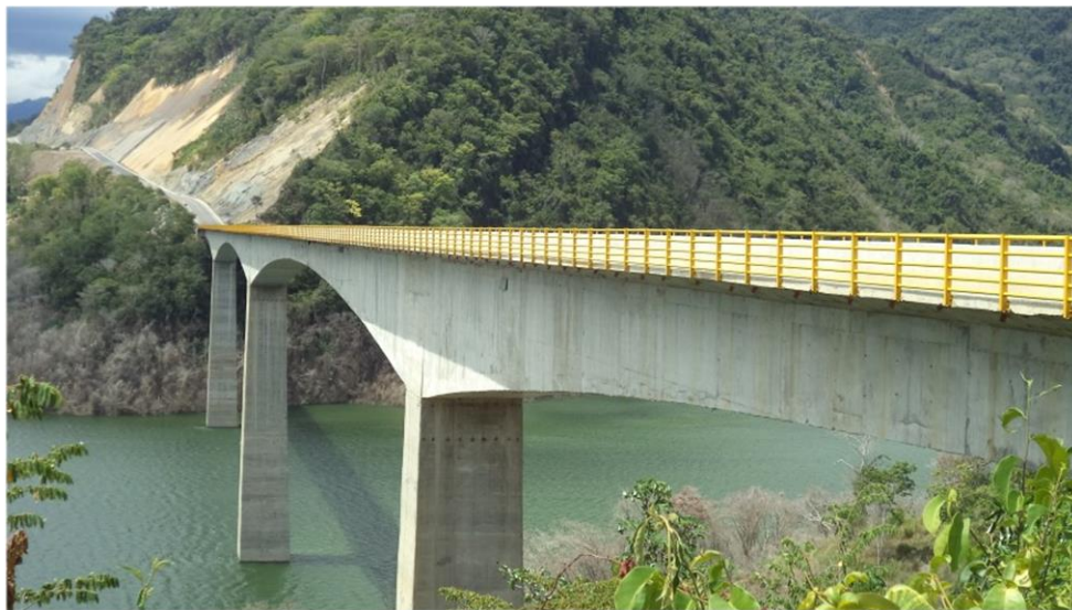
Imagen 12 Puente El Tablazo
