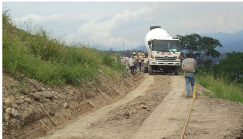
Imagen 23 Fundida secciones de cuneta berma
