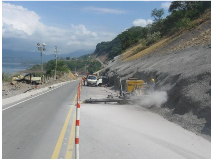
Imagen 34 Perforación de drenes largos
