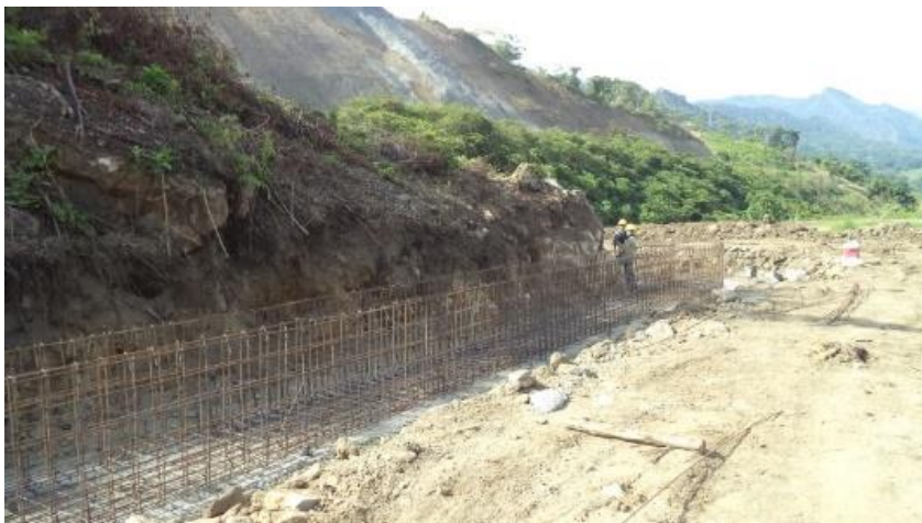
Imagen 18 Amarre de acero para módulos de canal de disipación
