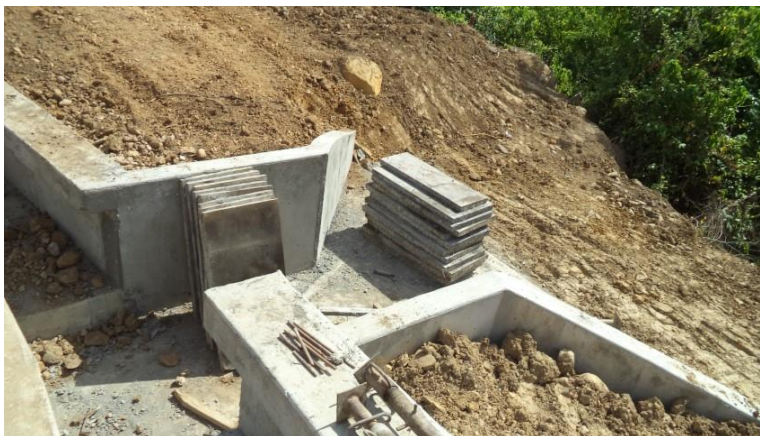
Imagen 20 Desencofrado de estructura de salida
