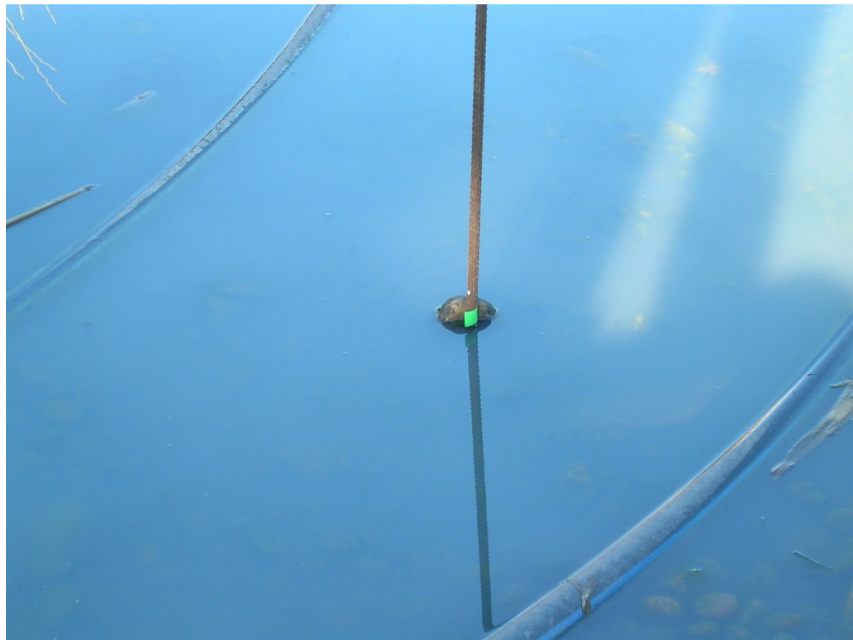
FIGURA 33. Detalle zona de alimentación del H 6 inundada.
