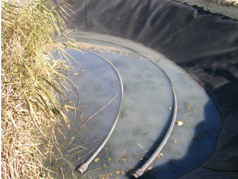
FIGURA 32. Encharcamiento zona de alimentación del HAFSsH H 6 I.
