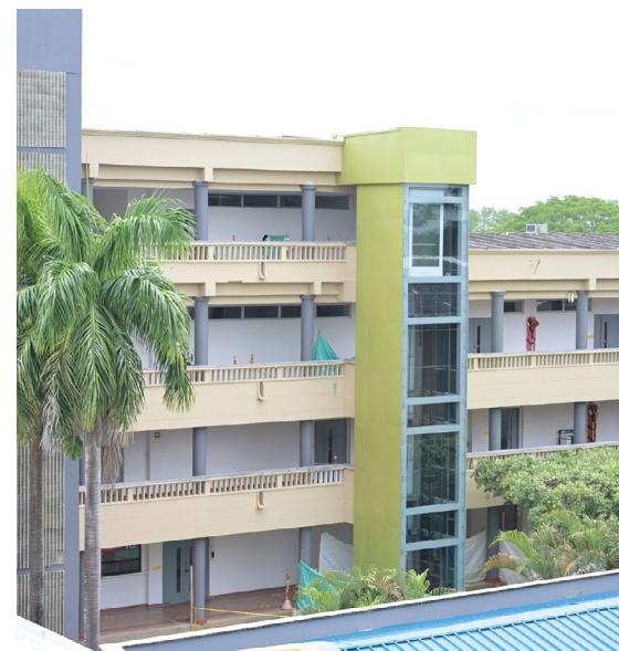
Imagen del ascensor Bloque 1
