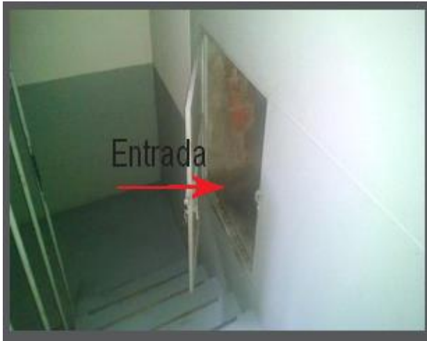
Imagen 5. Entrada al sitio de instalación de captación de agua lluvias
