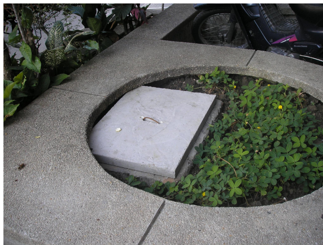
Figura 12. Adecuación Caja de Vertimientos
