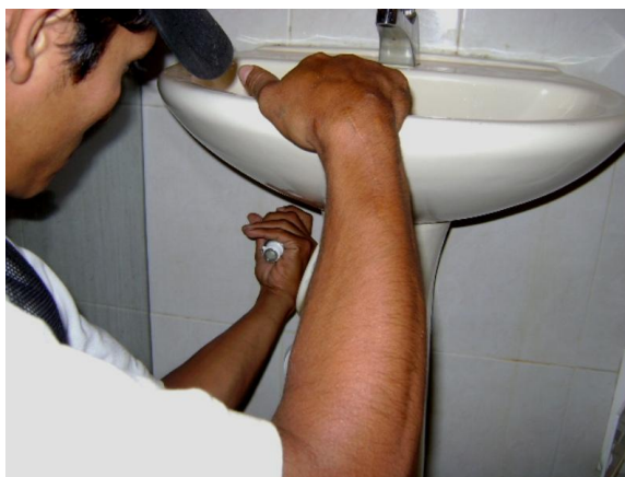
Figura 5. Instalación de Dispositivos
