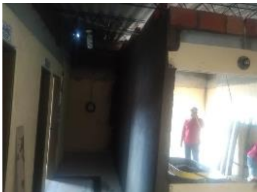
Figura 14 Pintura de los muros Palacio Municipal
