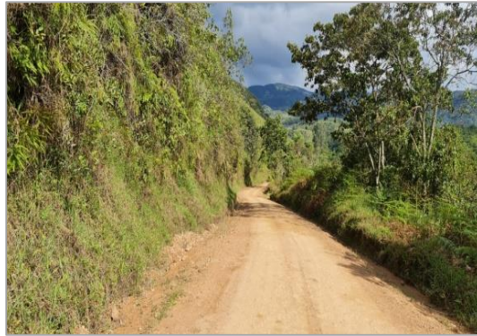
Figura 21 Conformación de calzada existente (Vía principal)
