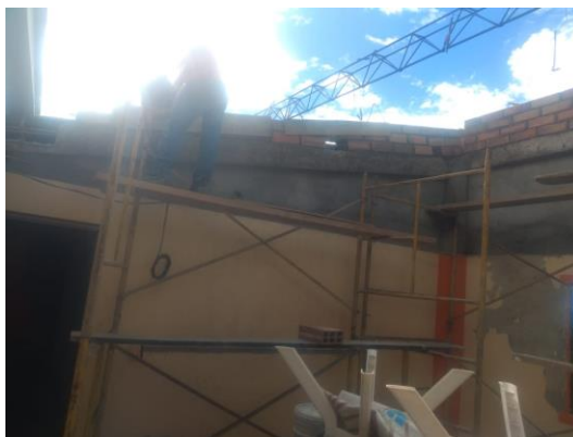
Figura 3 Retiro y desmonte de cubierta Palacio Municipal
