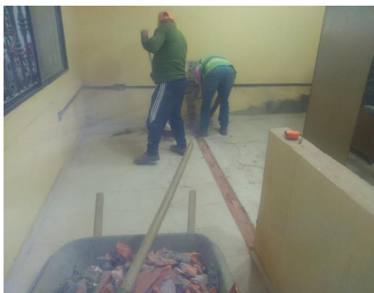
Figura 4 Demolición de muros Palacio Municipal
