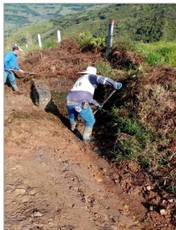
Figura 19 Limpieza de alcantarillas (Vía principal)
