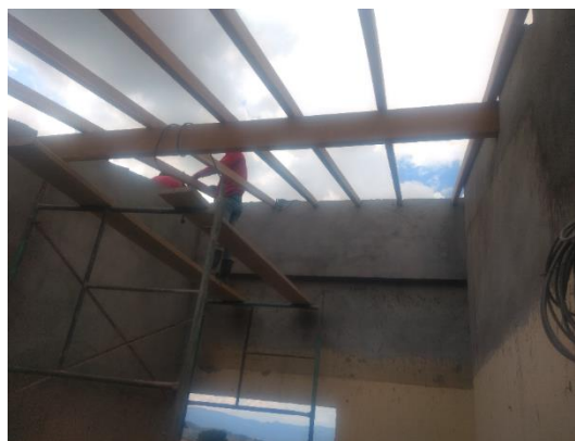
Figura 6 Construcción del techo Palacio Municipal
