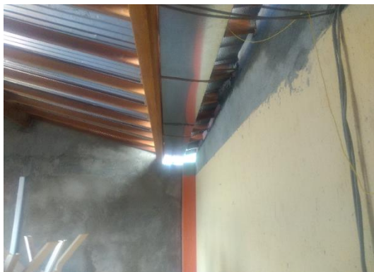
Figura 7 Canal en U obra Palacio Municipal
