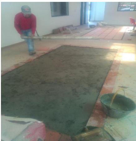
Figura 11 Mortero de nivelación
