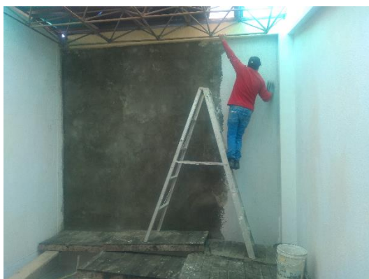
Figura 15 Pintura graniplas en algunos muros
