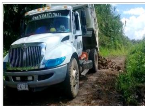
Figura 20 Aplicación material de afirmado (Vía principal)
