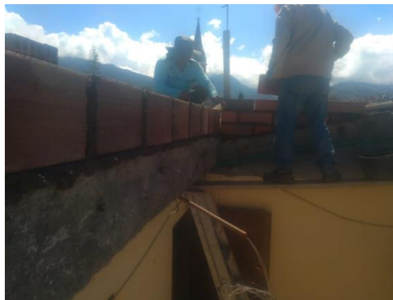
Figura 5 Mampostería H10 Palacio Municipal
