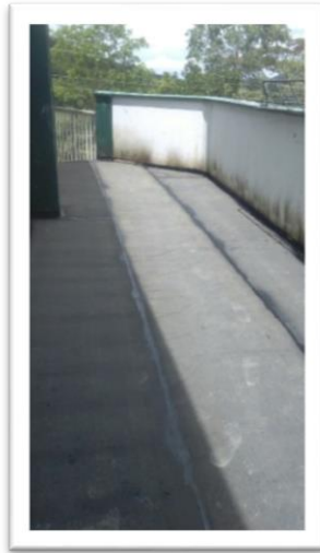
Fig. 22: Placa impermeabilizada.
