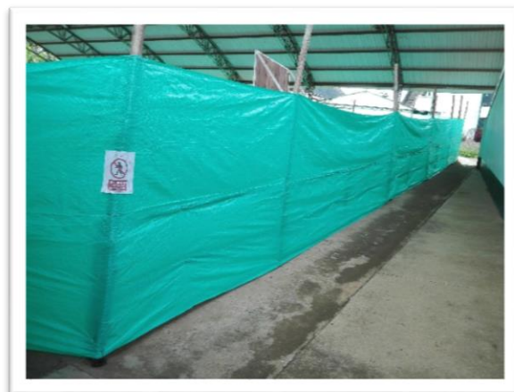
Fig. 3: Cerramiento de la obra.
