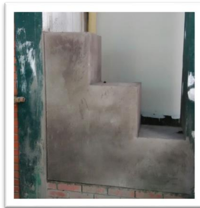
Fig. 23: Pódium en concreto reforzado.
