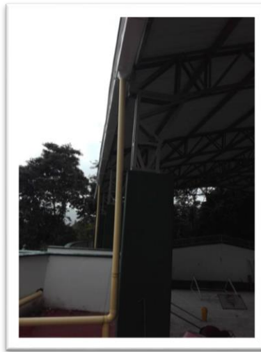
Fig. 18: Bajantes de 4" instalados.
