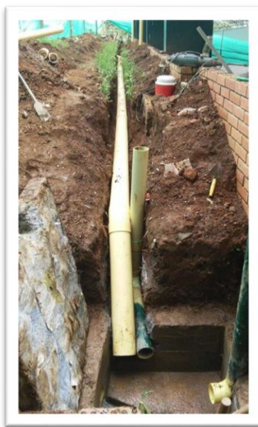
Fig. 19: Tubería 6" instalada.
