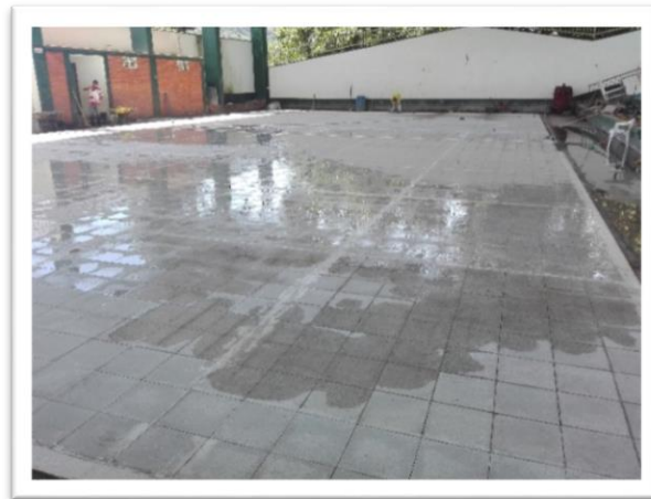
Fig. 14: Piso en granito instalado.
