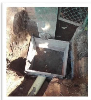
Fig. 12: Construcción de cámara de inspección.
