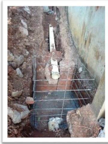
Fig. 13: Construcción de cámara de caída.
