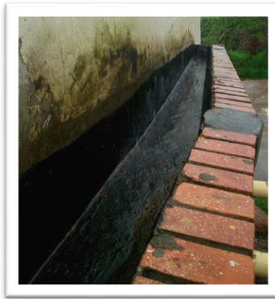
Fig. 17: Impermeabilizado de jardinera.
