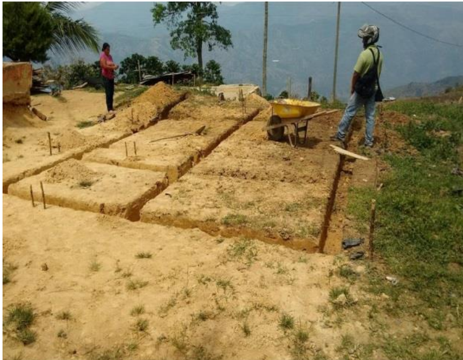
Ilustración 5. Vivienda a nivel de cimentación
