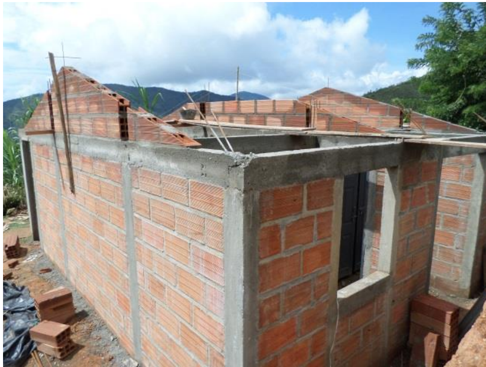
Ilustración 4 Vivienda a nivel de viga amarre
