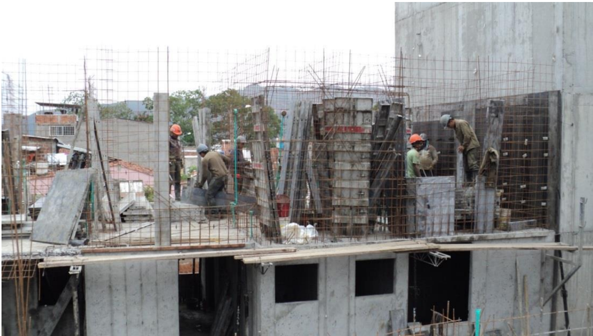
Imagen 39. Registro fotográfico del personal en obra.
