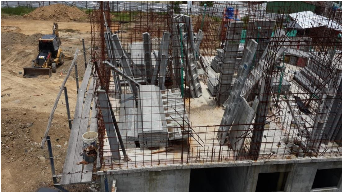
Imagen 41. Registro fotográfico del sistema Forsa en obra.
