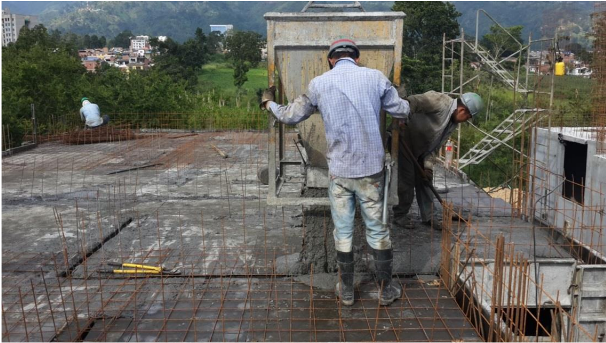
Imagen 40. Registro fotográfico del método de vaciado de concreto con tolva.
