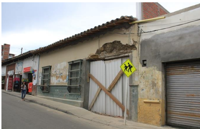
Fotografía N° 22 Calle del frente a la sede de las oficinas de Comfama. Calle 51 La Convención con carrera 51 Córdoba.
