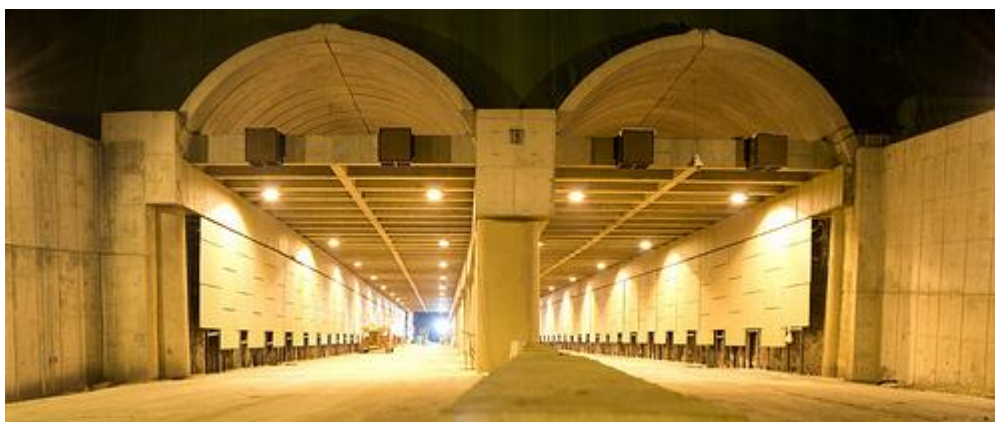
Fotografía N° 6 Túnel de Occidente Fernando Gómez Martínez.
