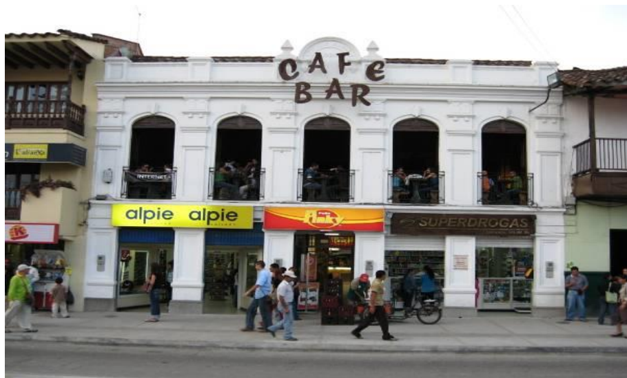
Fotografía N°25 Edificio Marín, contiguo a la casa de la Maestranza.
