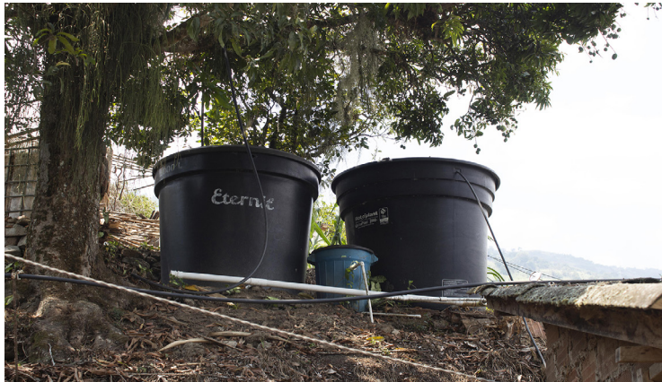
Figura 6-25. Sistema de gestión de agua lluvia.
