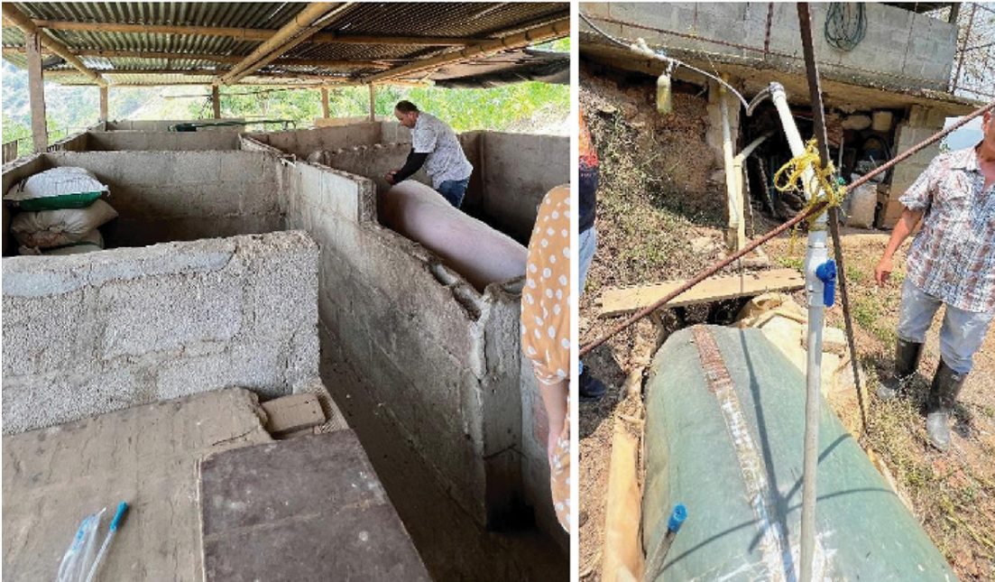
Figura 6-26. Marranera, depósito y biodigestor.
