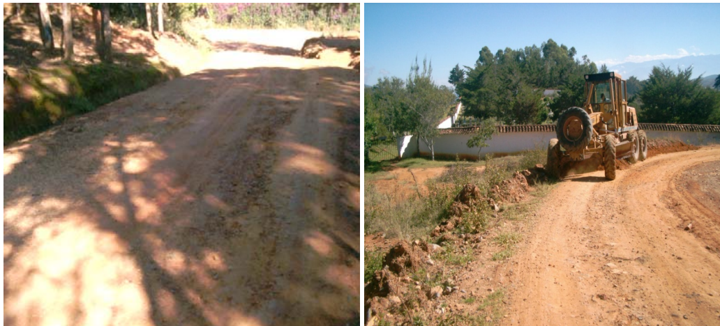
Foto 52-Foto 53 Vía al cementerio antes y durante la realización del trabajo
