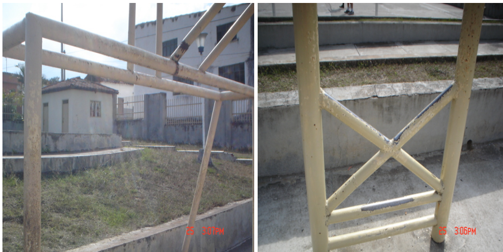
Foto 21-Foto 22 Deterioro en canchas de microfútbol y baloncesto, falta pintura
