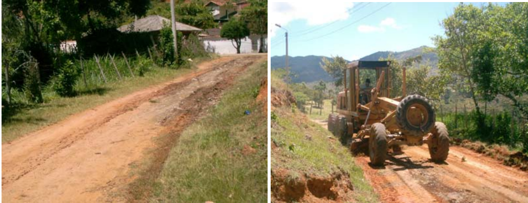
Foto 54 Calle 27 entre carreras 10 y 11 antes y durante la realización del trabajo
