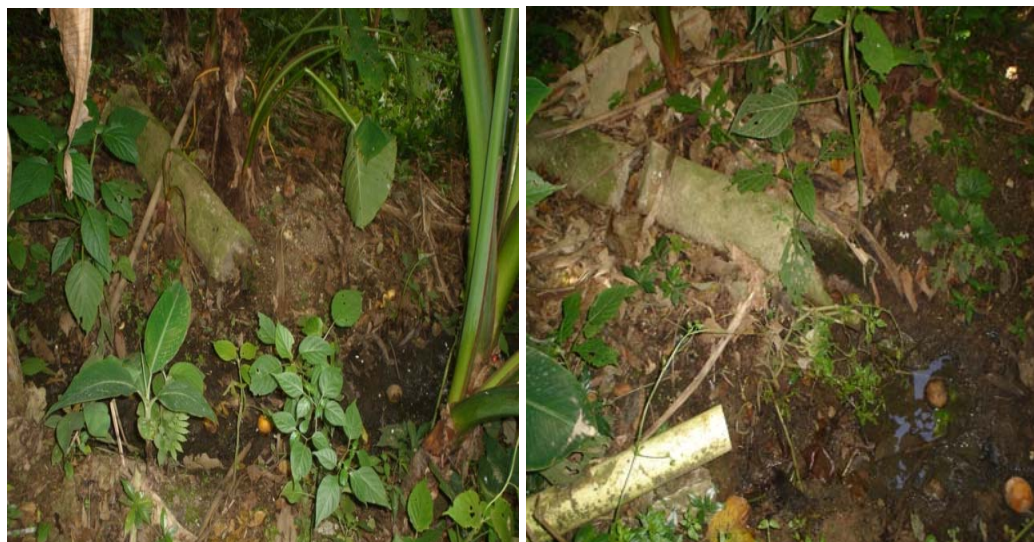
Foto 47-Foto 48 Visita para verificar la falta de pozo séptico y la presencia de malos olores
