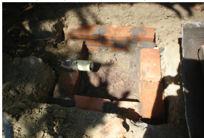
Foto 45 Tramo elevado de tubería, sistema no muy común para un alcantarillado
