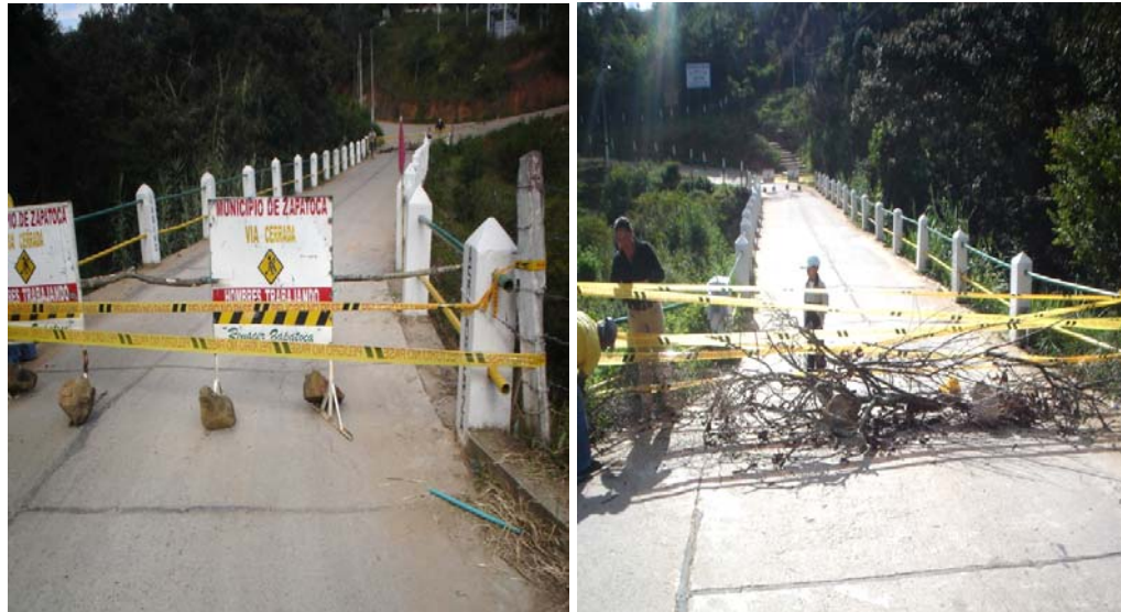
Foto 34-Foto 35 Cerramiento del puente sobre la quebrada uchuval a ambos costados.
