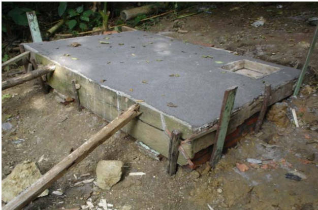
Foto 51 Pozo séptico terminado con su respectiva tapa.
