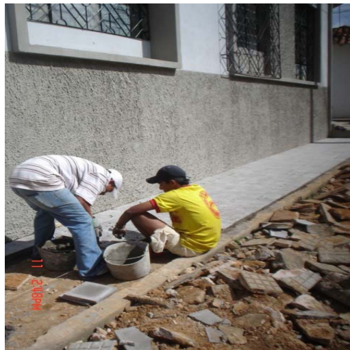
Foto 97-Foto 98 Instalación del nuevo adoquín
