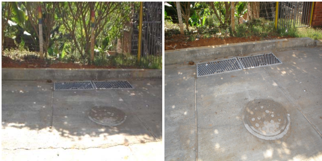
Foto 90-Foto 91 Pavimento rehabilitado y sumidero debidamente construido
