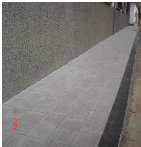
Andén debidamente terminado
