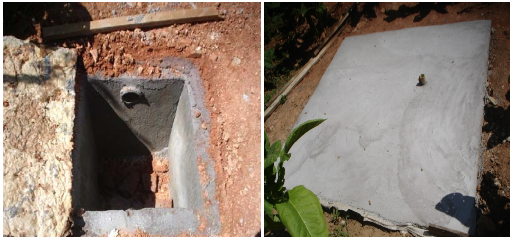
Foto 94 Pozo Séptico con su respectiva trampa de grasas
