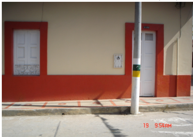
Foto 138 Casa donde se verificó la nomenclatura ventana que se piensa cambiar por puerta
