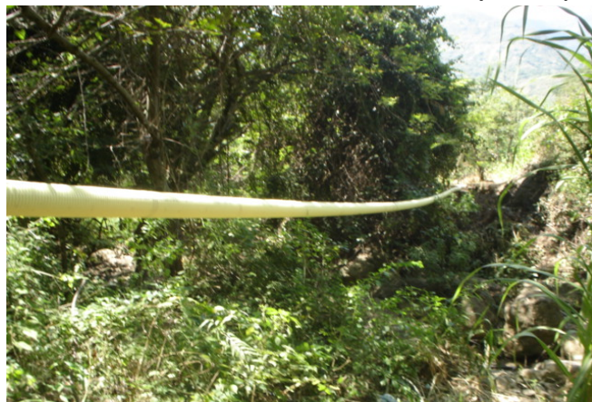
Foto 45 Tramo elevado de tubería, sistema no muy común para un alcantarillado
