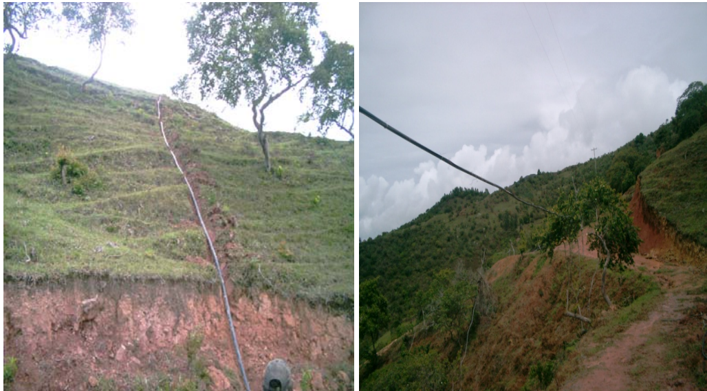
Foto 63-Foto 64 Instalación casa de Socorro Acacio
