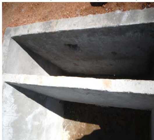
Foto 94 Pozo Séptico con su respectiva trampa de grasas
