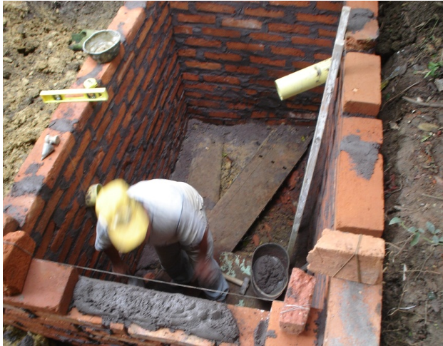
Foto 50 Construcción pozo séptico ladrillo temosa
