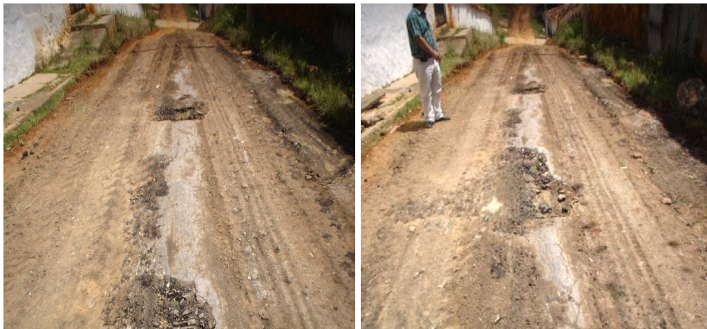
Foto 32-Foto 33 Adecuación de vía alterna
