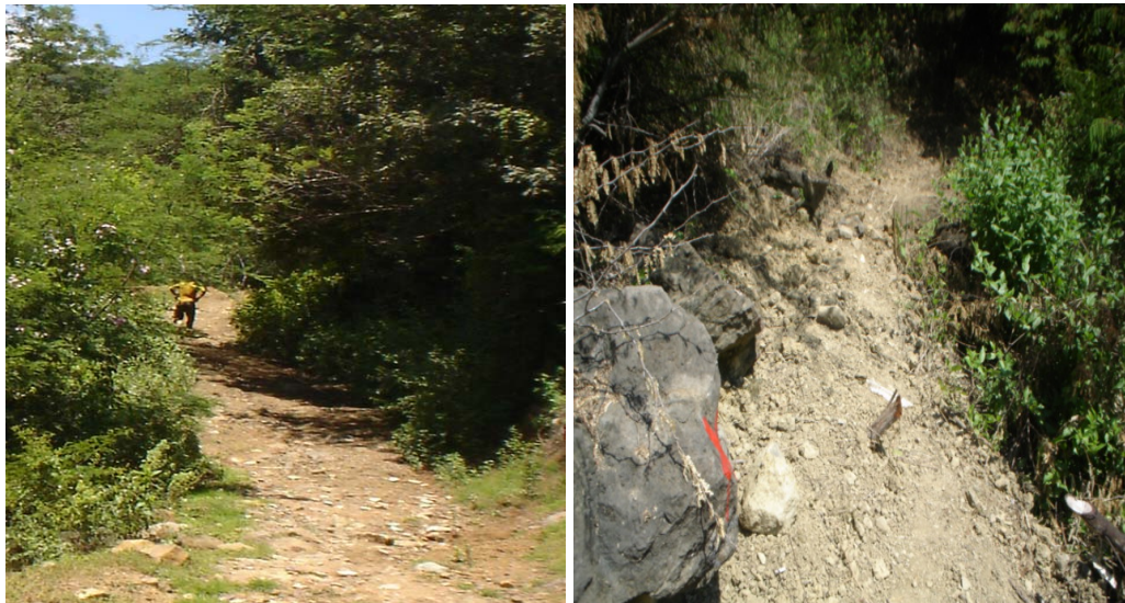
Foto 42-Foto 43 Visita para determinar el paso de la tubería y la longitud de tubería necesaria.
