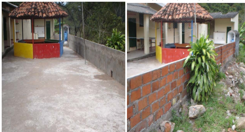
Foto 29-Foto 30 Muro preventivo debidamente construido y piso del patio de juegos reparado
