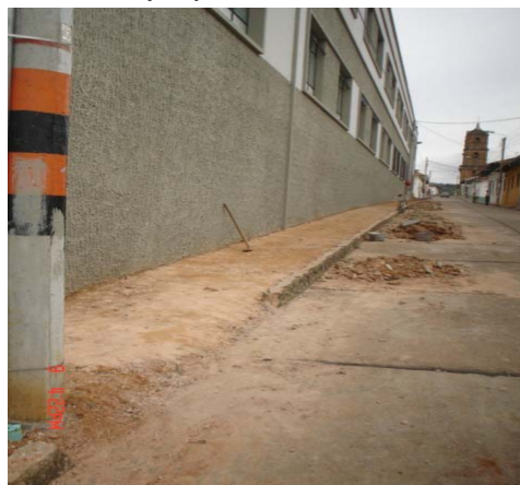
Demolición y Replanteo del andén
