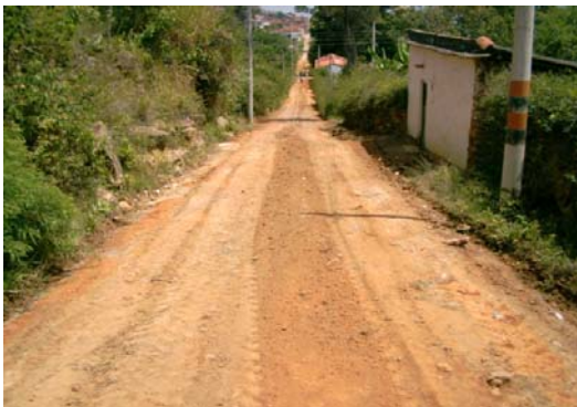
Foto 57 Terminado el trabajo de aplicación de recebo
