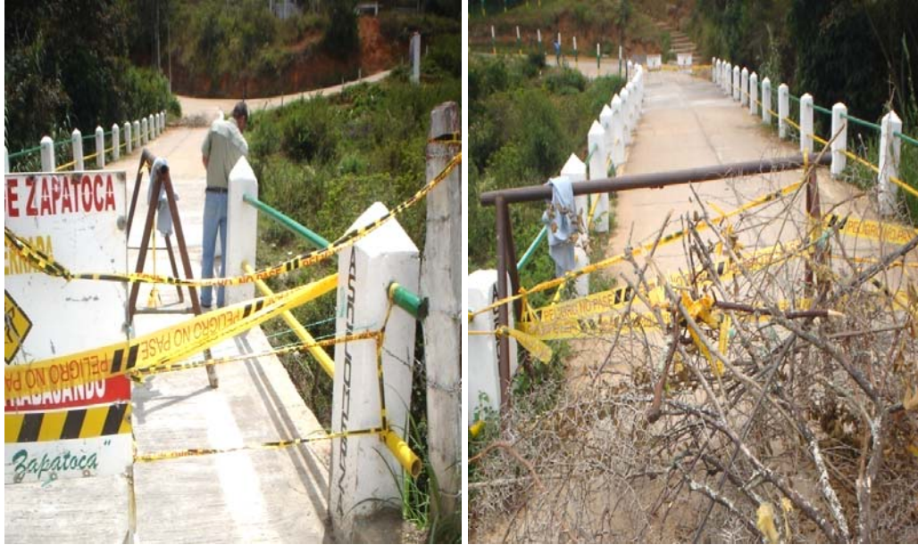
Foto 40-Foto 41 Cerramiento provisional para proceso de curado del concreto
