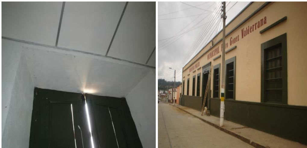
Foto 5-Foto 6 Daños solucionados, pared pintada, cielorraso cambiado y limpio, fachada terminada.
