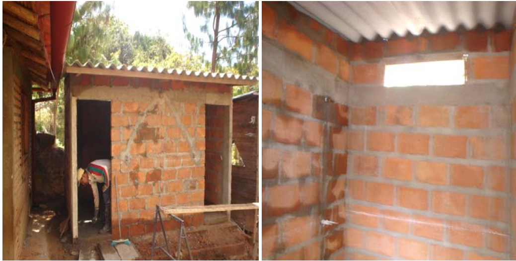
Foto 80-Foto 81 Construcción de dos baterías sanitarias vista exterior e interior
