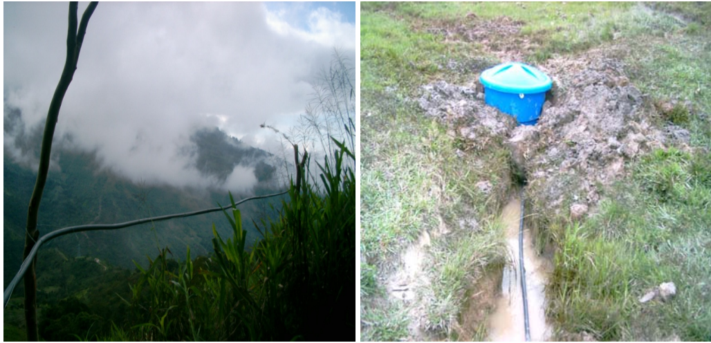
Foto 61-Foto 62 Instalación en la casa de Vicente Granados
