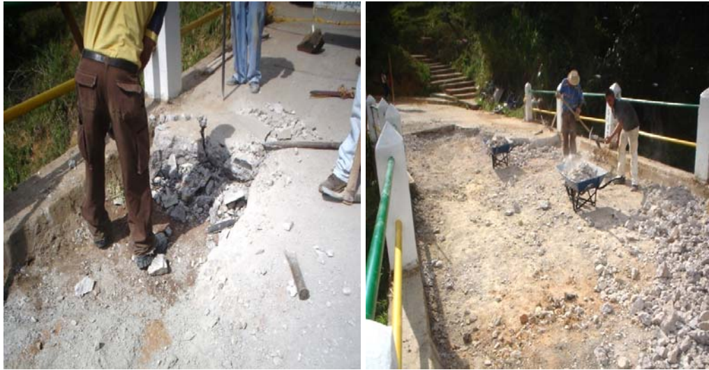
Fotos Foto 36-Foto 37 Demolición de losas afectadas
