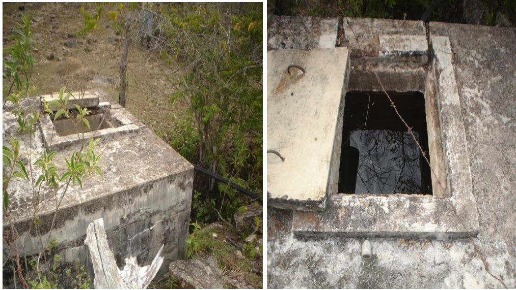
Foto 73-Foto 74 Segundo tanque de almacenamiento, también permanece lleno.
