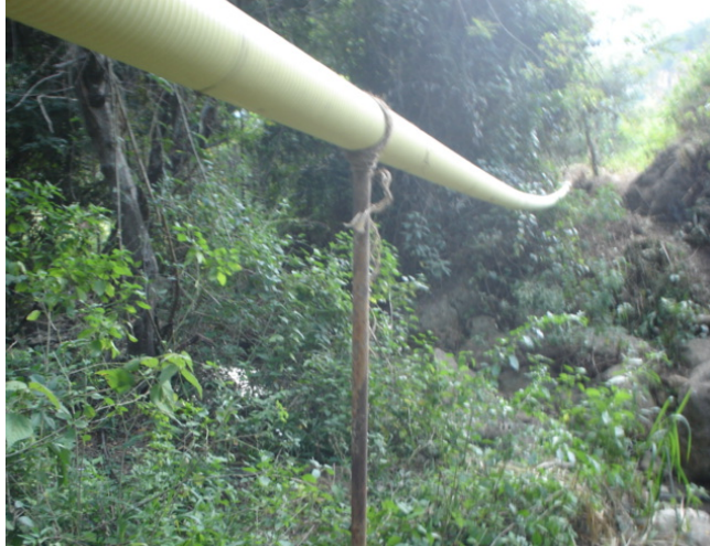
Foto 46 Tramo elevado con su respectivo soporte para evitar el movimiento o el colapso.
