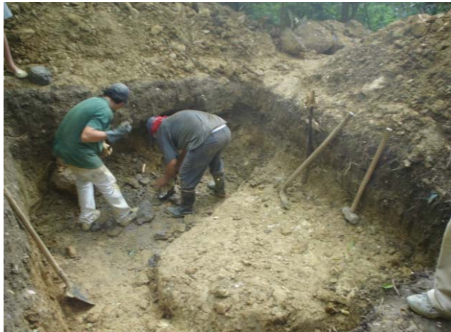
Foto 49 Excavación de material común y excavación en roca del sitio dispuesto para el pozo séptico
