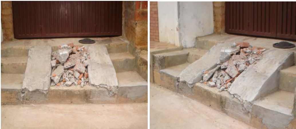
Foto 118- Foto 119 Rampa demolida debidamente
