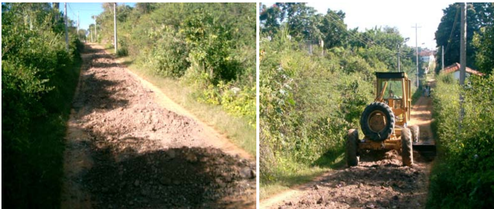
Foto 57 Terminado el trabajo de aplicación de recebo
