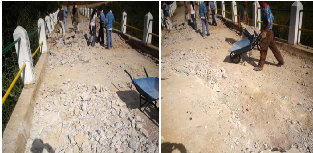
Foto 38-Foto 39 Visita de obra por la Jefe y el Auxiliar de Planeación junto con el ingeniero contratista
