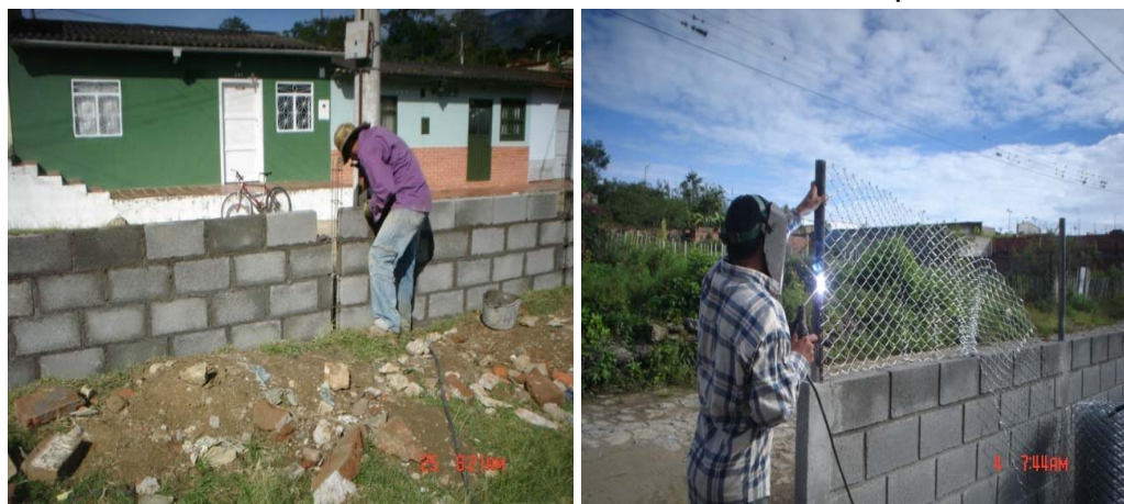
Foto 104 -Foto 105 Construcción muro de cerramiento Instalación de malla para cerramiento
