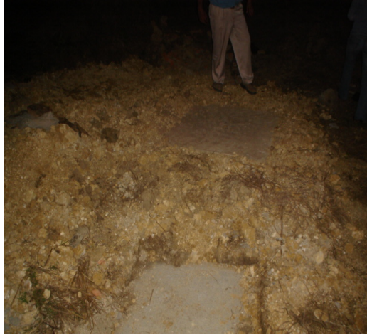
Foto 87 Adecuación de pozo séptico
