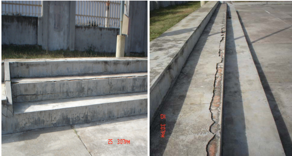
Foto 21-Foto 22 Deterioro en canchas de microfútbol y baloncesto, falta pintura
