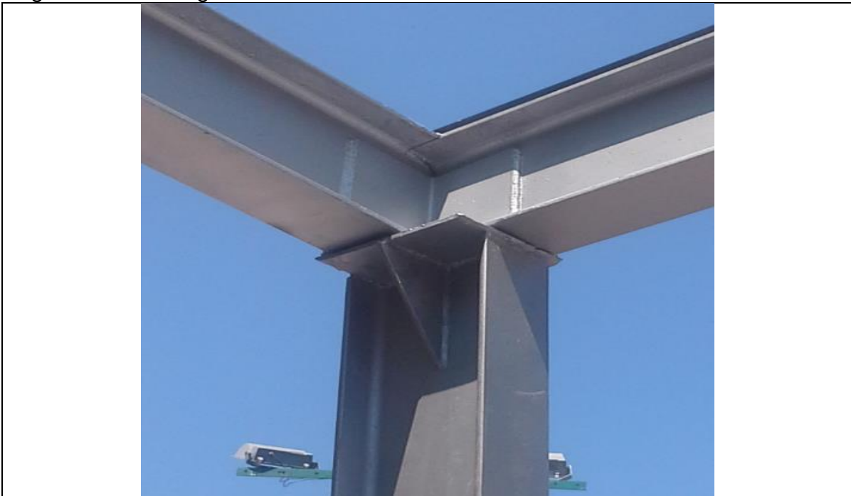
Unión de vigas con columnas con platina.
