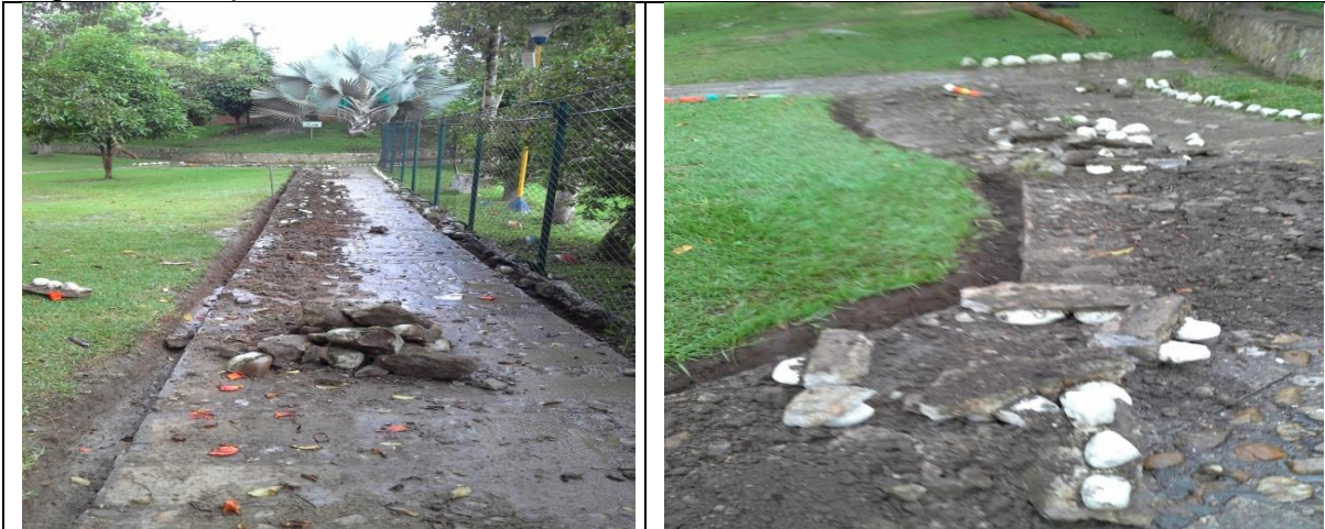
Demolición del empedrado lateral.
