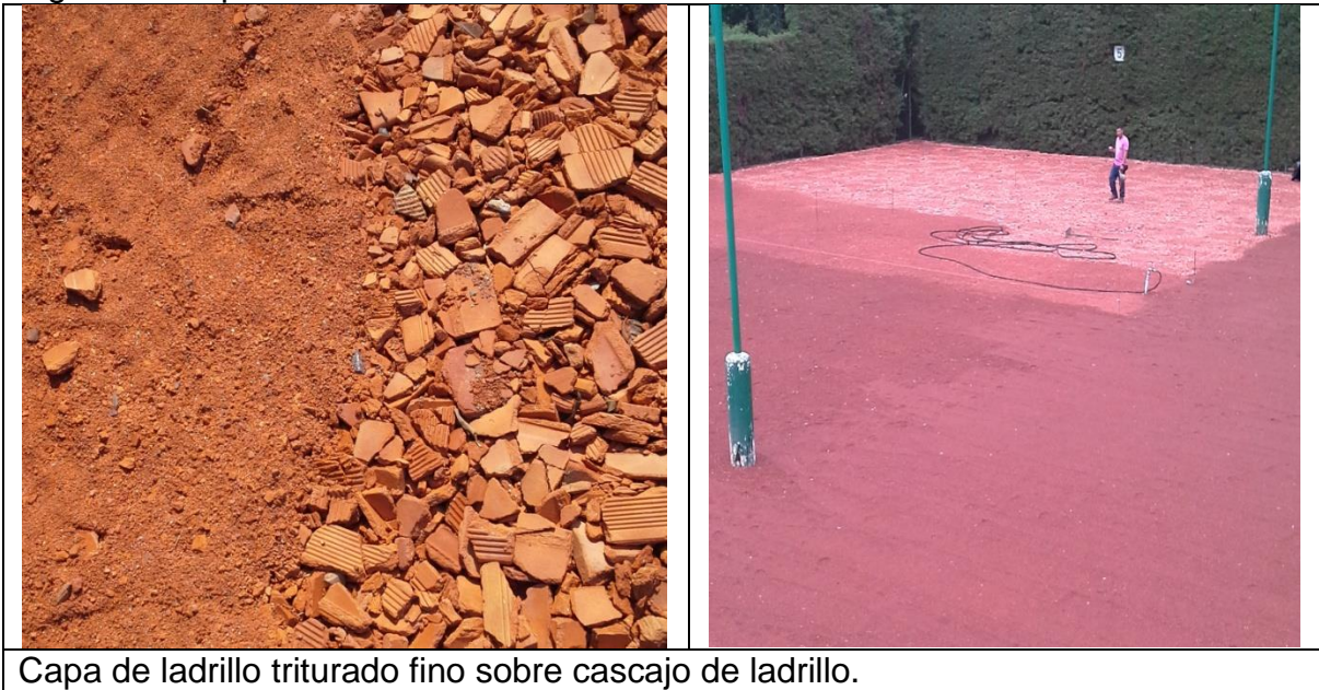
Figura 32 Capa de ladrillo triturado
