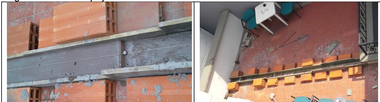
Fundida de Poyo (cuarto bodega)
