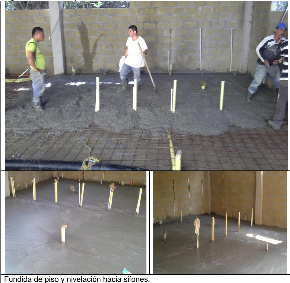
Figura 7 Fundida de piso
