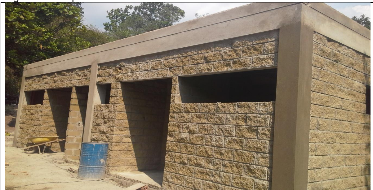
Mampostería ladrillo a la vista.
