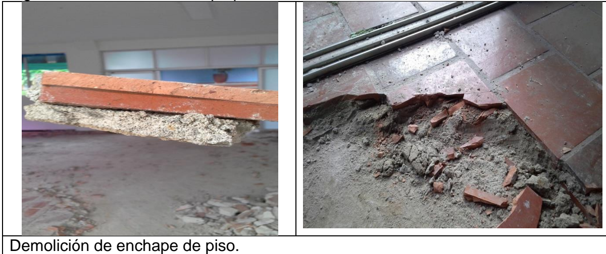
Figura 66 Demolición enchape piso
