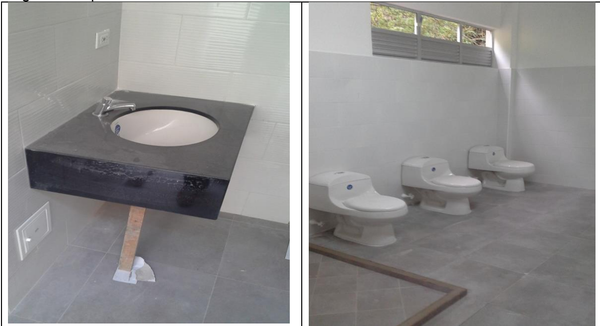
Instalación equipos sanitarios y lavamanos e instalación de ventanería.
