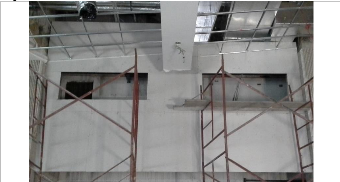
Láminas de dry Wall cuarto técnico y perfilería para dry Wall del techo.
