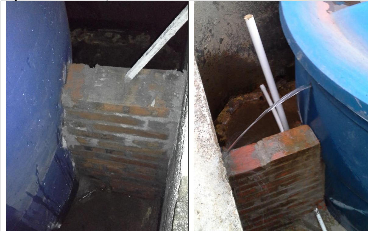
Reforzamiento tanque de agua con ladrillo.
