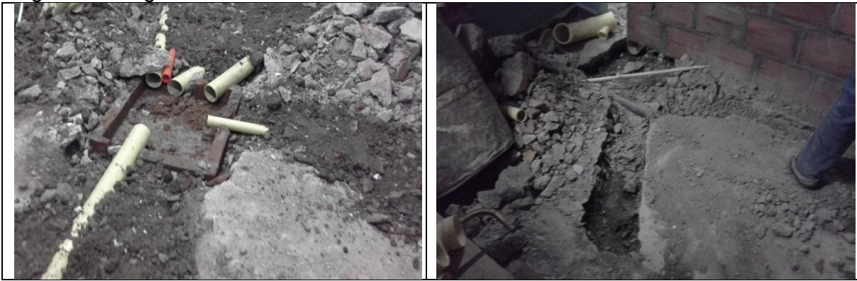
Regatas para tubería sanitarias.
