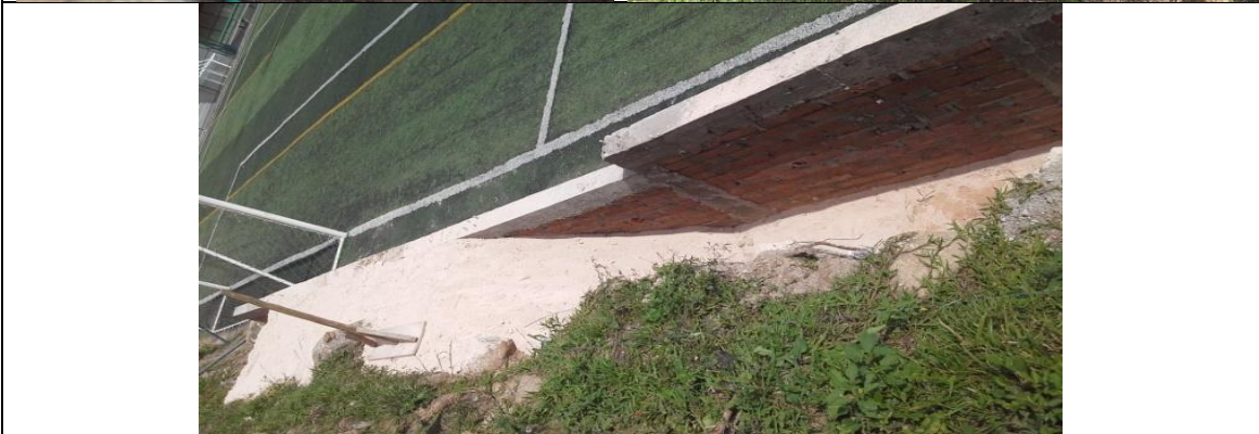
Relleno en la parte posterior del muro con material de relleno y material de préstamos.
