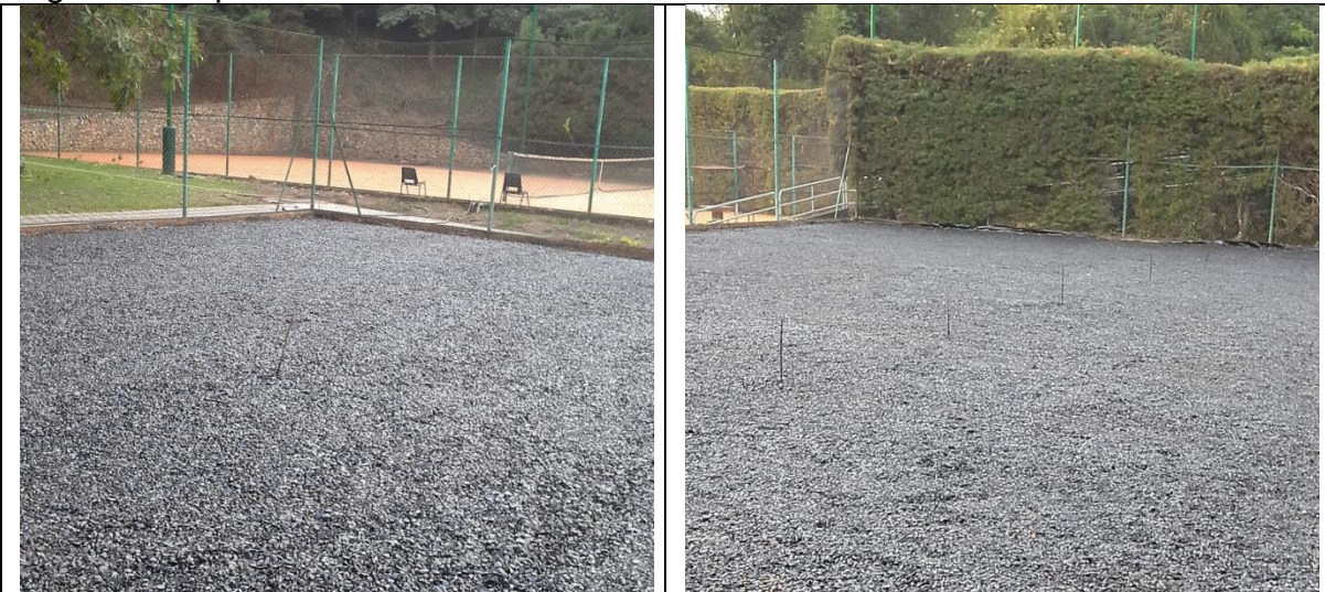
Figura 30 Imprimante asfáltico
