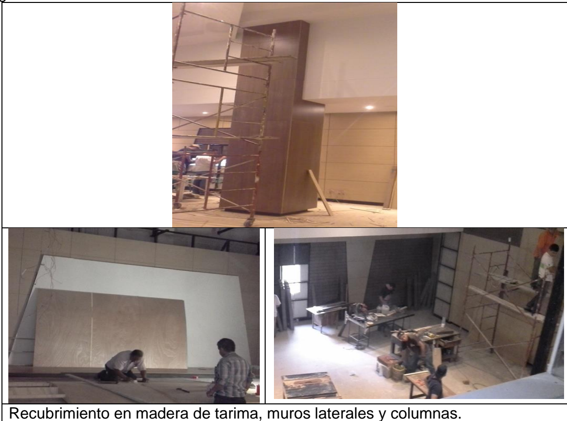
Figura 46 Recubrimiento madera
