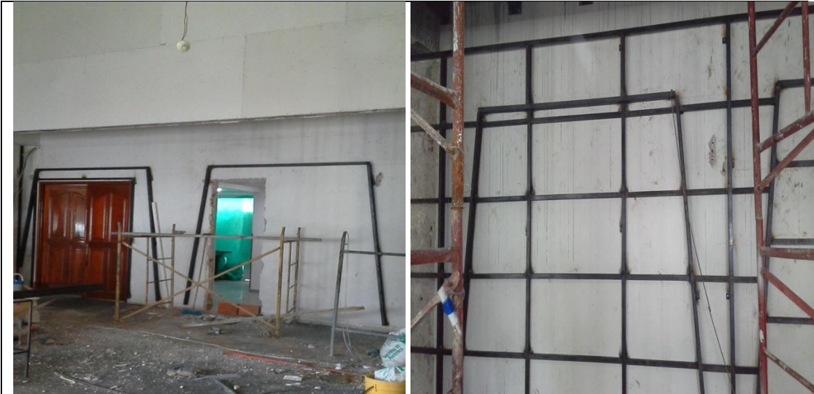
Láminas de dry wall y perfilera metálica para recubrimiento acústico.
