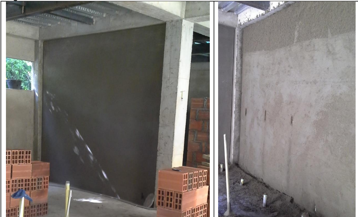
Friso de muros internos a dos caras.
