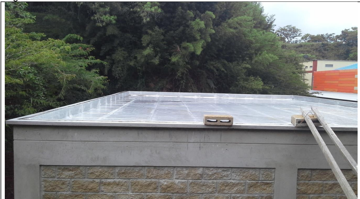
Aplicación de manto asfáltico y alumol para impermeabilización de la placa.
