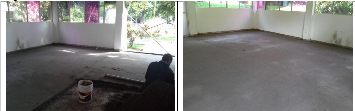
Figura 67 Mortero de nivelacion
