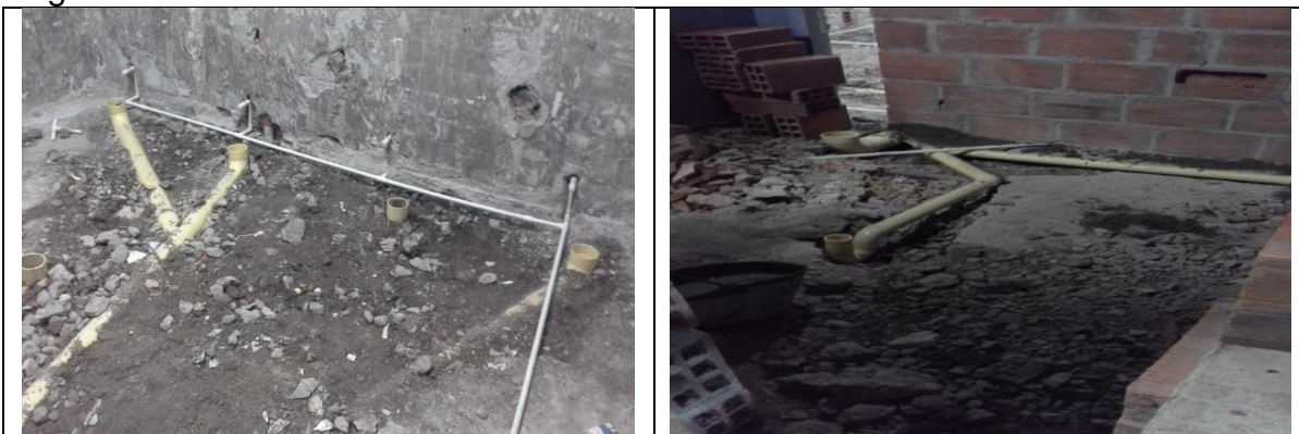
Tubería Hidráulica y sanitaria lista para instalar aparatos.
