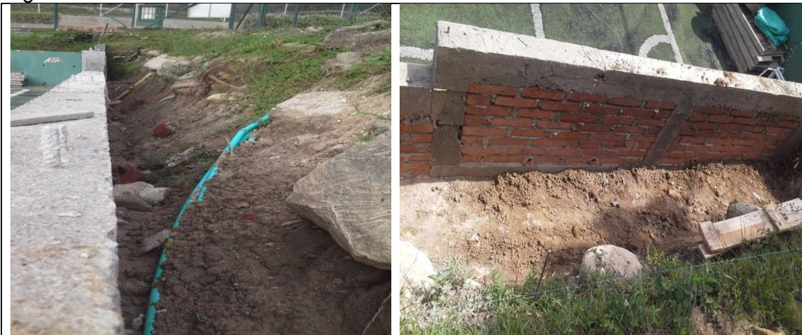
Figura 58 Relleno talud
