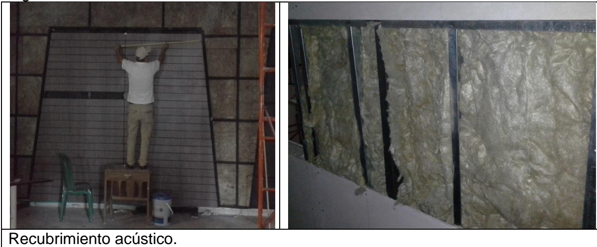
Figura 45 Recubrimiento acústico
