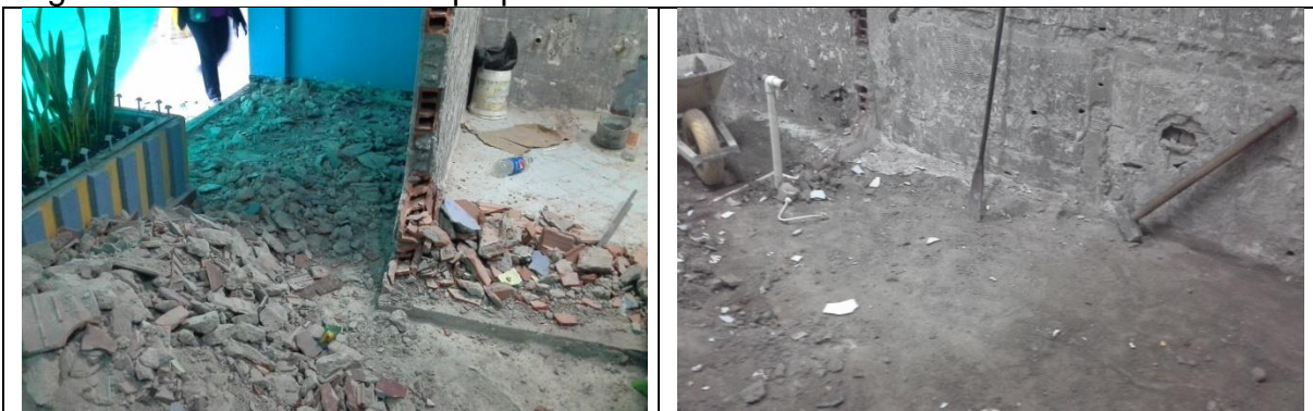
Demolición de enchape de piso y mortero.
