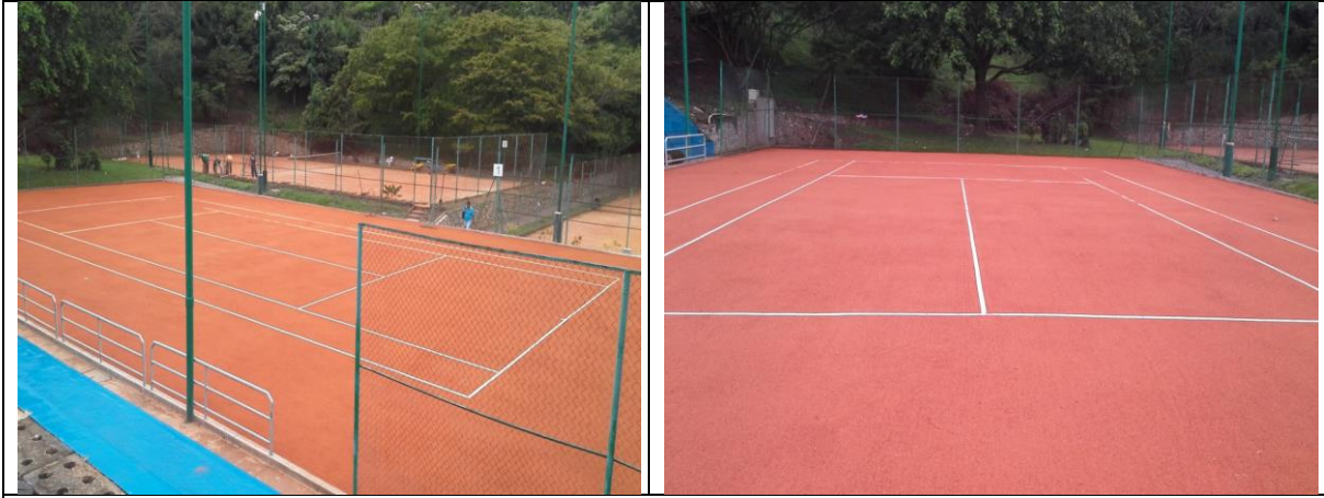
Cancha #1 terminada con polvo de ladrillo y líneas de juego instaladas.
