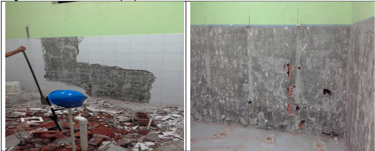
Figura 61 Retiro de enchape pared
