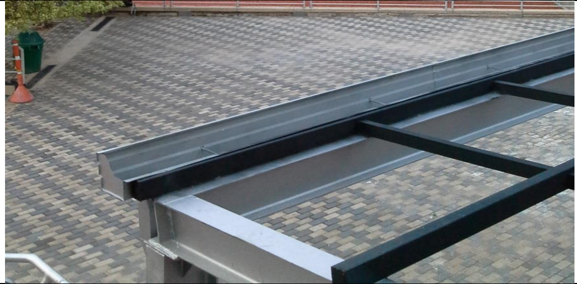
Instalación de canales.
