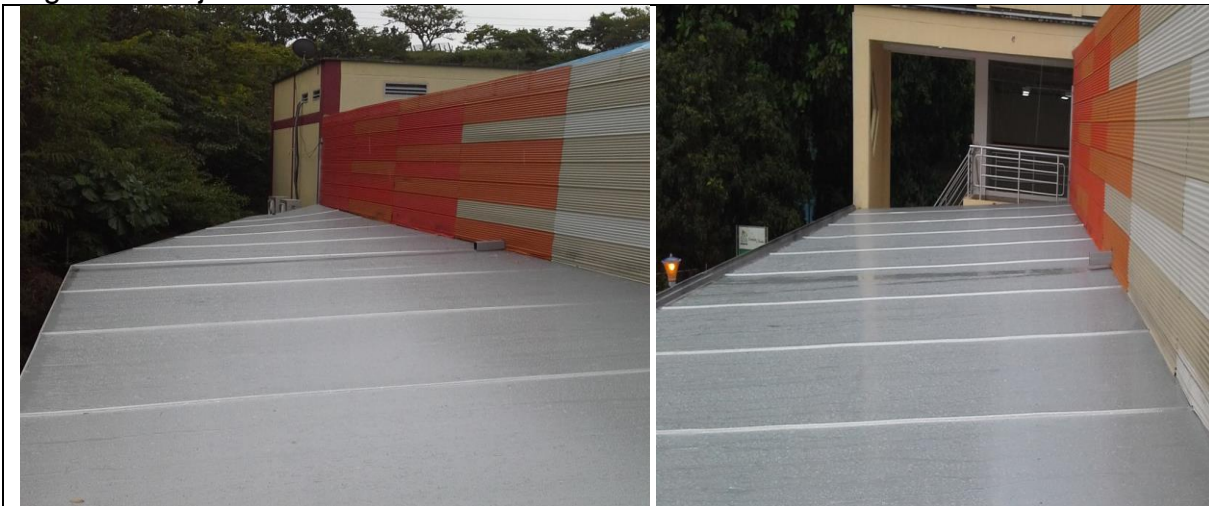
Teja alveolar amarrada a las riostras, y canales en los puntos determinados.
