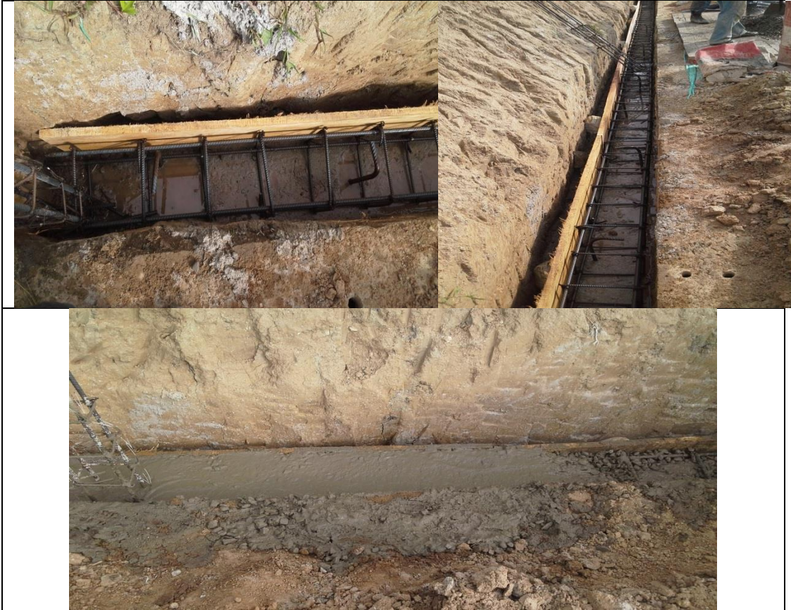
Fundida de viga de amarre con estribos cada 30 cm.
