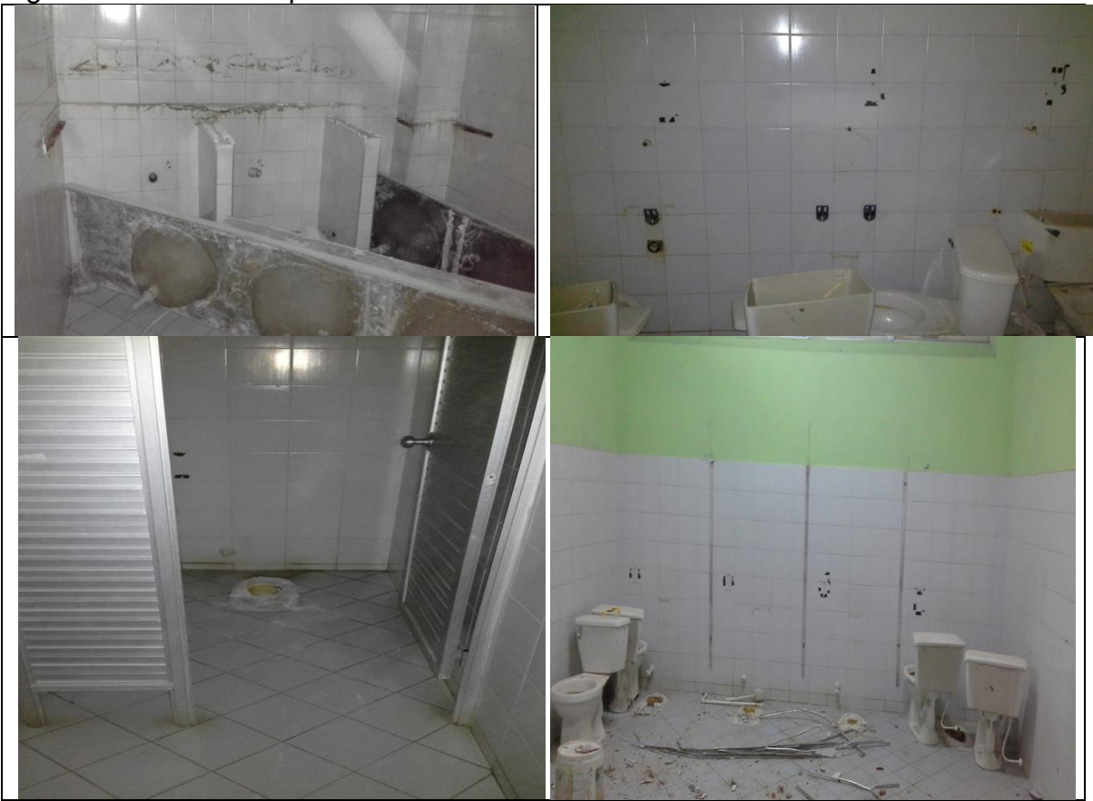
Desmonte de aparatos sanitarios, mesones y divisiones.
