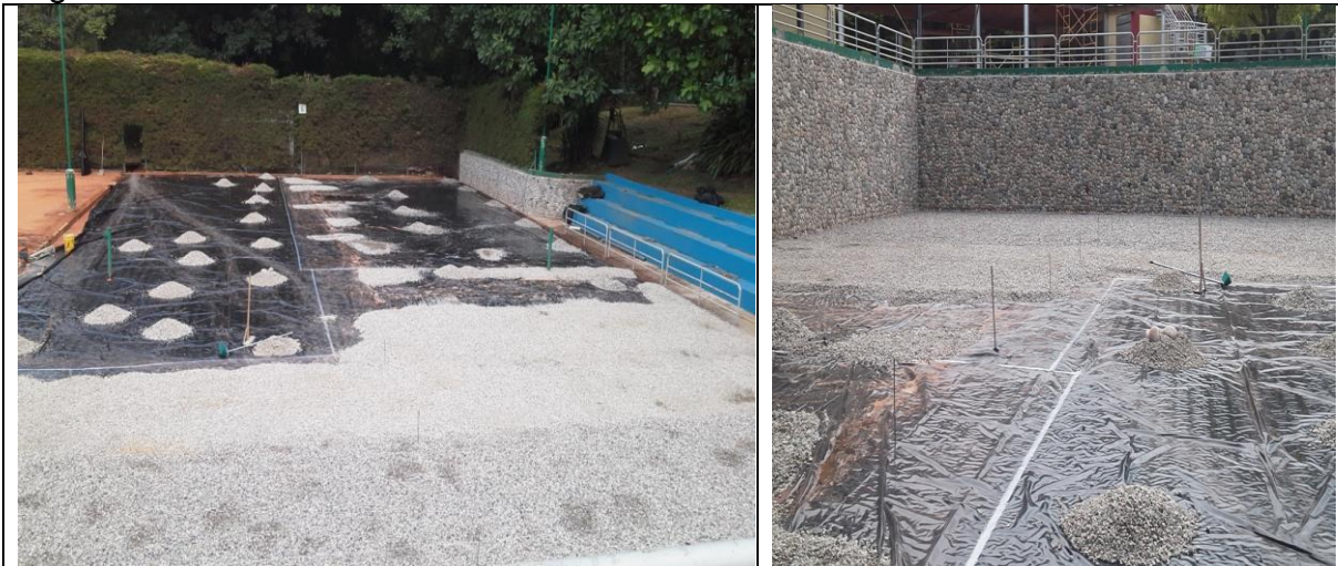
Aplicación capa triturado \frac{3}{4} " sobre plástico.
