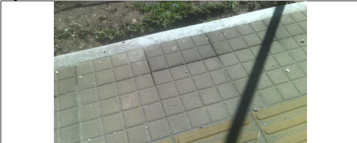
Fundida del sardinel de confinamiento.
