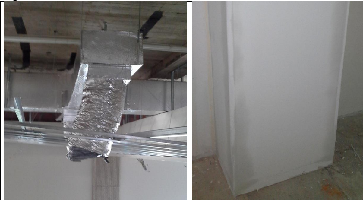
Instalación de nuevos ductos del aire.
