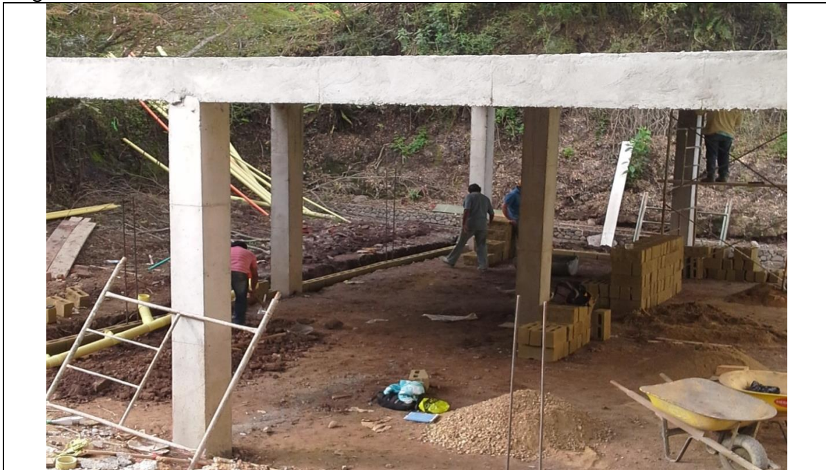
Estructura de camerino.
