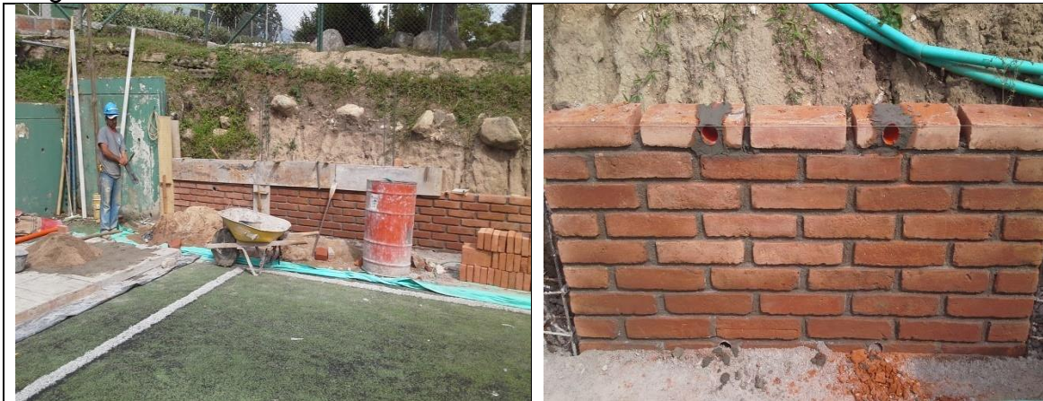
Figura 57 Muro ladrillo temosa
