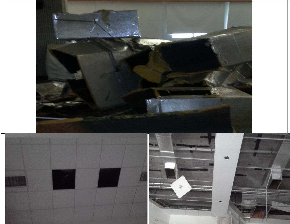
Figura 35 Desmote ductos y cielo raso
