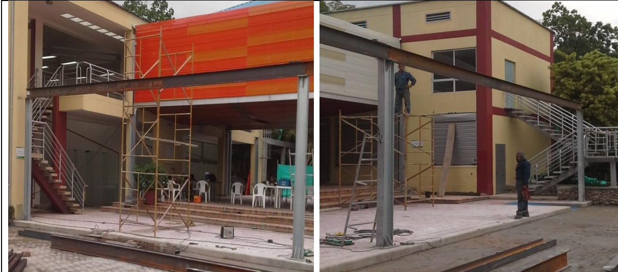
Instalación de vigas estructura metálica IPE 240.
