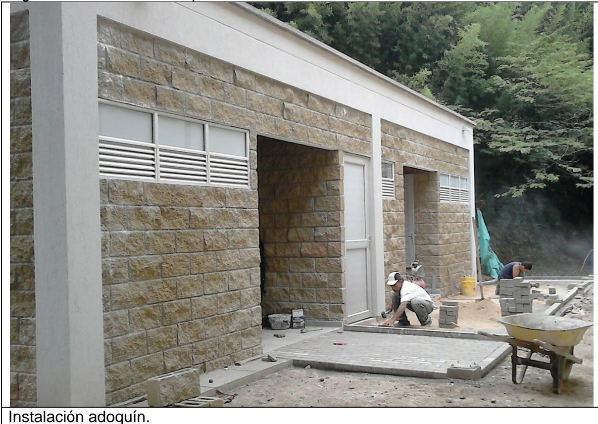
Figura 16 Instalación adoquín
