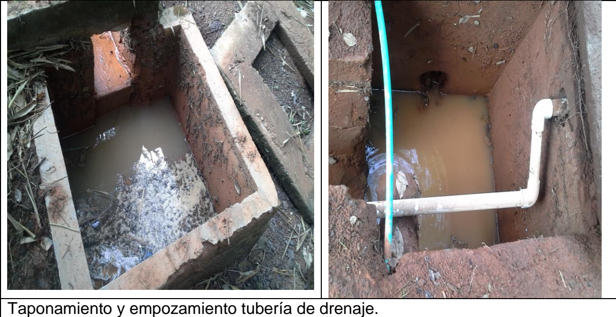
Figura 27 Taponamiento cajas
