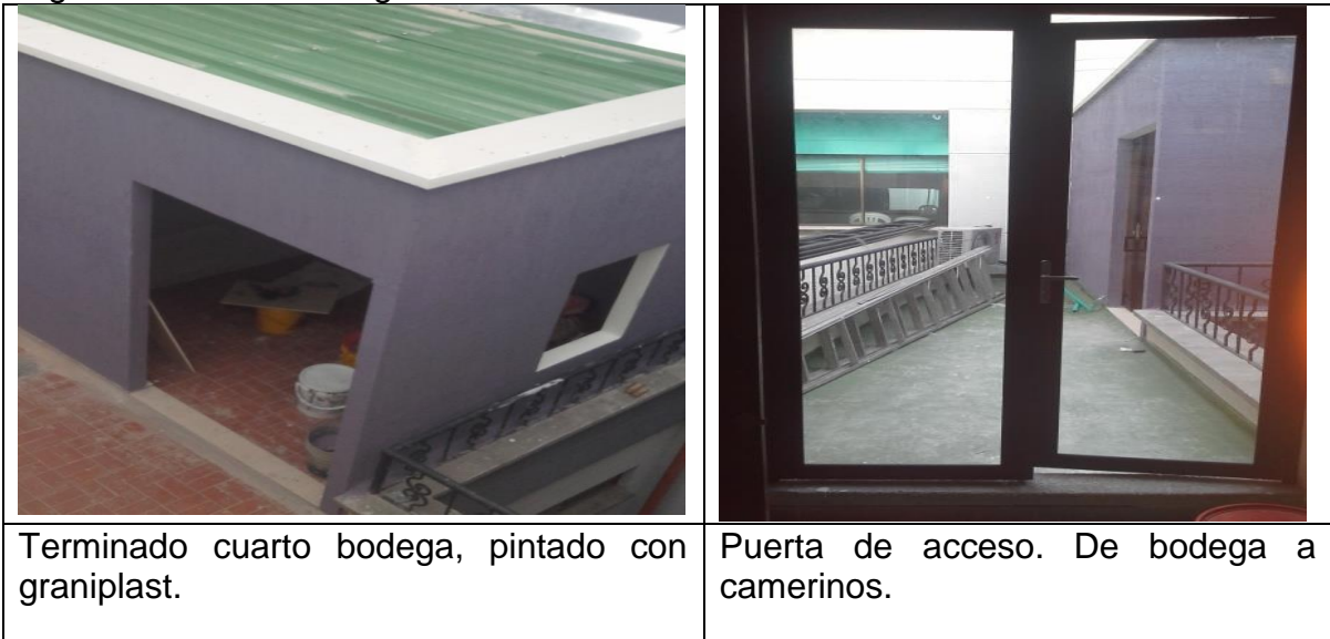
Figura 47 Cuarto bodega terminado
