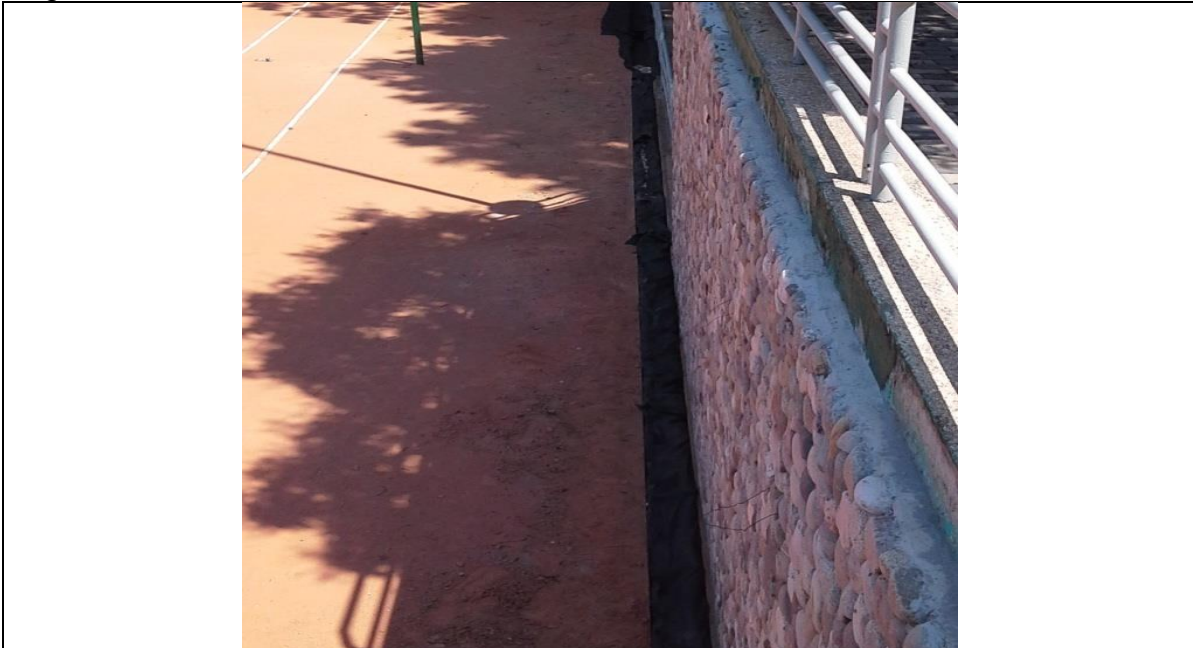
Recubrimiento geotextil en drenajes laterales.
