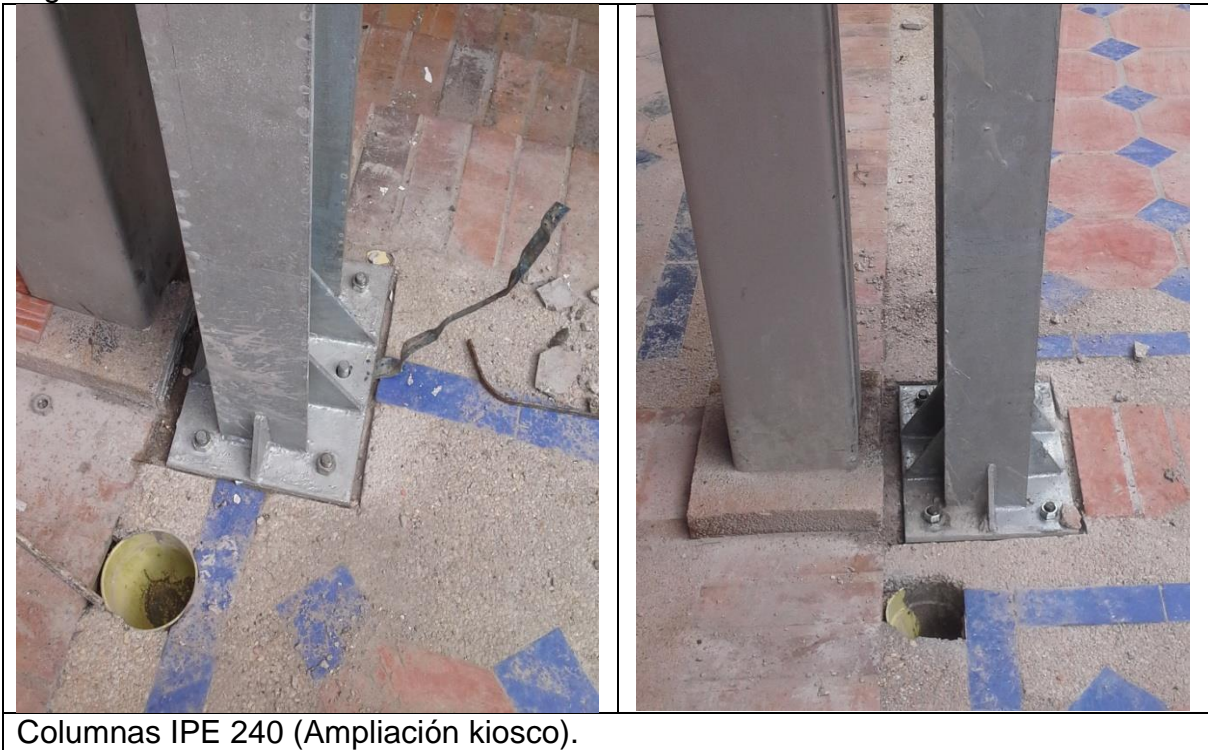
Figura 17 Columnas IPE 240
