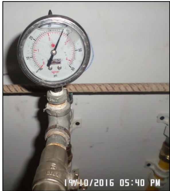
Imagen 27. Segunda toma de presión (prueba en local 3)
