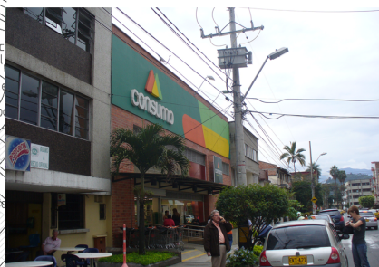
7 TIPOLOGIA EDIFICATORIA BAJA DENSIDAD - COMERCIAL.
