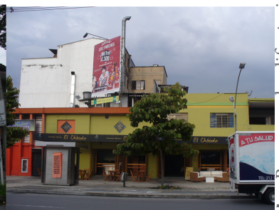
9 TIPOLOGIA EDIFICATORIA BAJA DENSIDAD - COMERCIAL.
