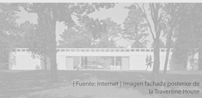
[ Fuente: Internet ] Imagen desde exterior de la Travertine House
