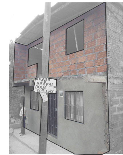
▶ MATERIAL 2 [ Fuente: Elaboración propia ] Viviendas nuevas en bloques cerámicos + revoque concreto
