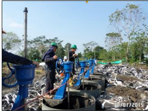
Figura 19: Instalación de compuertas.
