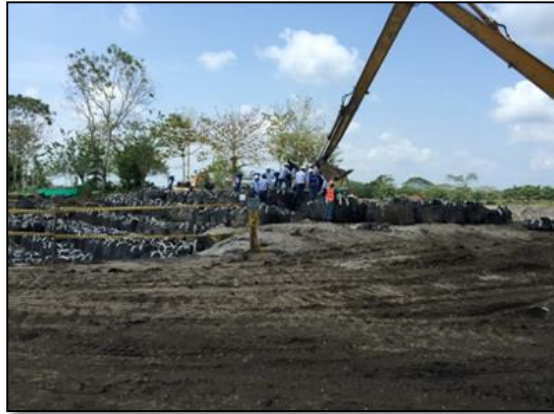
Figura 17: instalación de geobolsas.
