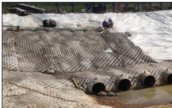
Figura 18: Estructura de control, entrada Bocatoma.
