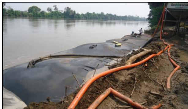
Figura 16: Instalación de Geotubos para la protección de orilla.
