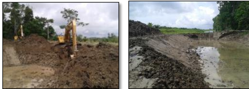
Figura 20. Excavación de canal de conexión.
