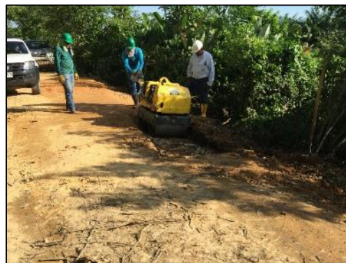
Figura 25. Mantenimiento vía de acceso a la Bocatoma.
