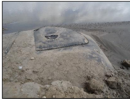
Figura 24. Parche de reparación del Geotubo.
