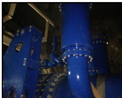
Figura 5. Válvula Mariposa Emergencia DN1400 PN16
